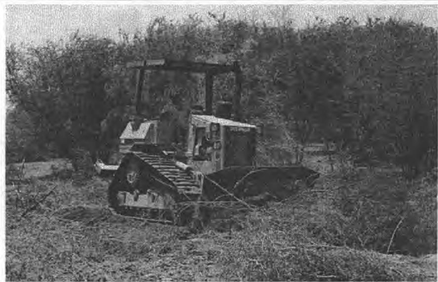
Foto 2.5 Tractor buldozer desmontando
