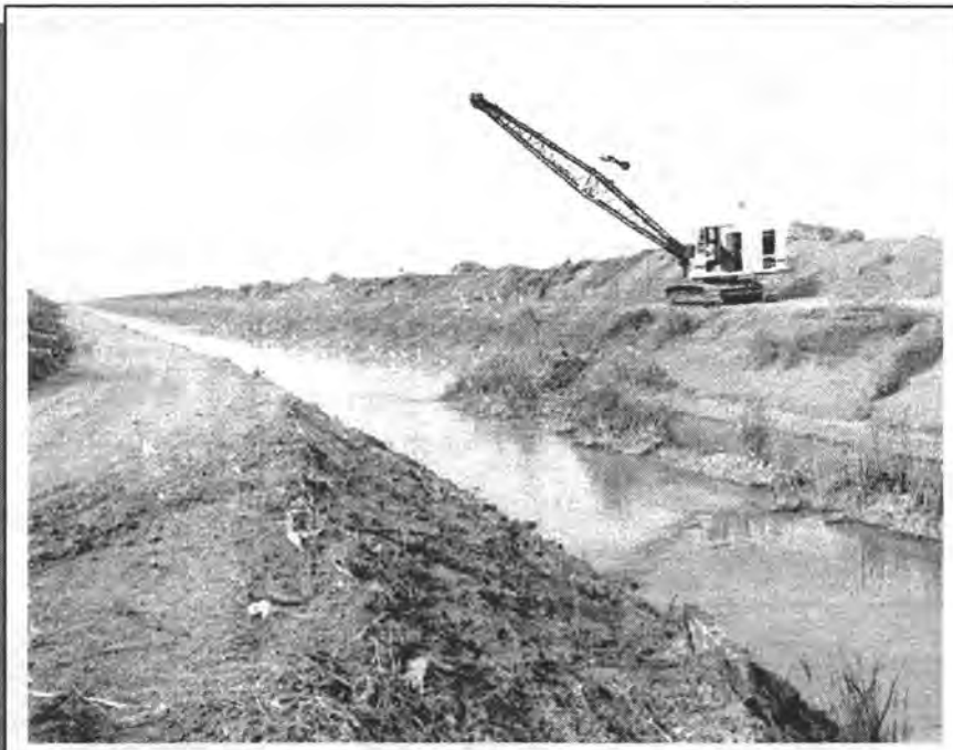
Foto 3.3. Conservación red de drenaje.
