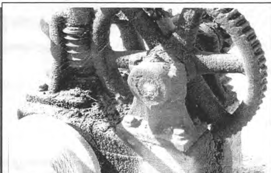
Foto 3.8. Mecanismo elevador con necesidades de mantenimiento.
