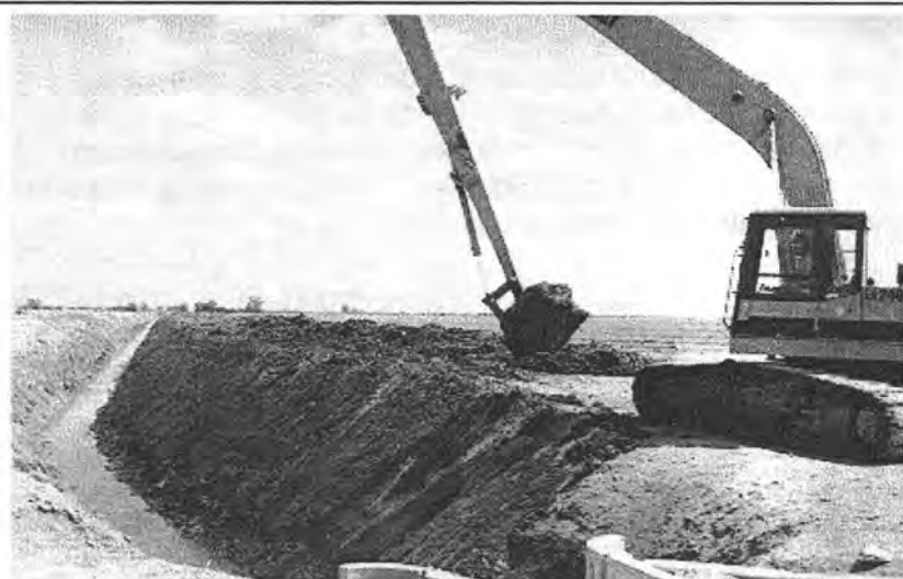
Foto 2. 4 Excavadora sobre orugas desazolviendo un dren
