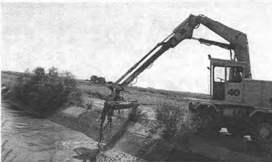
Foto 2. 3 Excavadora sobre neumáticos desazolviendo canal revestido
