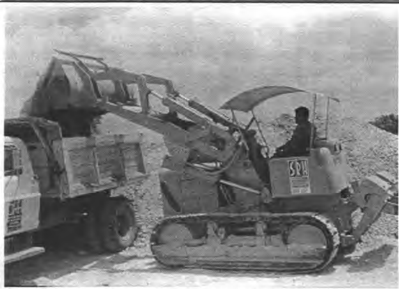
Foto 2.7 Cargador frontal trabajando en un banco de préstamo
