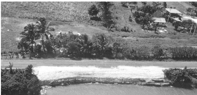
Foto 20. Costalera de cemento para proteger el bordo de encauzamiento.
