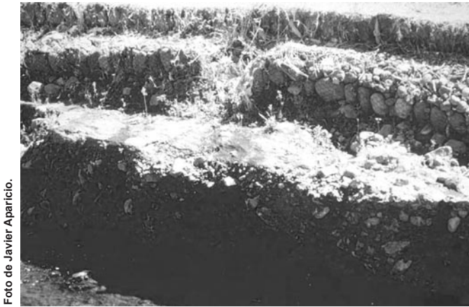
Fotos 11 y 12. Efectos de erosión del fondo.
