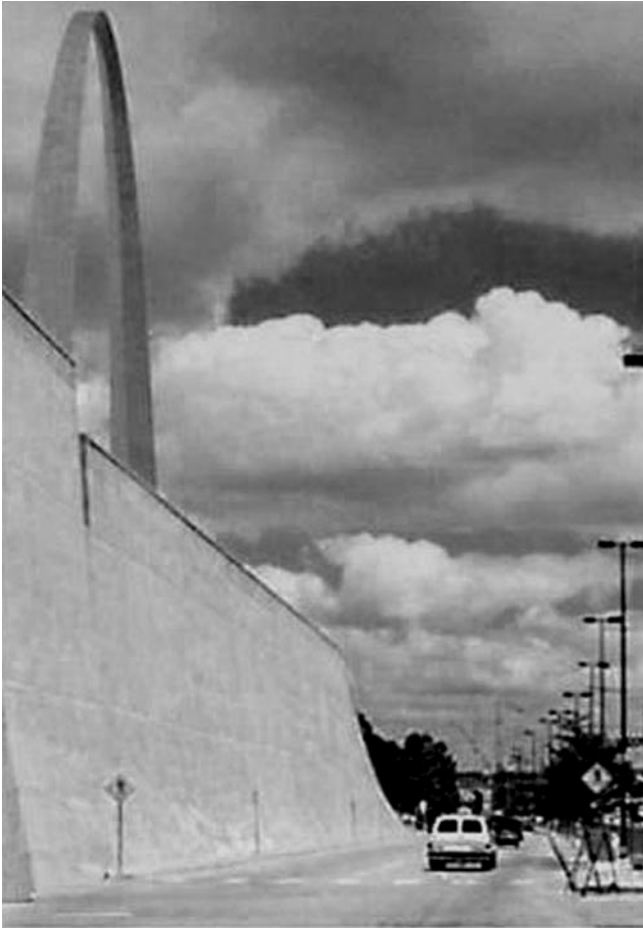
Foto 31. Muro de encauzamiento en San Luis Missouri (Johnson et al., 2003).
