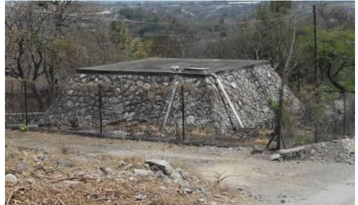
Figura 14. Viejo tanque de depósito de agua potable.
