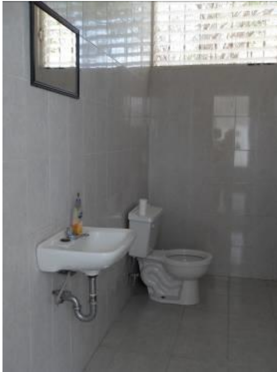
Figura 2.14. Baños en oficinas del CAIC
