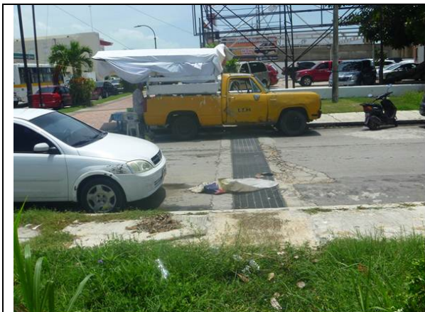
Boca de tormenta con basura arrojada en vía pública y azolvada
