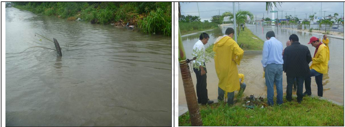
Ilustración 2.1. Drenaje deficiente en la vía pública (IMTA, 2013)
