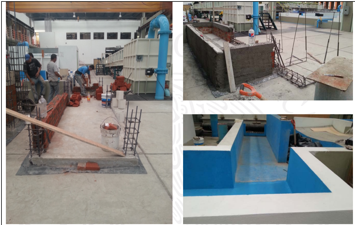
Ilustración 5.3 Proceso constructivo del conducto de descarga
