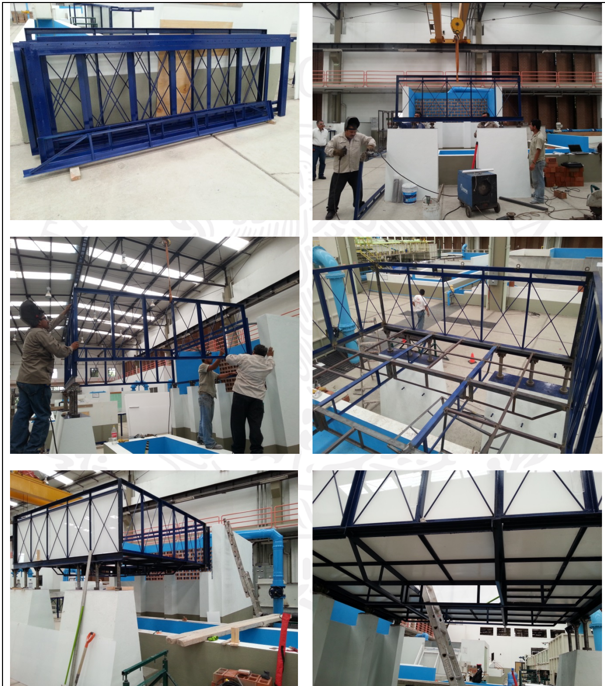
Ilustración 5.2 Proceso constructivo del tanque de análisis
