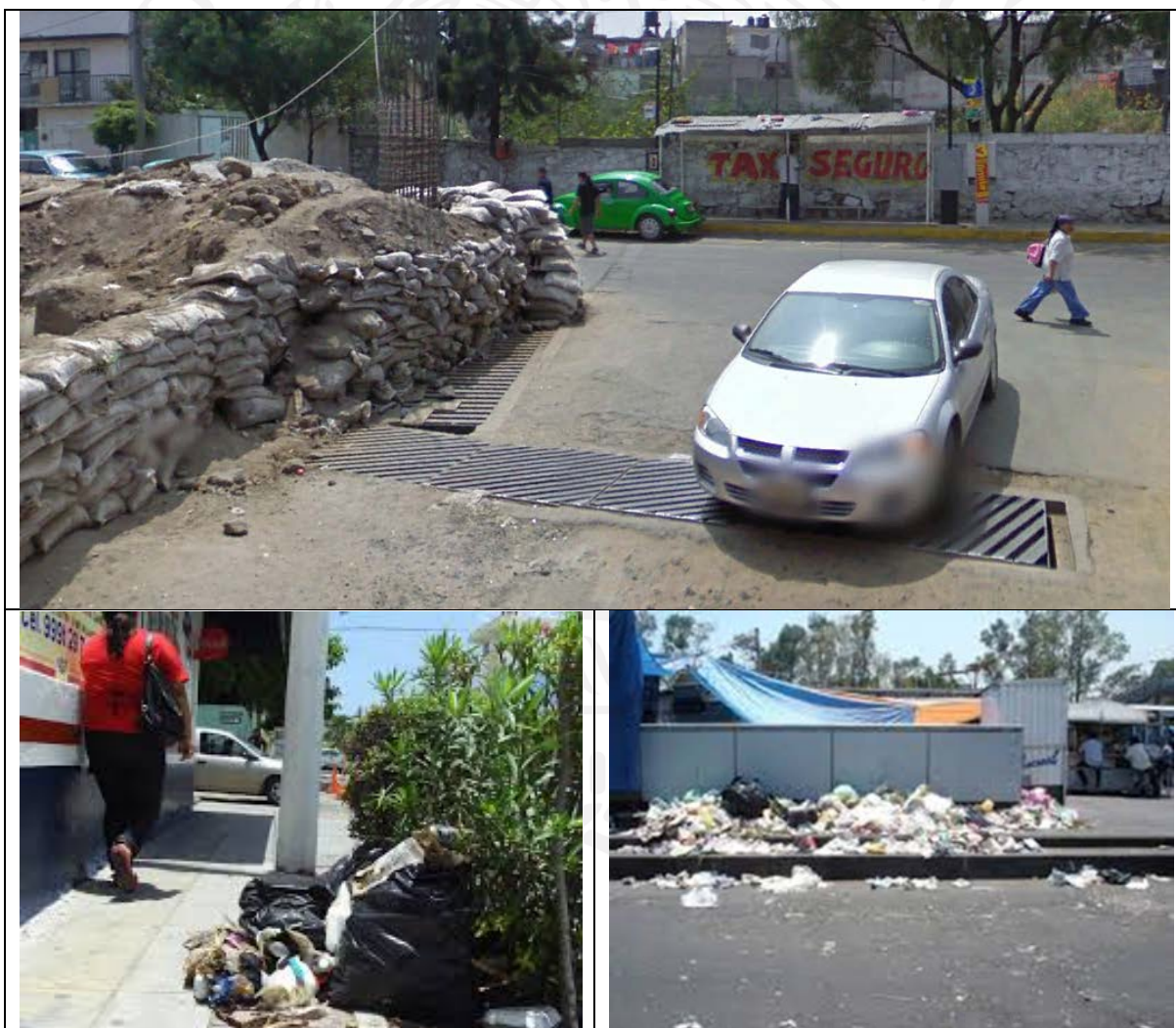
Ilustración 4.15 Problemática para la infraestructura de alcantarillado
