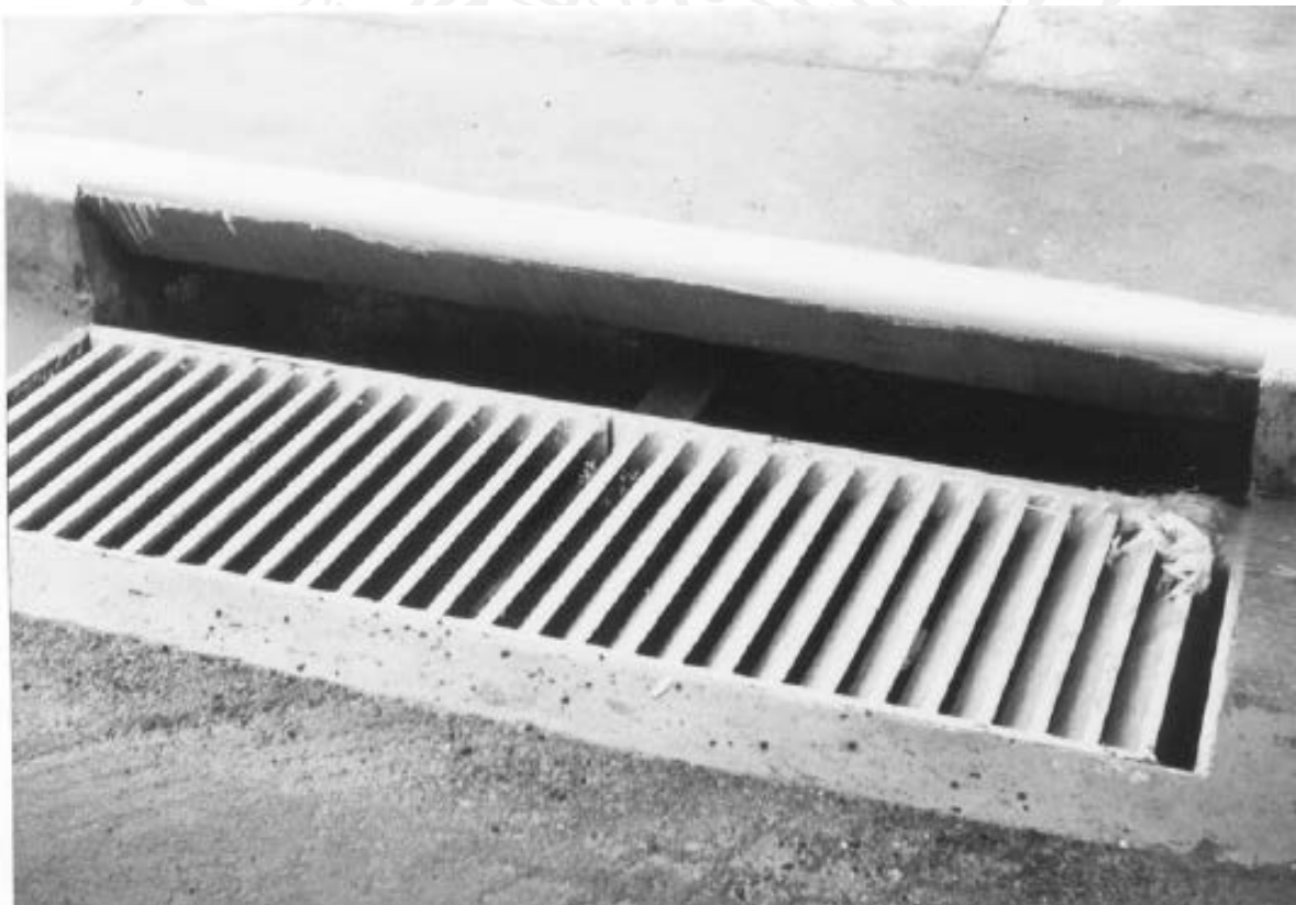
Ilustración 3.24 Coladera combinada con rejillas inclinadas a 45°
