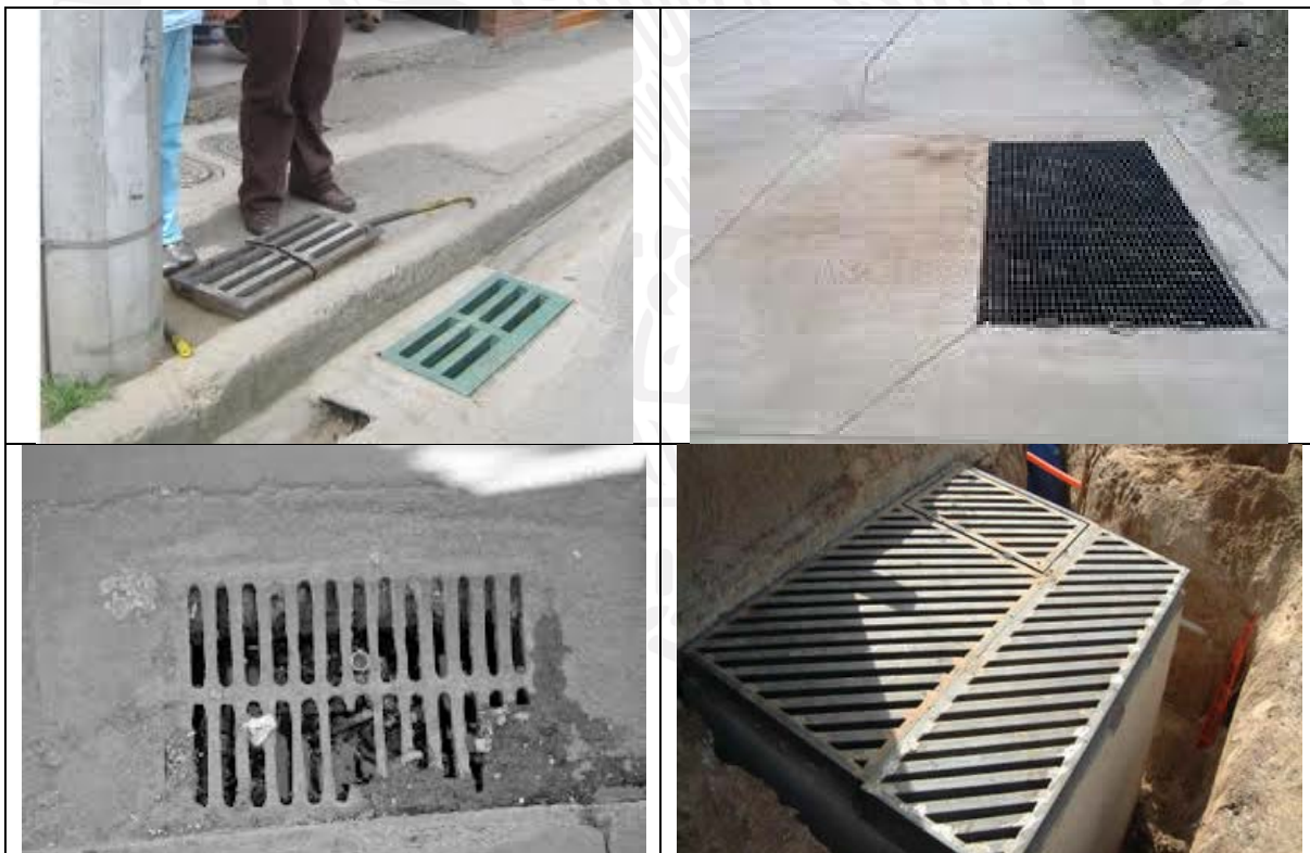
Ilustración 4.11 Ejemplo de bocas de tormenta de piso
