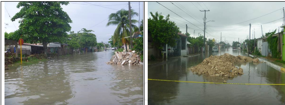
Material de cascajo o demolición de muros
