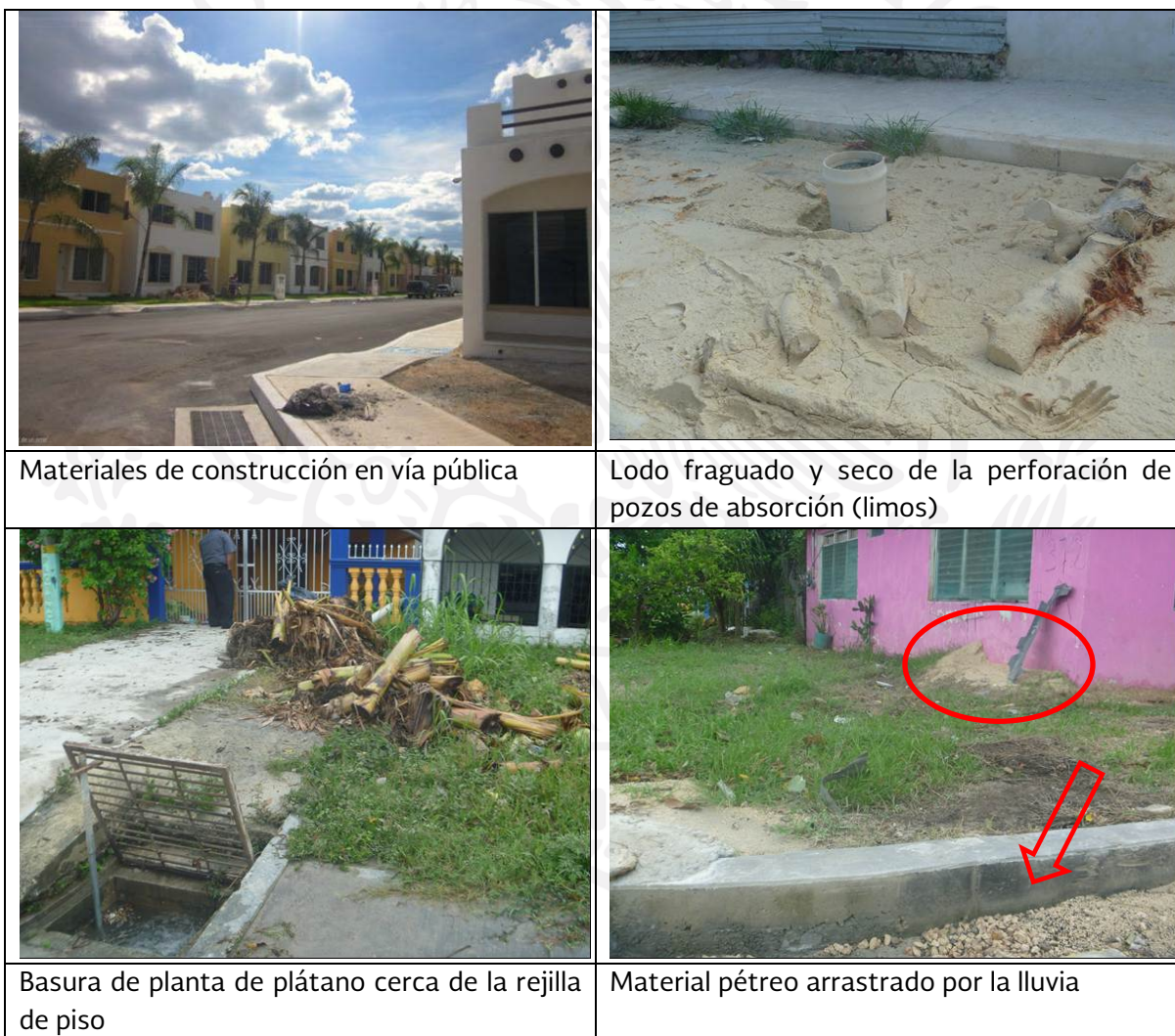
Ilustración 2.3. Problemas con el depósito de materiales sobre banquetas y calles
