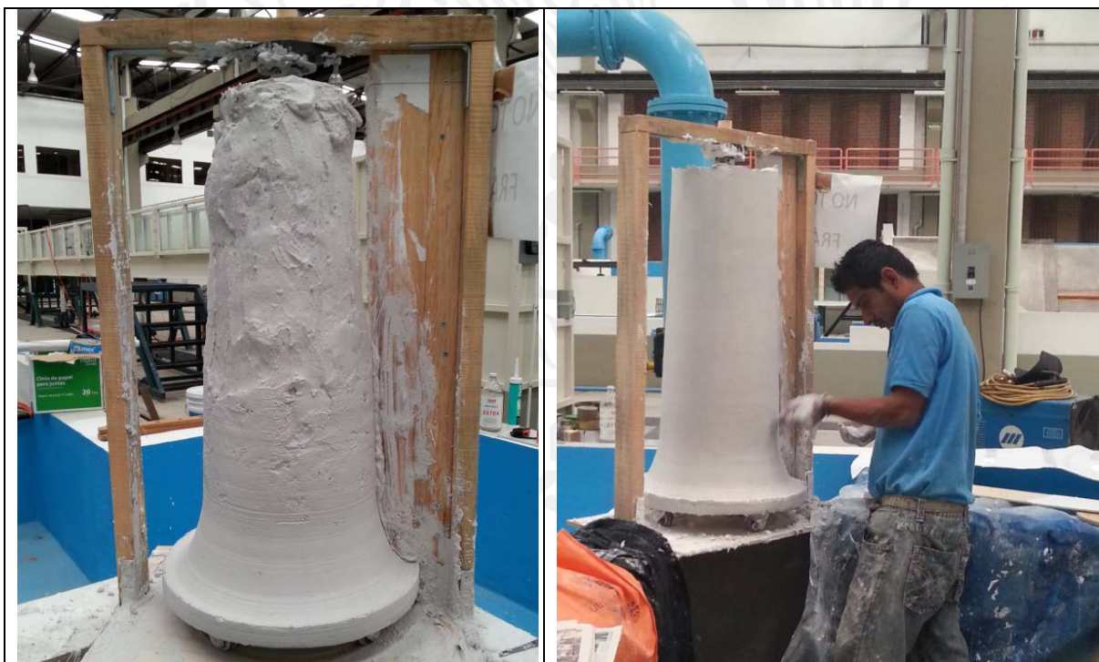
Ilustración 5.8 Proceso constructivo del molde para la boca de tormenta tipo embudo
