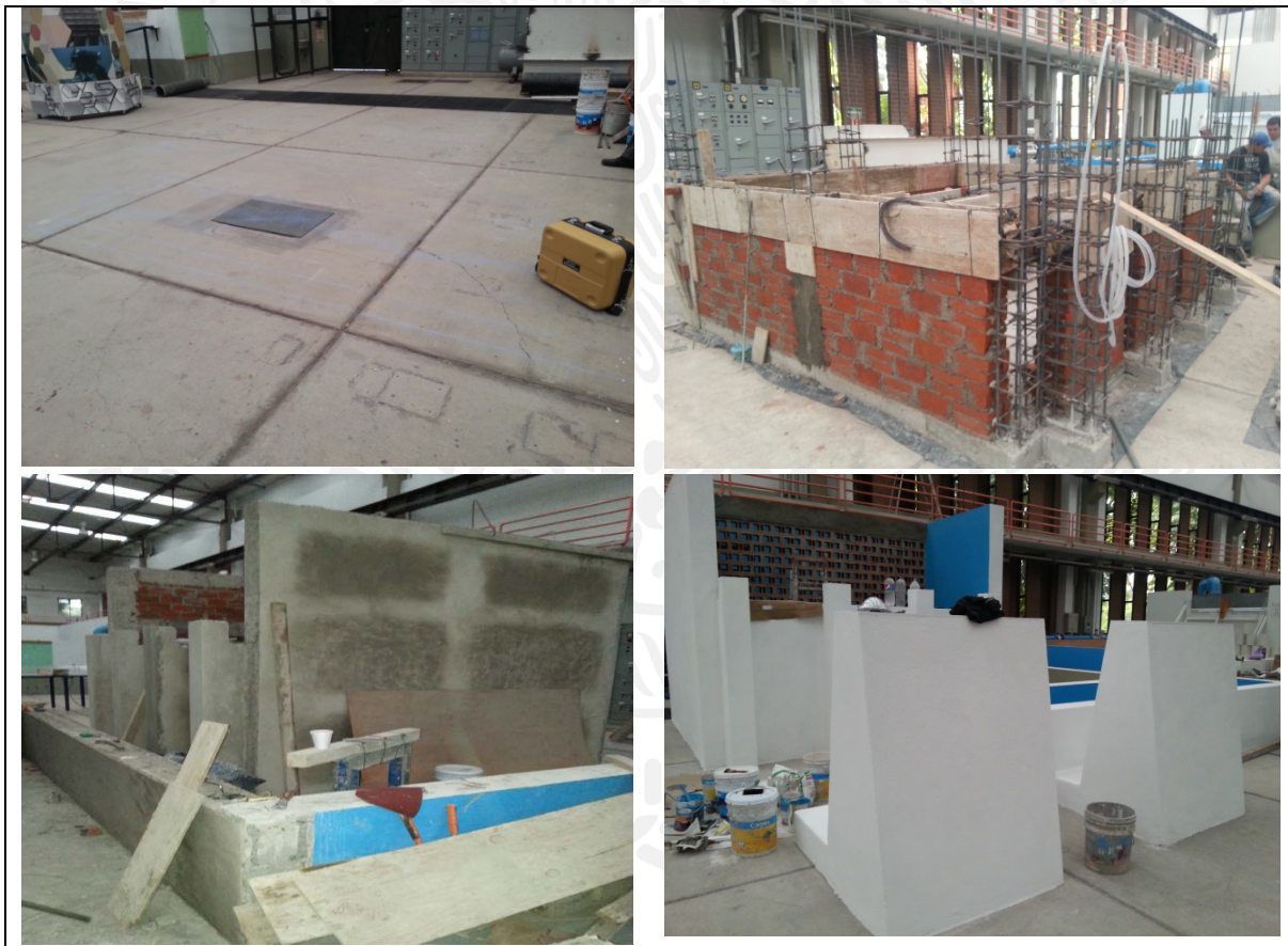
Ilustración 5.1 Proceso constructivo del tanque de amortiguamiento
