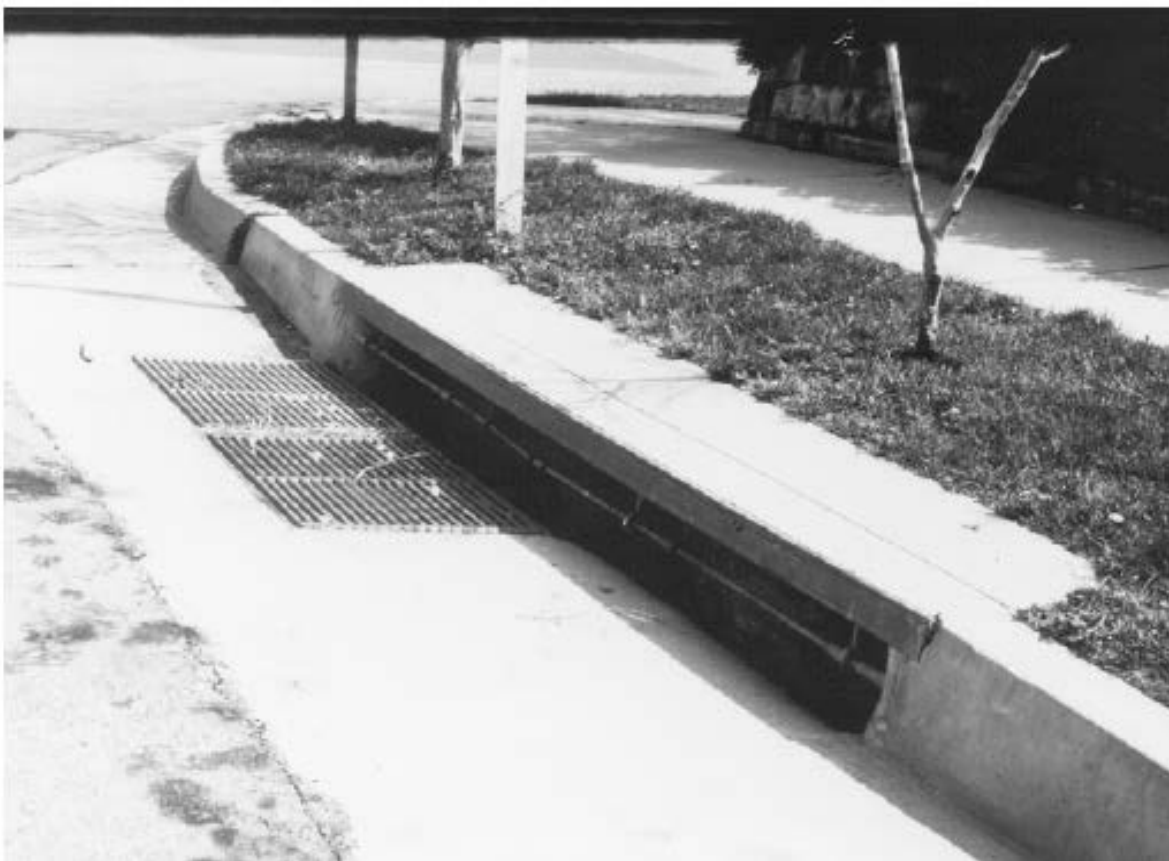
Ilustración 3.25 Coladera combinada desfasada
