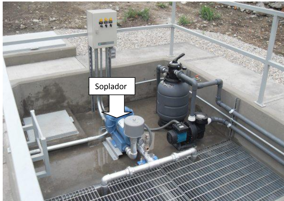
Figura 3.4 Foto de soplador y red de tuberías de aire
