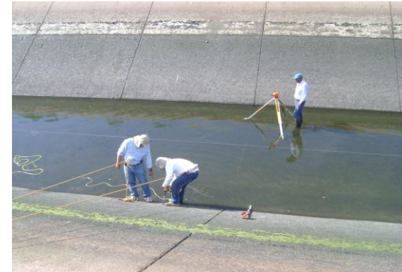
Foto 2.1 Sitio "A", donde se instalará el AD.
