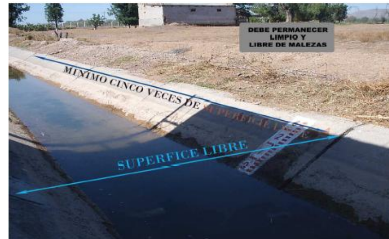
Figura 7. Conservación de la obra civil
