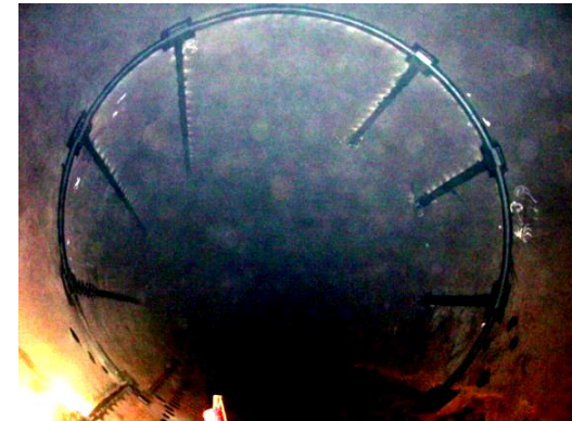
Foto 2 Instalación ATT4 en la CH de Chicoasén (CFE/IMTA, 2006)
