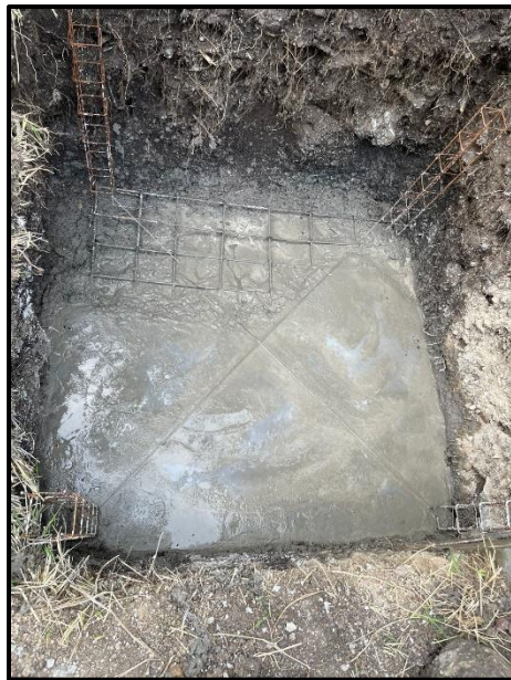
Figura 63: Firme de concreto
