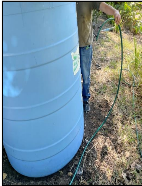
Figura 69: Instalación de tinaco en la parte alta.
