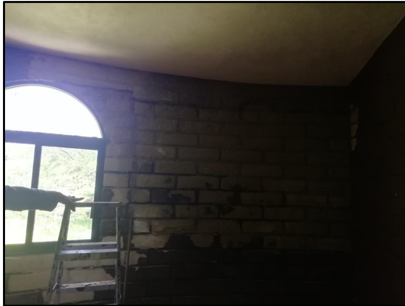
Figura 11: Proceso de reparación del cuarto secundario
