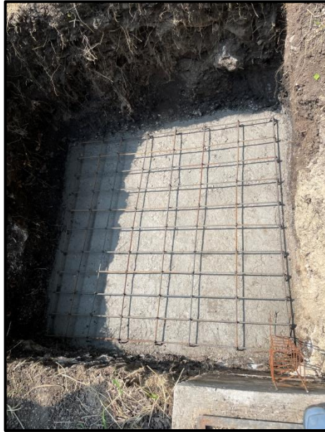
Figura 62: Armado de parrilla
