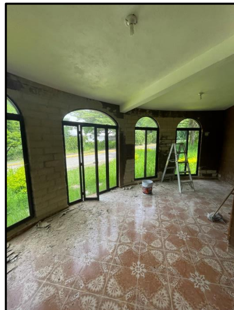
Figura 7: Retiro de material dañado en el área de cocina, comedor y sala.
