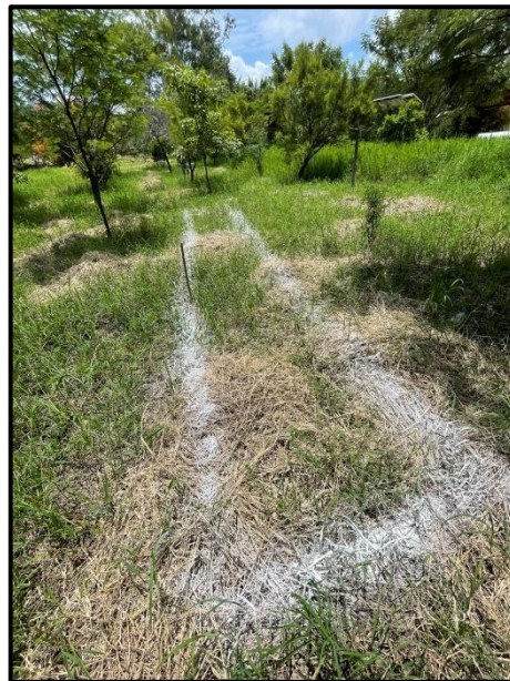
Figura 53: Trazo de primer zanja.
