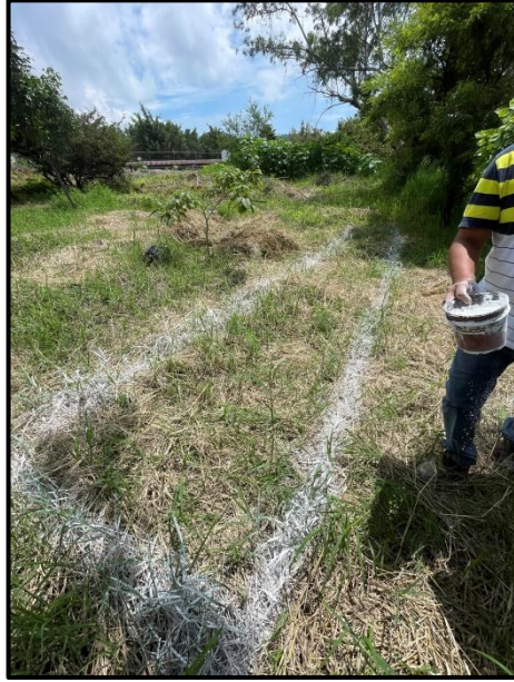
Figura 54: Trazo de segunda zanja.
