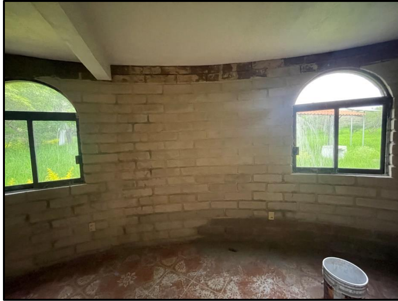
Figura 13: Reparación de muro de recamara principal terminado.
