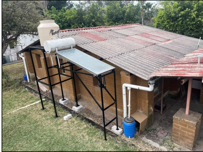
Figura 84: Instalación de calentador solar y tinaco en estructura metálica.
