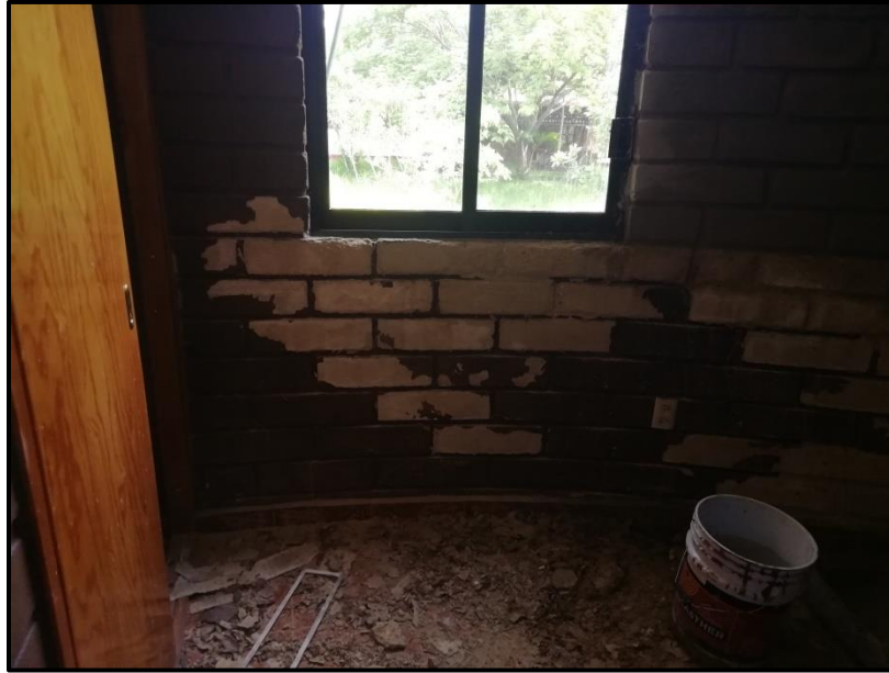
Figura 6: Retiro de material dañado del muro de cuarto secundario
