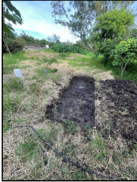
Figura 56: Excavación segunda zanja.
