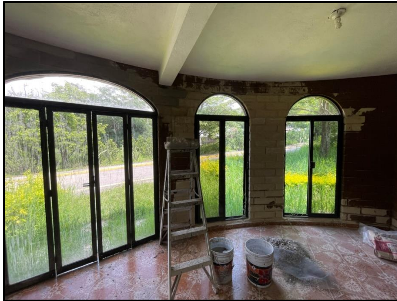
Figura 17: Proceso de reparación del Muro
