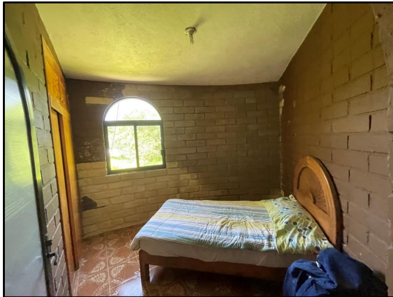
Figura 14: Reparación de recamara secundaria terminado.
