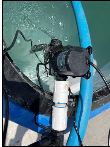
Figura 68: Instalación de bombas
