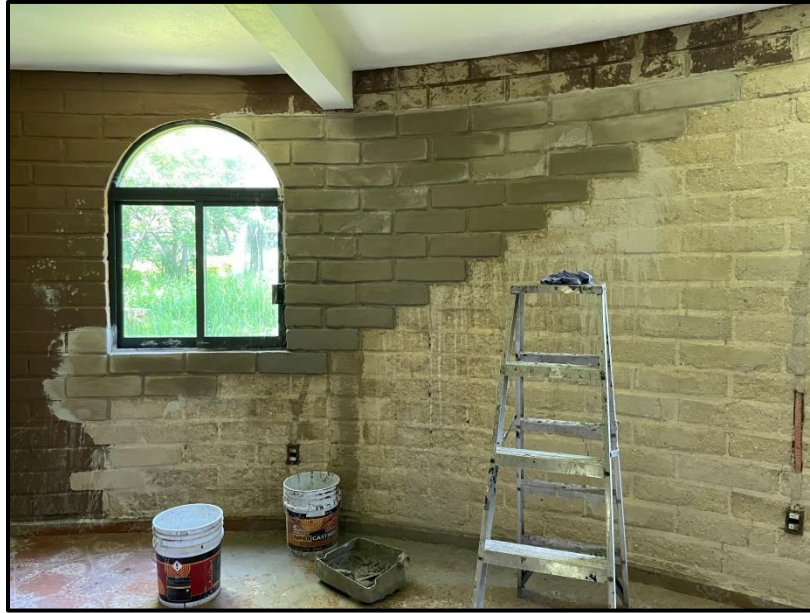
Figura 9: Reparación de muro en recamara principal.
