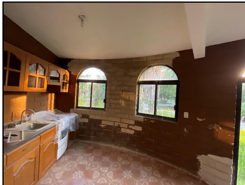
Figura 16: Muro del área de cocina reparado.
