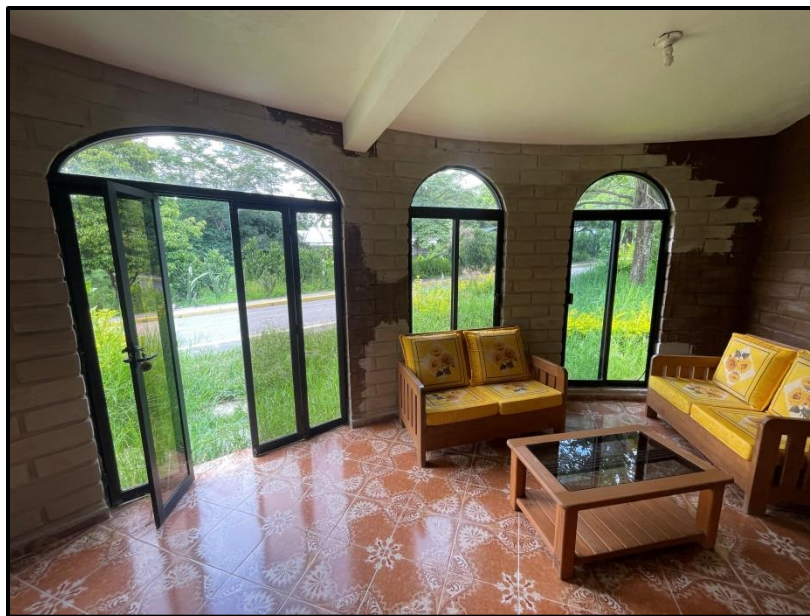
Figura 18: Reparación finalizada de muros en área sala comedor.
