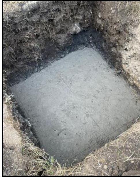
Figura 61: Plantilla de concreto pobre
