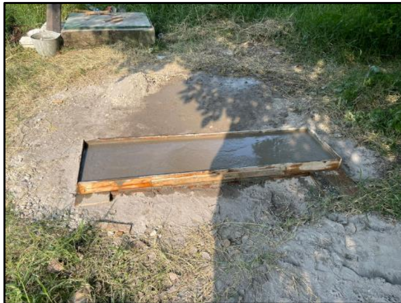
Figura 65: Tapas de concreto para registro
