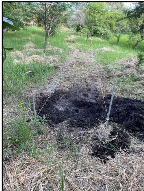
Figura 55: Excavación primer zanja
