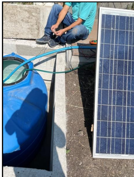
Figura 67: Prueba de instalación de celda con bombas y sensores de nivel
