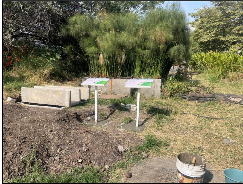
Figura 80: Instalación de infografías
