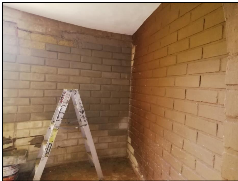
Figura 12: Reparación de block aparente en recamara secundaria.
