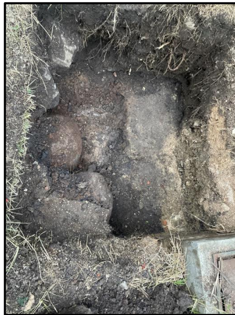
Figura 60: Excavación para registro.
