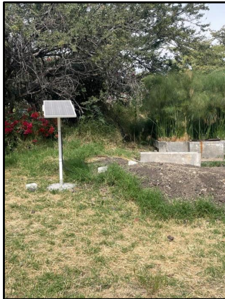
Figura 66: Instalación de celda solar
