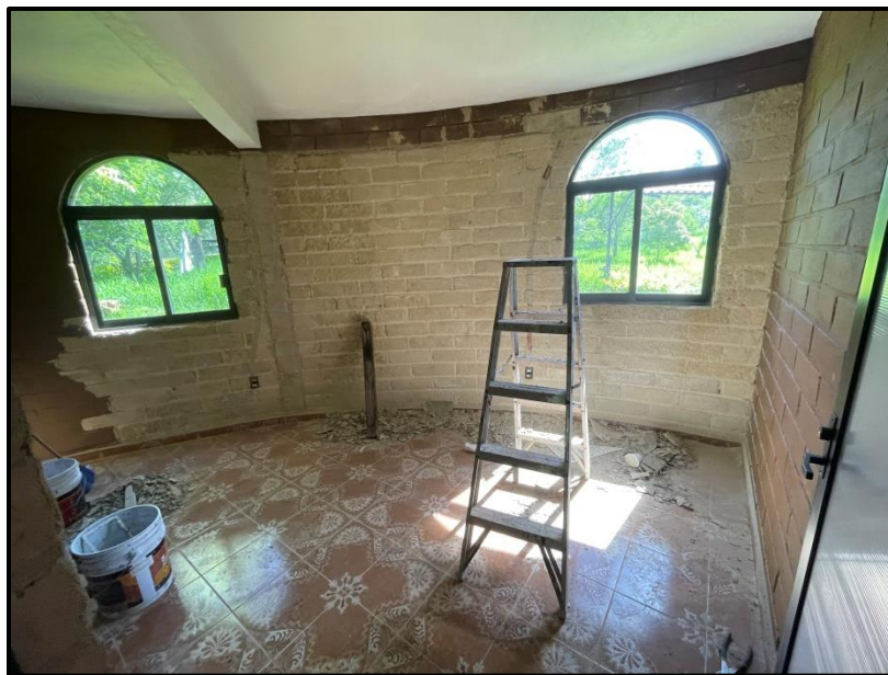
Figura 5: Retiro de material dañado del muro en cuarto principal
