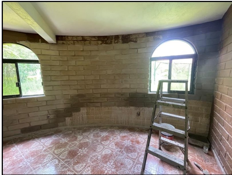
Figura 10: Proceso de reparación del muro.
