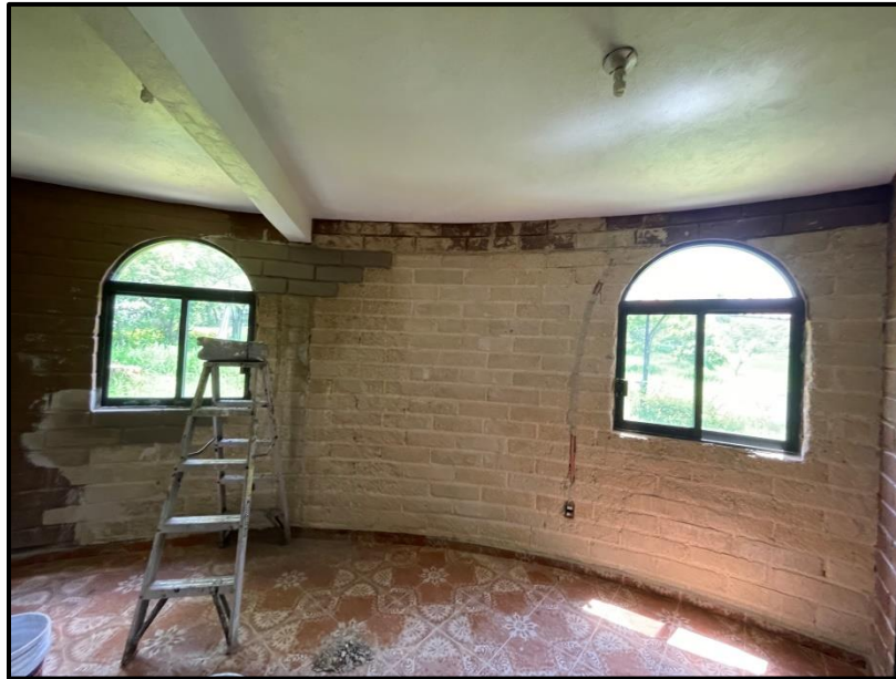
Figura 8: Inicio de reparación de muros.
