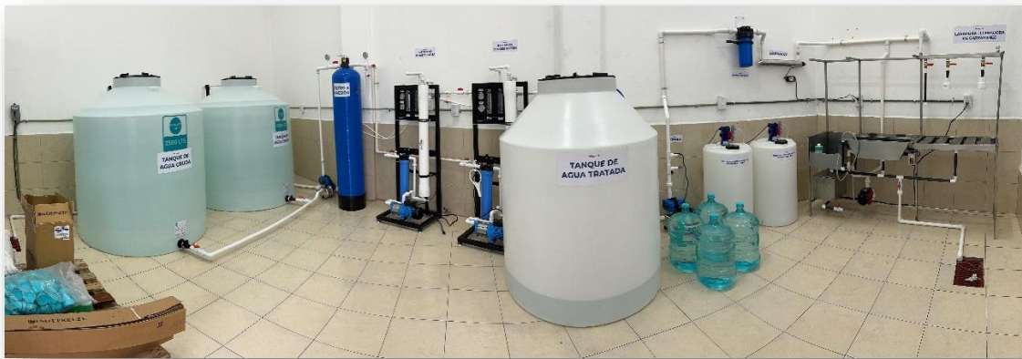
Figura 4. Entrega de manual de operación de la planta purificadora.
