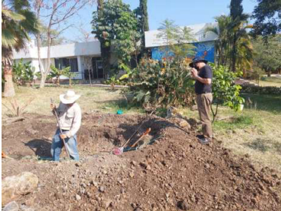
Figura 3.49. Excavación del bio-abrevadero.
