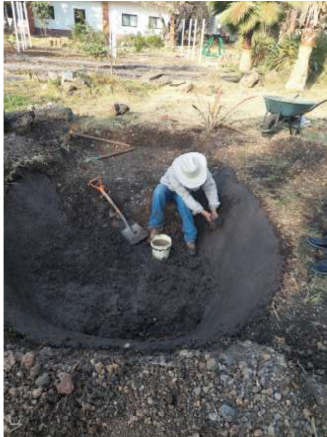
Figura 3.51. Repellado del bio-abrevadero.
