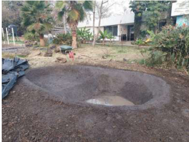
Figura 3.52. Contorno del bio-abrevadero terminado.
