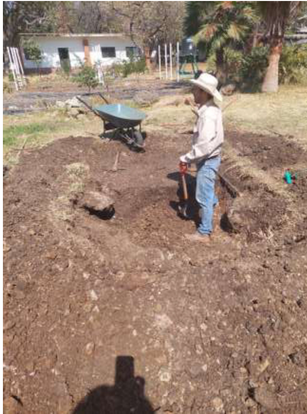
Figura 3.50. Extracción de rocas en la excavación.
