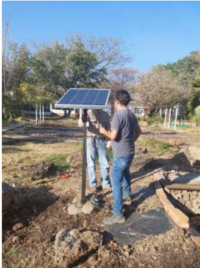
Figura 3.55. Instalación del sistema de bombeo fotovoltaico.
