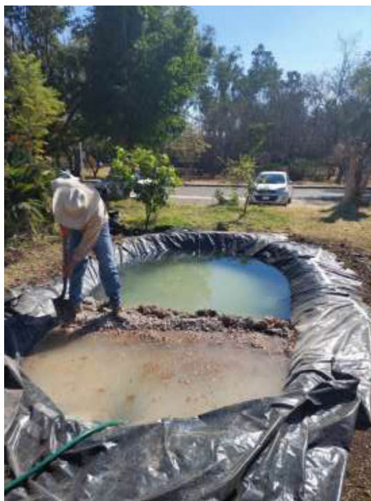
Figura 3.53. Colocación del plástico, piedras y arena en la parte superior del bio-abrevadero.
