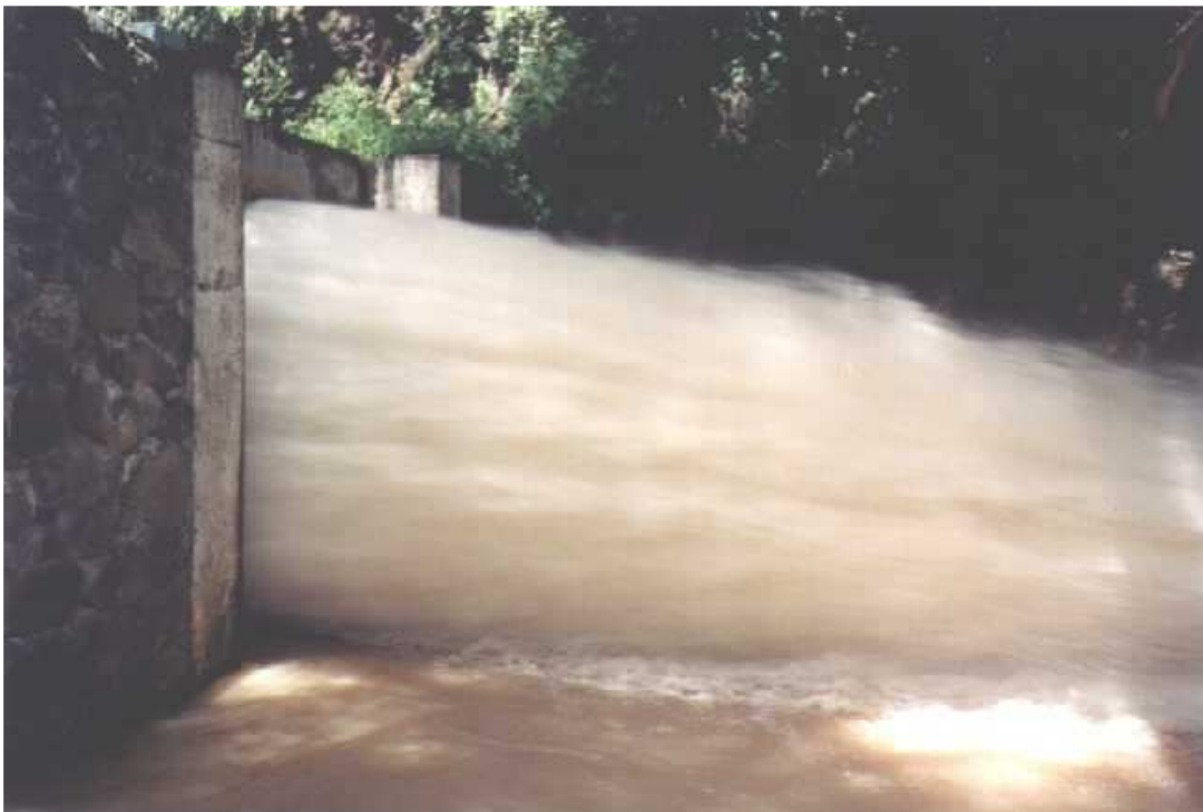
Foto 6. Descarga de la obra de toma.
