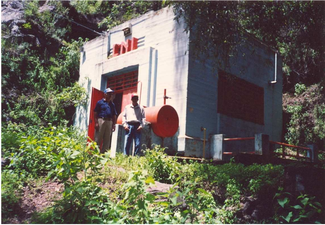
Foto 5. Entorno exterior de la casa de operación.
