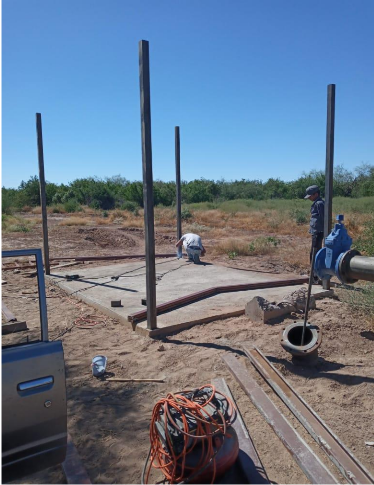
CONSTRUCCIÓN DE BASE DE CONCRETO
