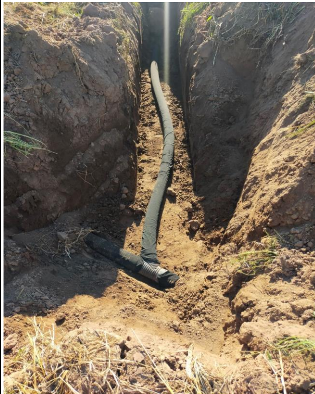
INSTALACIÓN DEL SISTEMA DE DRENAJE EN LA PARCELA DENOMINADA FIG. 5.1 DE 48.80 HA Y 5.3B DE 35.60 HA
