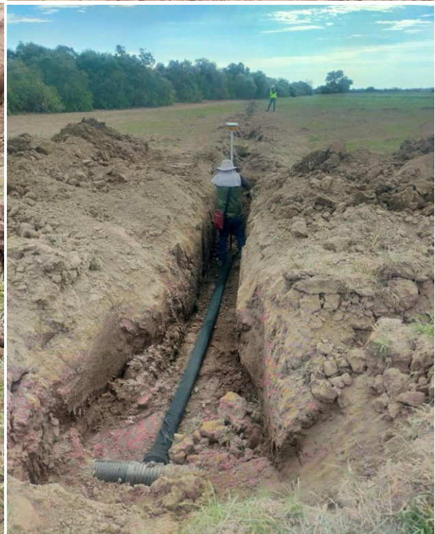
INSTALACIÓN DEL SISTEMA DE DRENAJE EN LA PARCELA DENOMINADA FIG. 5.3A1 DE 18.80 HA
