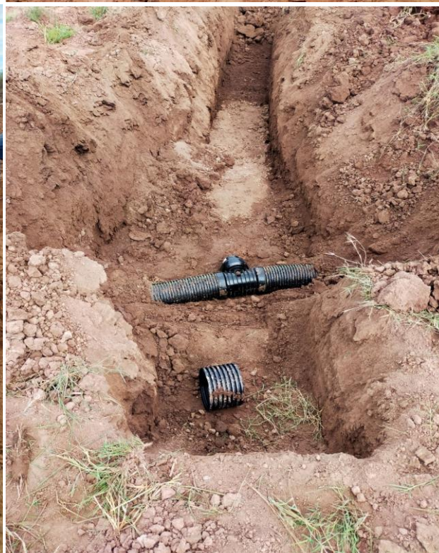
INSTALACIÓN DEL SISTEMA DE DRENAJE EN LA PARCELA DENOMINADA FIG. 5.3A1 DE 18.80 HA
