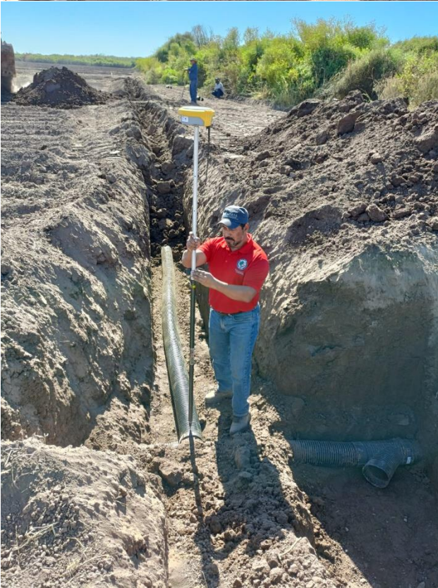
Ilustración 22. Control topográfico durante la instalación de drenaje agrícola subterráneo.
