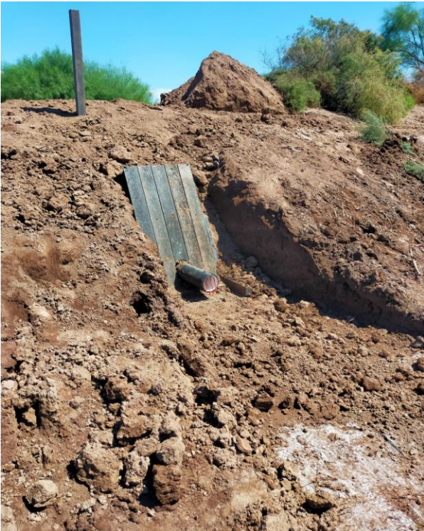
INATACIÓN DEL SISTEMA DE DRENAJE EN LA PARCELA DENOMINADA FIGURA 4.2 DR. JOSÉ ANTONIO QUEVEDO TIZNADO ( SUPERVISION EXTERNA).
