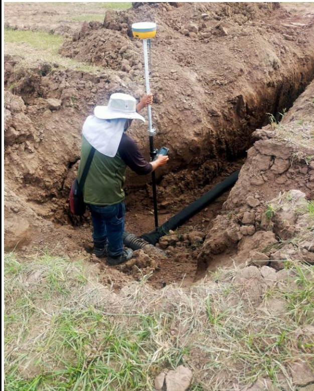
INSTALACIÓN DEL SISTEMA DE DRENAJE EN LA PARCELA DENOMINADA FIG. 5.3A1 DE 18.80 HA
