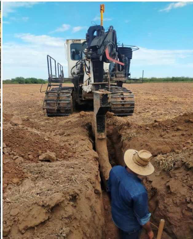
INSTALACIÓN DEL SISTEMA DE DRENAJE EN LA PARCELA DENOMINADA FIG 5.3B DE 35.60 HA
