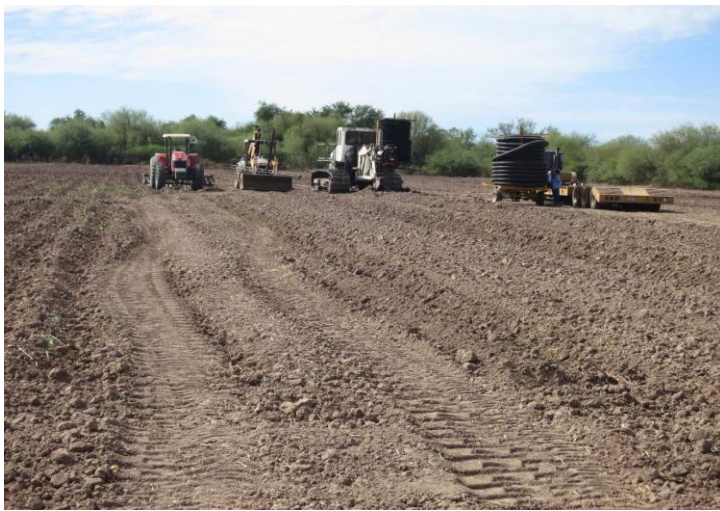
INSTALACIÓN DEL SISTEMA DE DRENAJE EN LA PARCELA DENOMINADA FIG. 5.4 DE 8.50 HA
