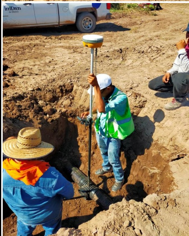
INSTALACIÓN DEL SISTEMA DE DRENAJE EN LA PARCELA DENOMINADA FIG. 5.1 DE 48.80 HA
