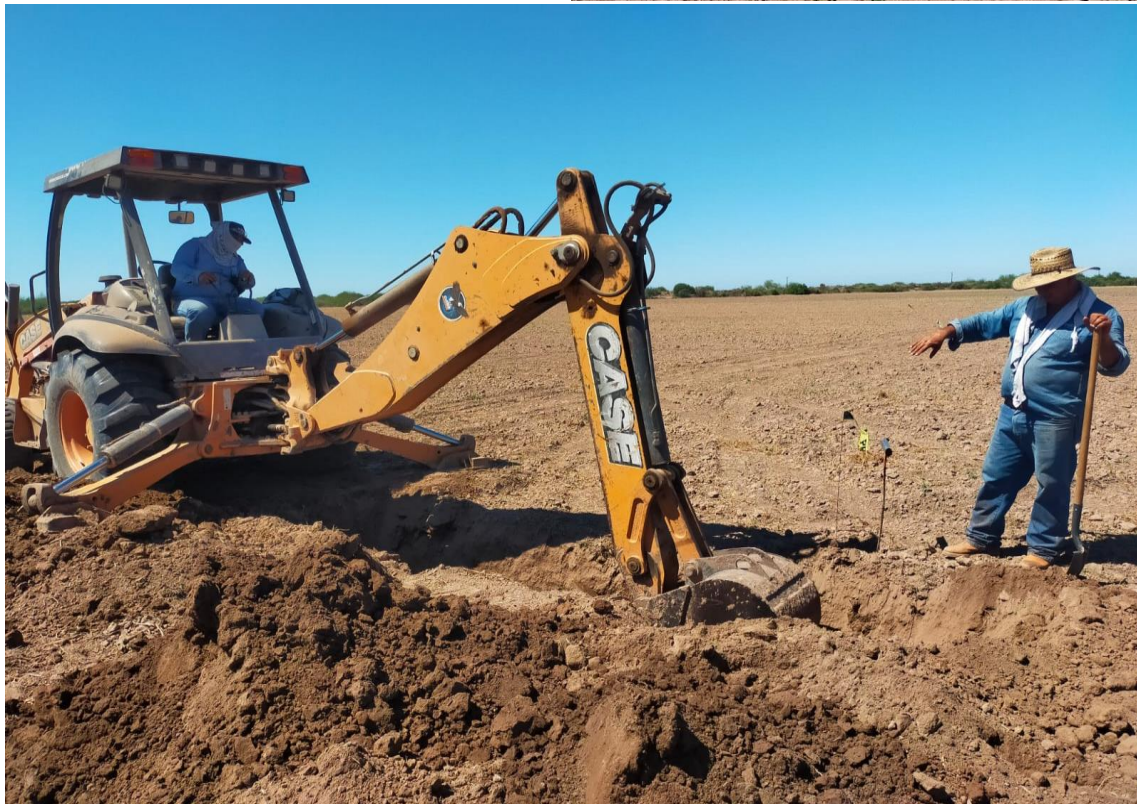
TRABAJOS DE EXCAVACIÓN EN LA PARCELA DENOMINADA FIG. 5.3 A DE 61.69 HA
