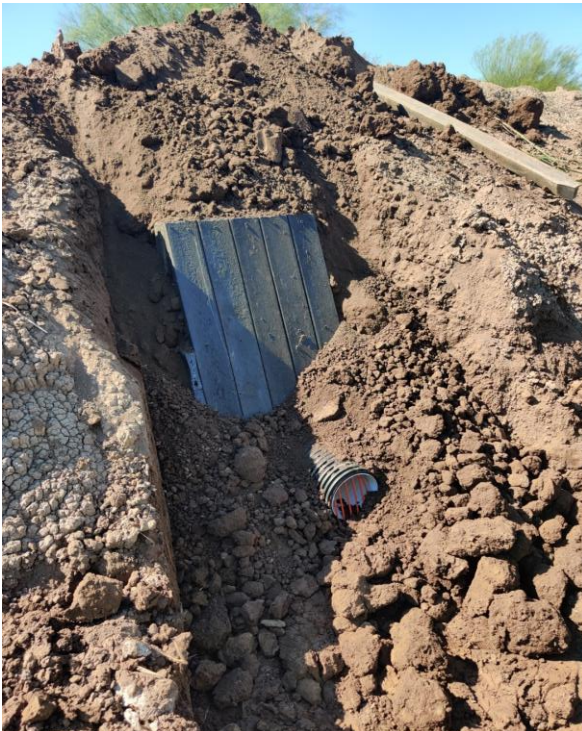
INSTALACIÓN DE SISTEMA DE DRENAJE SUBTERRÁNEO PARCELARIO EN LA FIG. 6.6B DE 38.70 HA Y 6.6A DE 38.67
