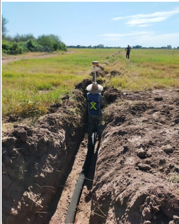
INSTALACIÓN DEL SISTEMA DE DRENAJE EN LA PARCELA DENOMINADA FIG 5.3B DE 35.60 HA Y FIG. 5.3A2 DE 33.60 HA
