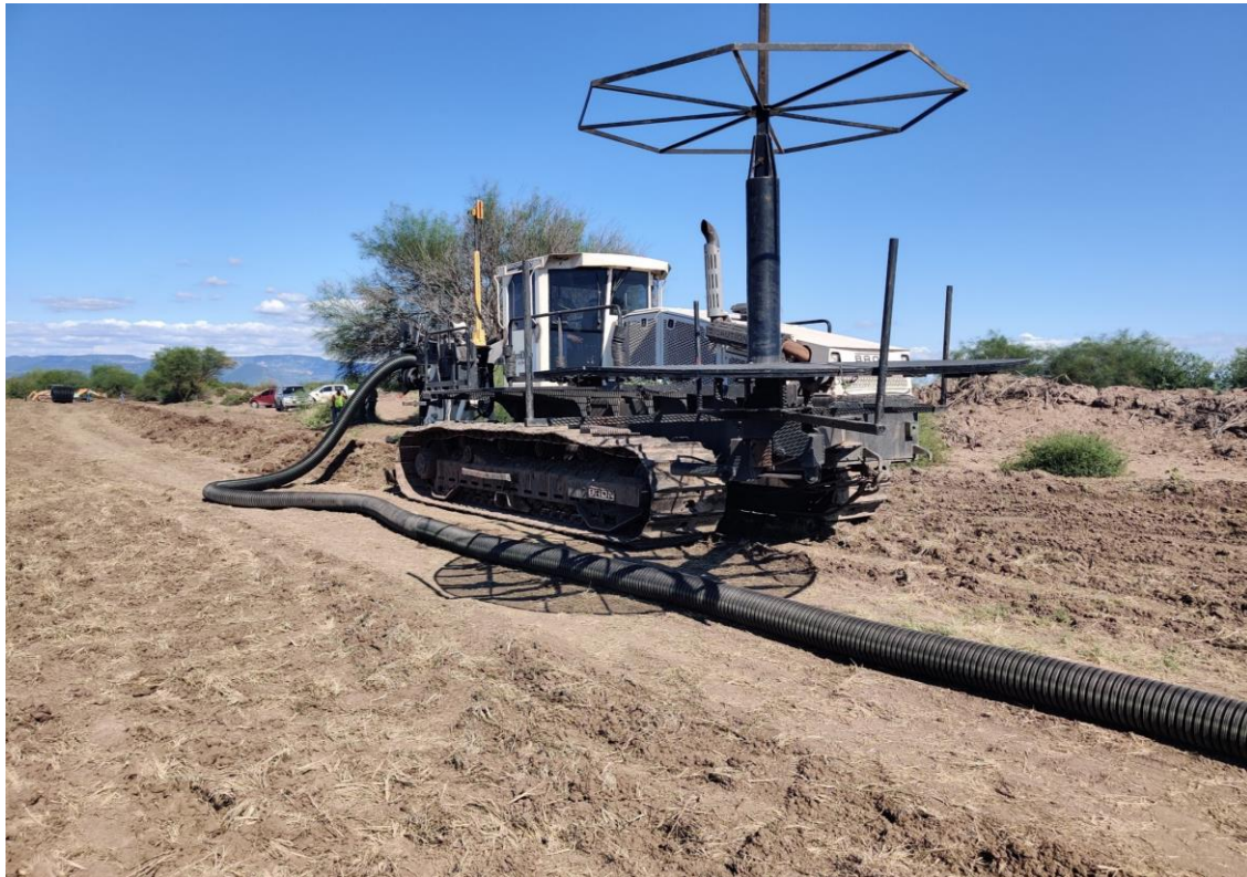
INSTALACIÓN DEL SISTEMA DE DRENAJE EN LA PARCELA DENOMINADA FIGURA 4.2 DR. JOSÉ ANTONIO QUEVEDO TIZNADO ( SUPERVISIÓN EXTERNA).
