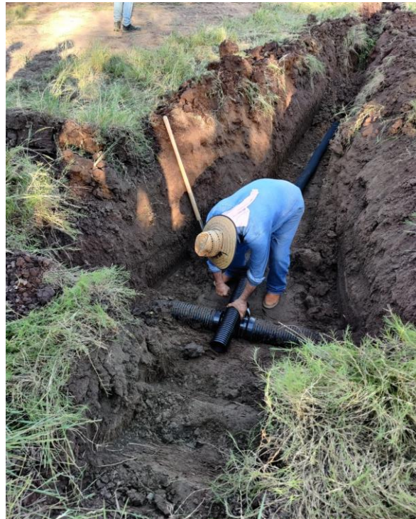
INSTALACIÓN DE SISTEMA DE DRENAJE SUBTERRÁNEO PARCELARIO EN LA FIG. 6.6B DE 38.70 HA Y 6.6A DE 38.67
