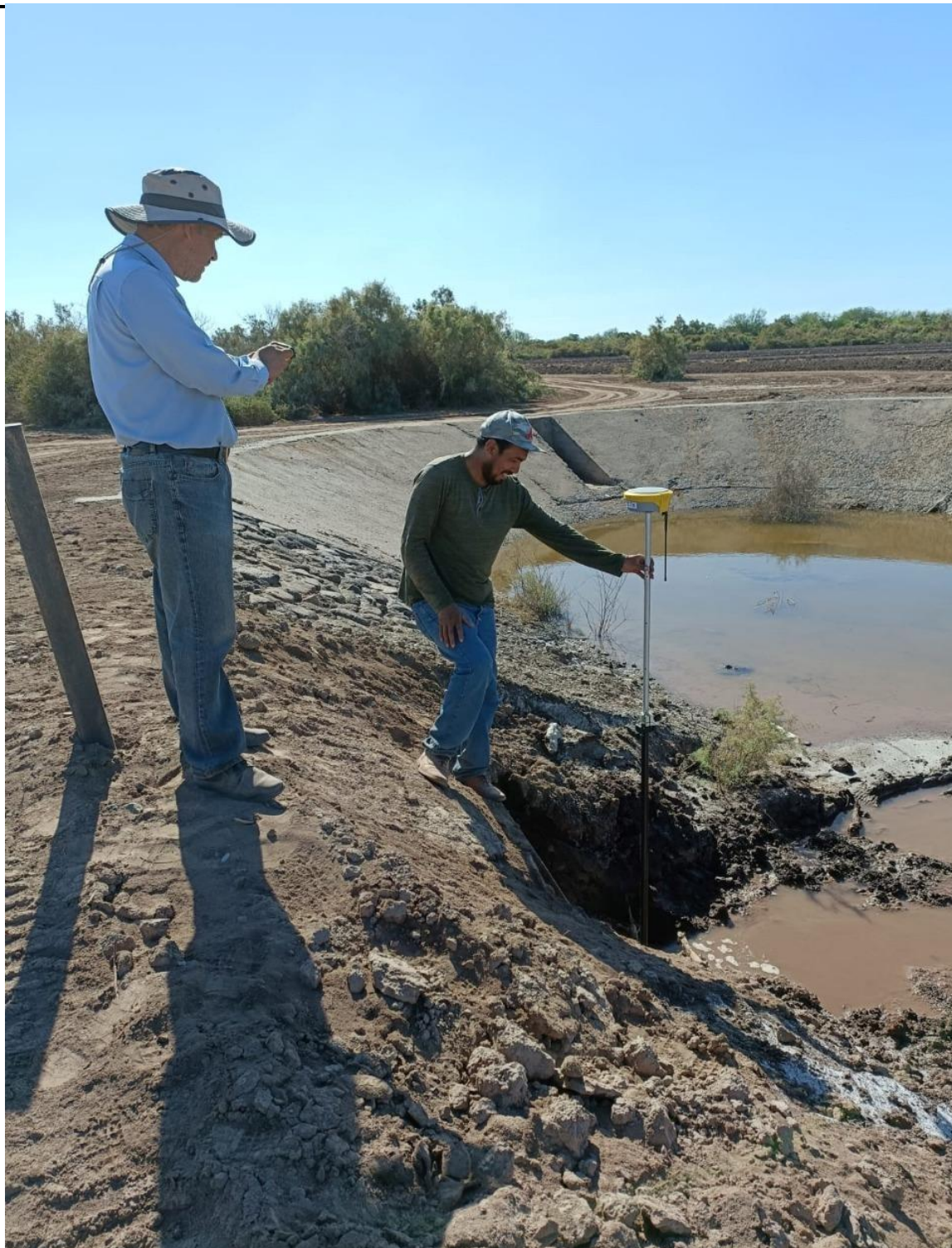
CONTROL TOPOGRÁFICO EN AMPLIACIÓN DE PARCELA 4.1C
