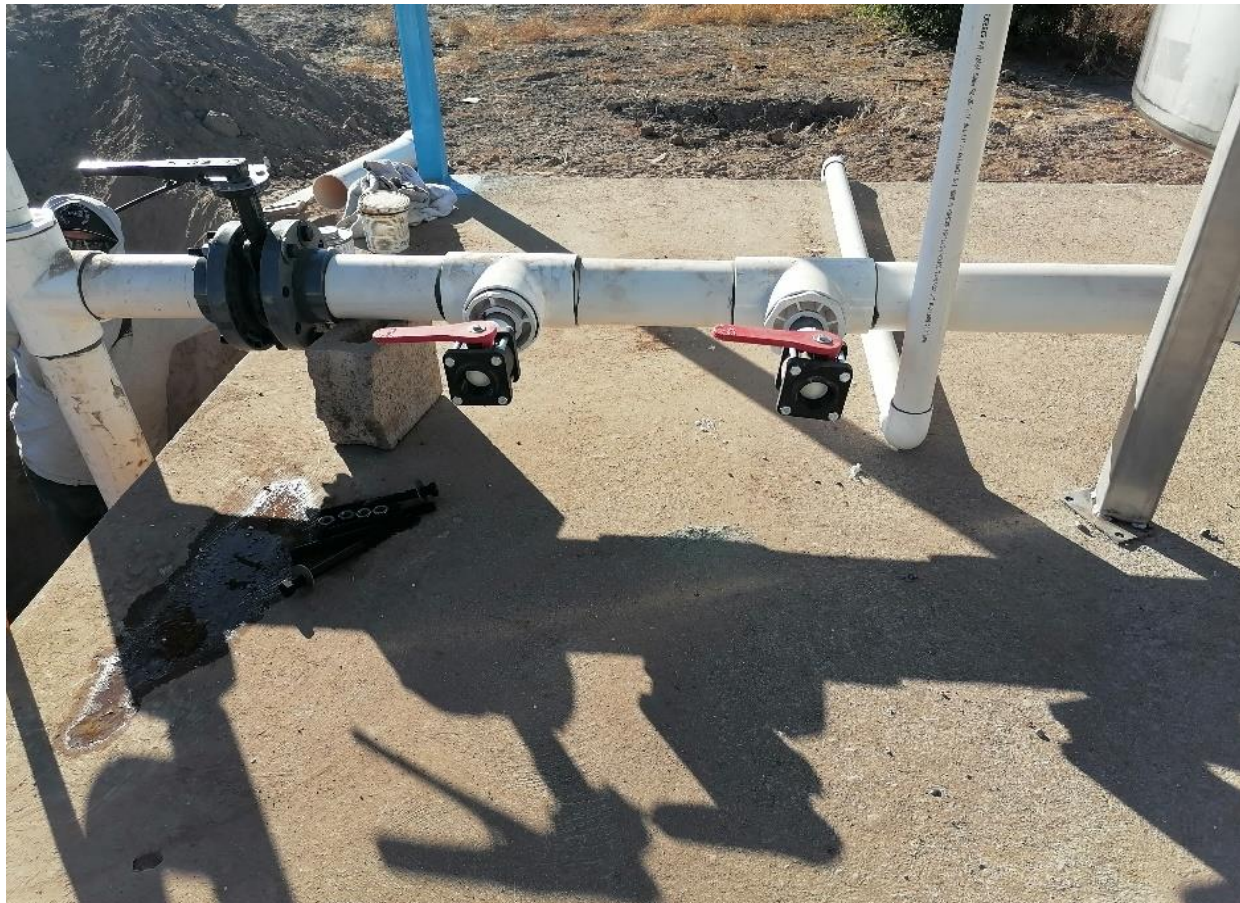
INSTALACIÓN DE ACCESORIOS DR. JOSÉ ANTONIO QUEVEDO TIZNADO ( SUPERVISION EXTERNA).
