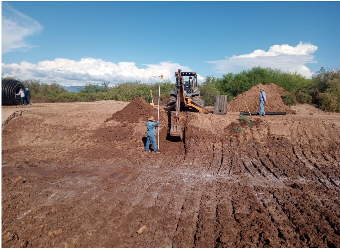
INATALACIÓN DEL SISTEMA DE DRENAJE EN LA PARCELA DENOMINADA FIGURA 4.1
