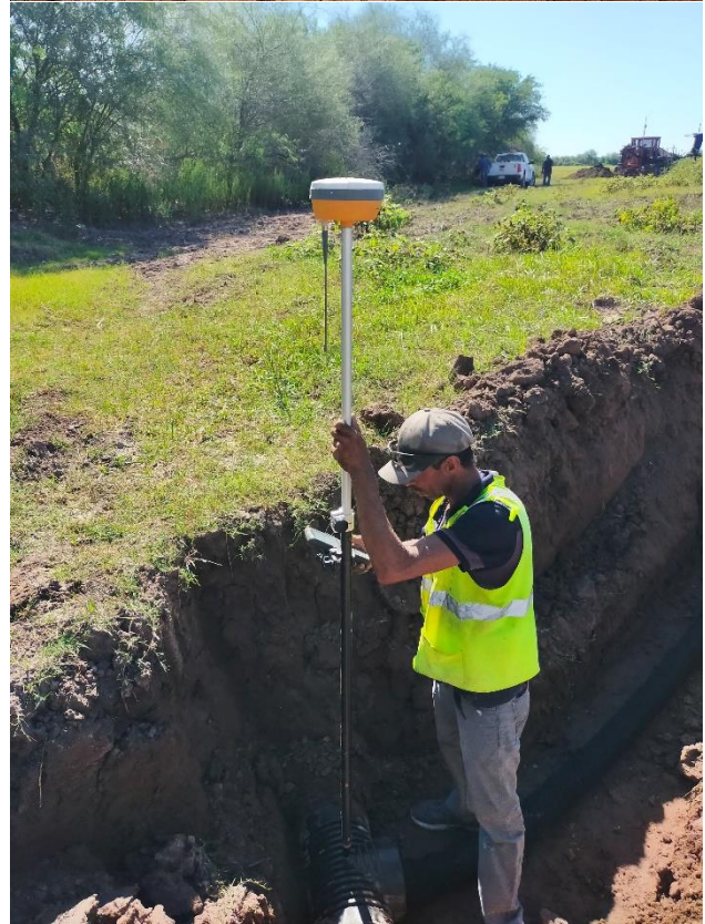
Ilustración 22. Control topográfico durante la instalación de drenaje agrícola subterráneo.
