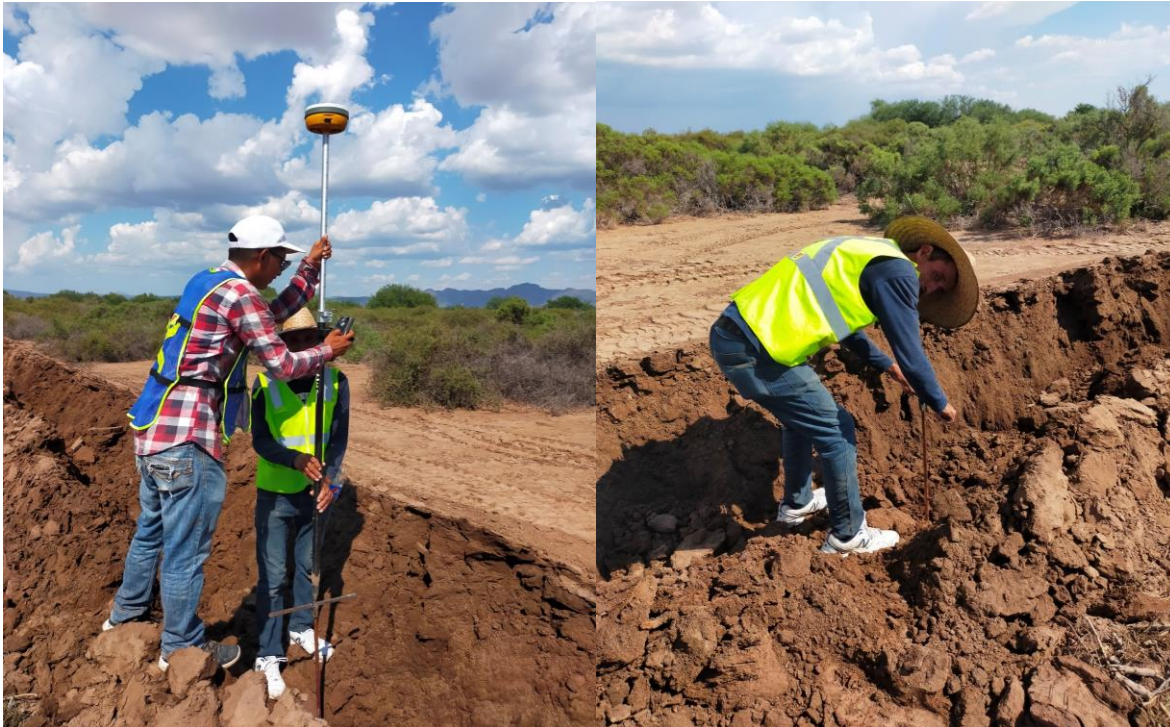
INSTALACIÓN DE SISTEMA DE DRENAJE SUBTERRÁNEO PARCELARIO EN LA FIG. 6.6C DE 22.86
