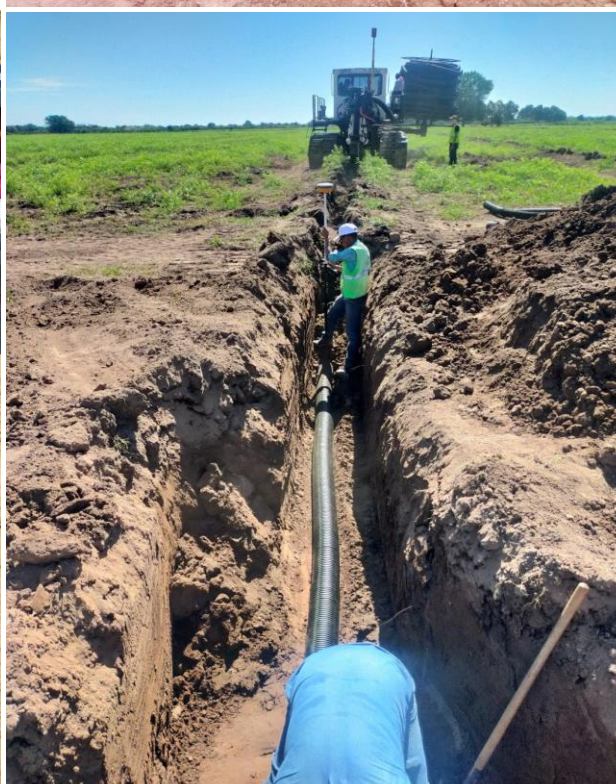
INSTALACIÓN DEL SISTEMA DE DRENAJE EN LA PARCELA DENOMINADA FIG. 5.1 DE 48.80 HA
