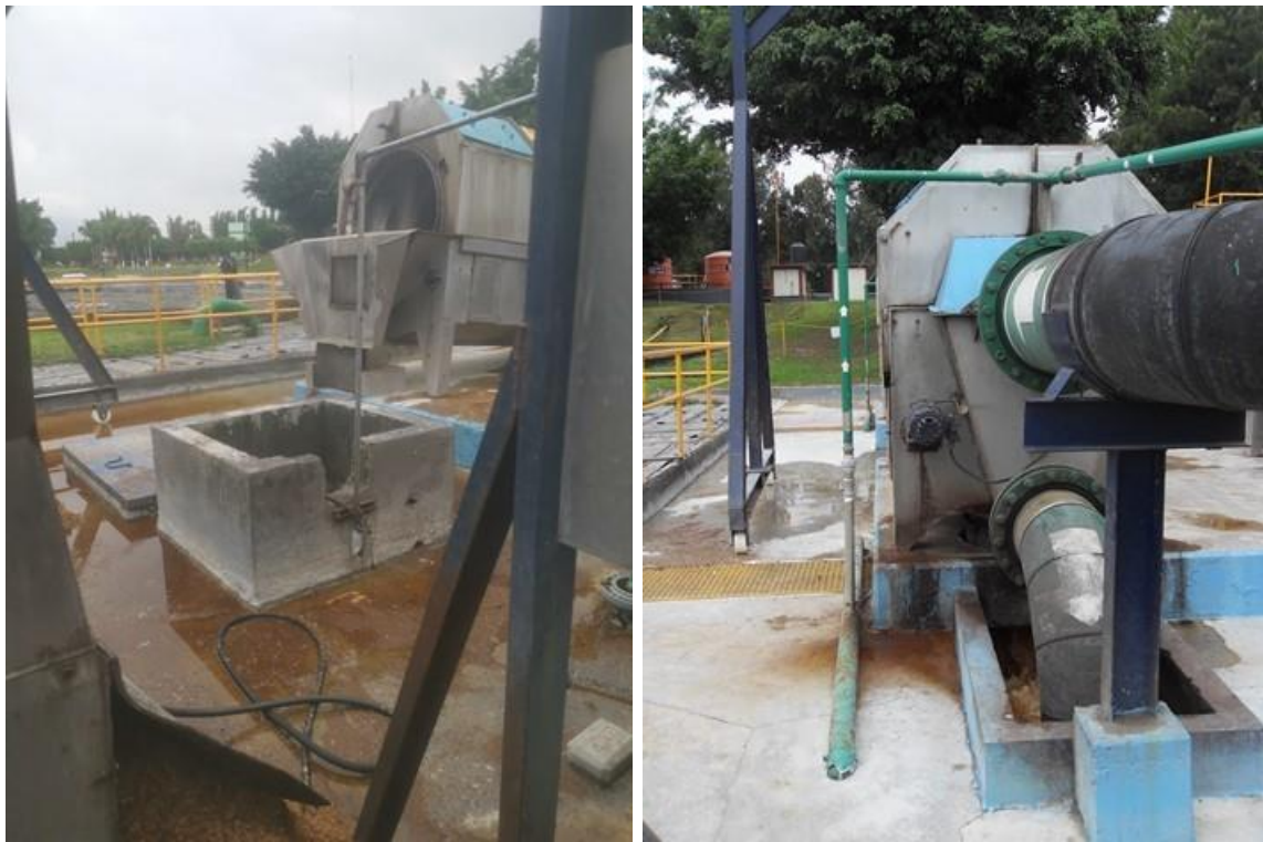
Figura 790. Rejillas finas rotatorias (RJ-113 A-B-C-D)
