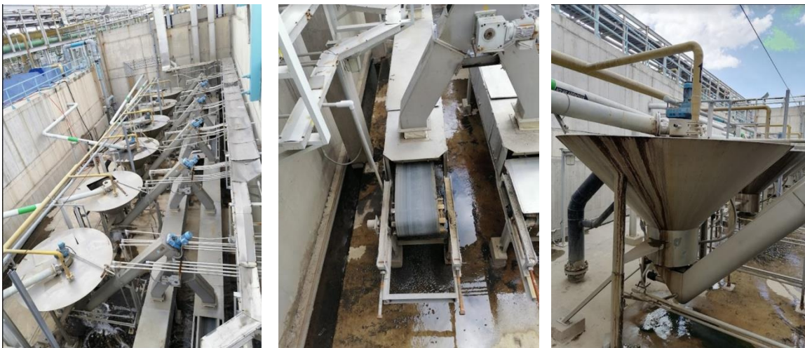
Figura 341. Clasificadores de arenas
