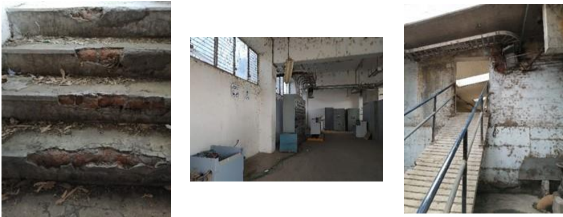
Figura 38 Estado de la obra civil de la PTAR
