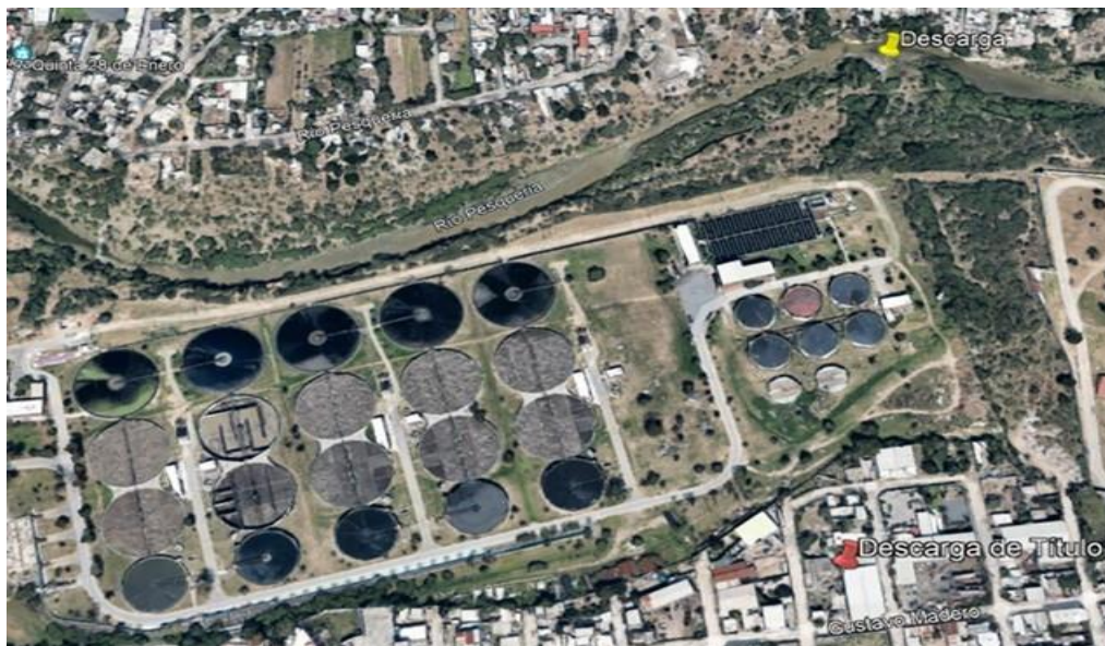
Figura 841. PTAR Norte, y punto de descarga.
