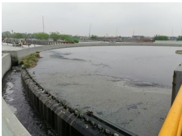
Sedimentadores primarios
