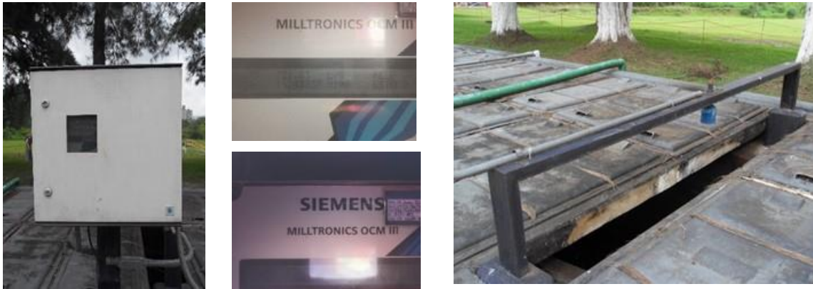
Figura 727. Medidor influente.
