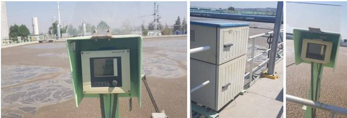
Figura 629. Sensores colocados en los reactores aerobios
