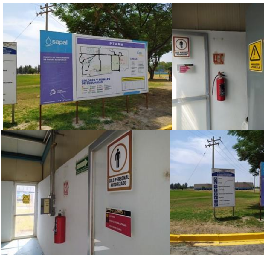
Figura 539. Señalización de seguridad en la PTAR.
