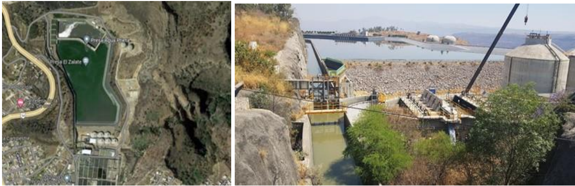
Figura 651. Sitio de descarga del afluente de la PTAR
