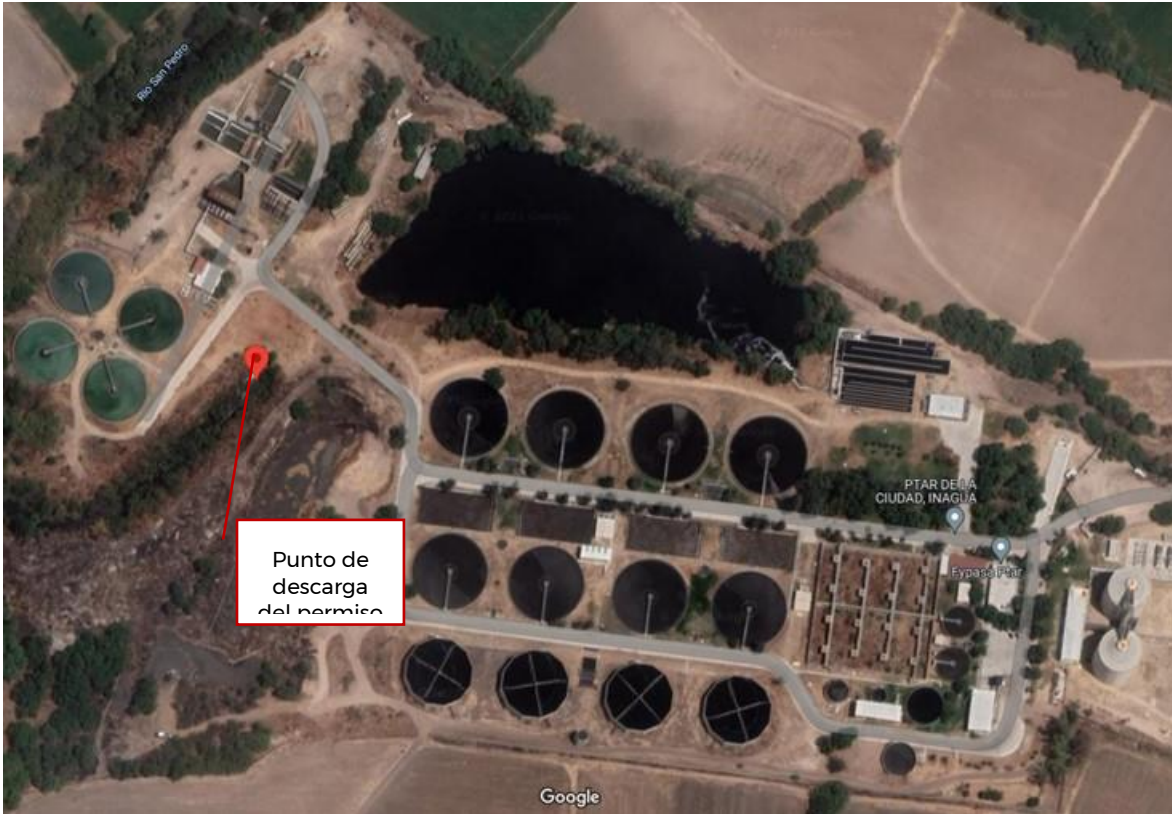
Figura 402. Ubicación de la descarga de la PTAR Cd Aguascalientes
