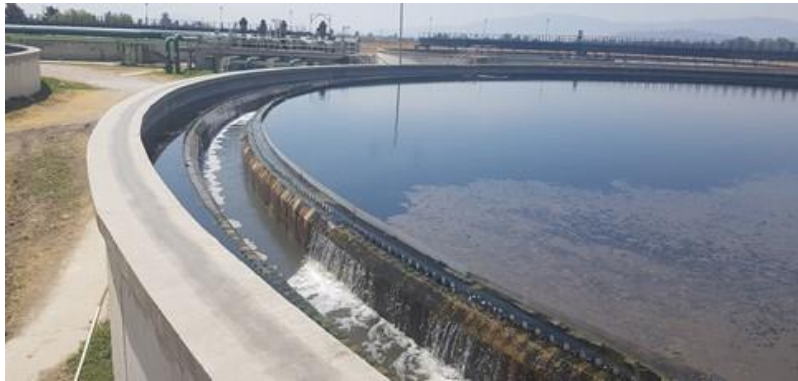
Figura 611. Sedimentadores secundarios
