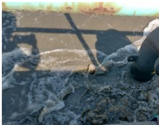
Reactor 11. Fuga de aire
