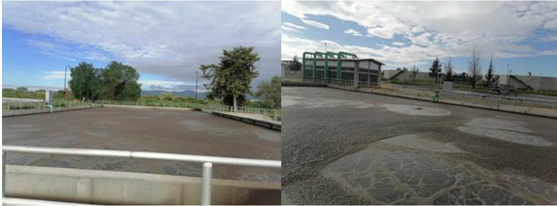
Figura 442. Reactor de lodos activados
