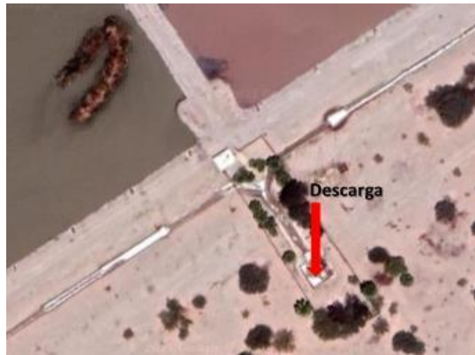
Figura 182 Ubicación de la descarga de la PTAR Torreón
