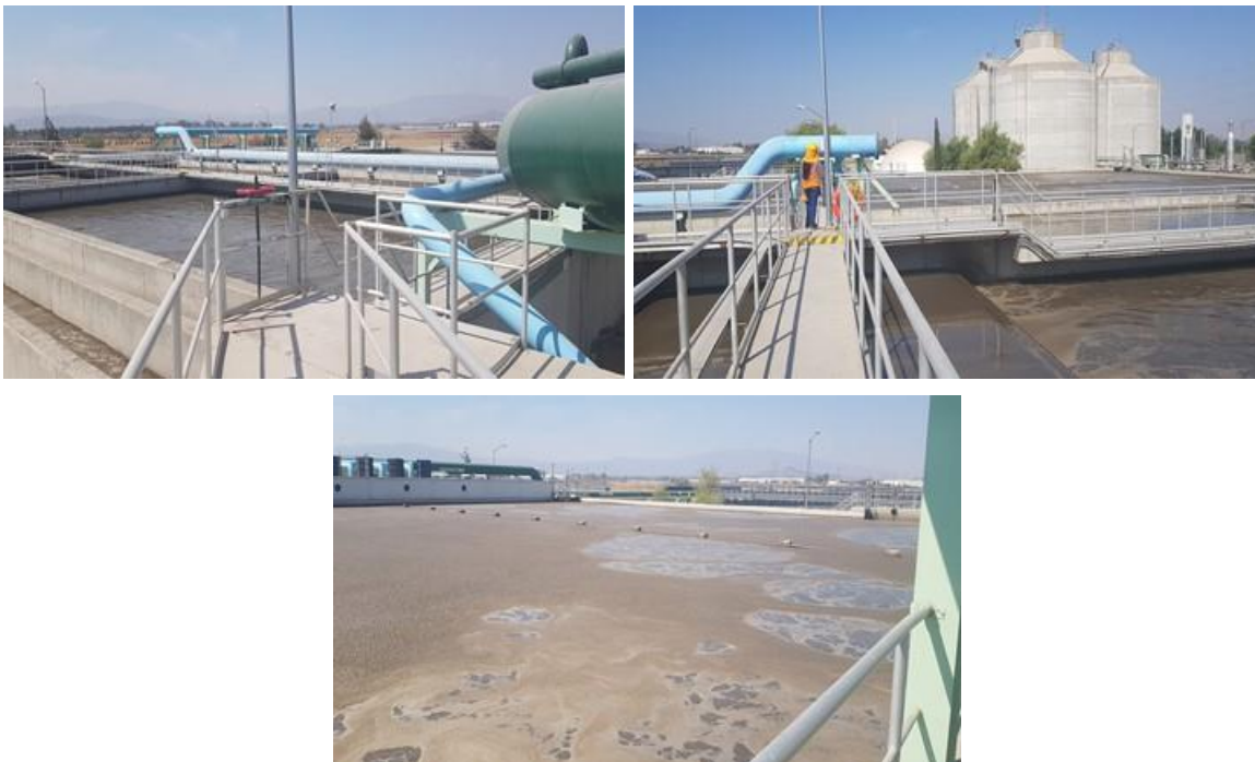
Figura 610. Sistema de remoción biológica de nutrientes
