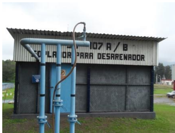
Figura 750. Caseta de soplador para desarenadores aireados.
