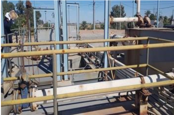
Figura 129. Desarenadores tipo vórtice (DS-ZA-106 A y B)
