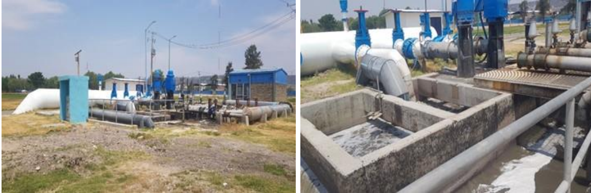
Figura 518. Caja de recepción donde se combinan los efluentes de los cinco sedimentadores primarios
