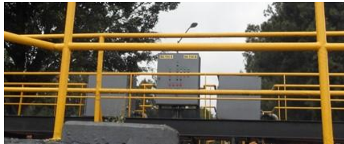
Figura 752. Puente de desarenadores.
