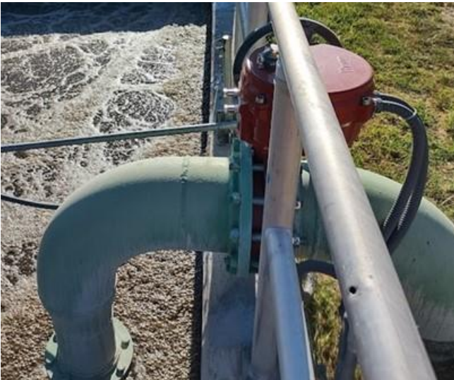
Figura 463. Válvulas del sistema de aeración
