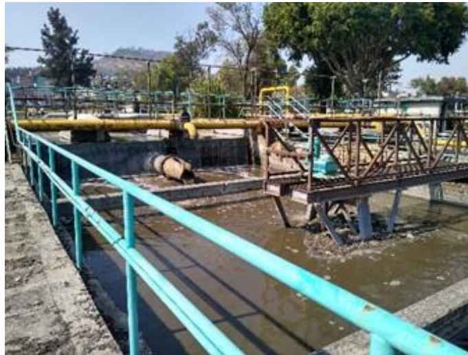
Figura 14 Zona de celda anóxica tren Sur
