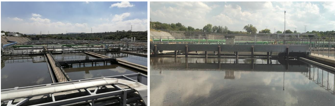
Figura 344. Sedimentadores secundarios
