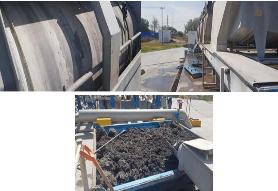
Figura 558. Microtamizadores
