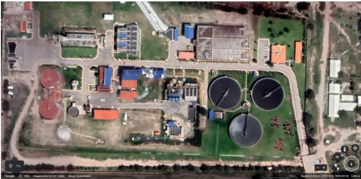
Figura 246. Vista de los reactores anóxicos, aerobios y de la planta en su conjunto.
