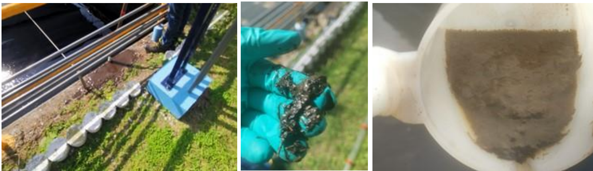
Figura 812. Aspecto del azolve del tanque de contacto.
