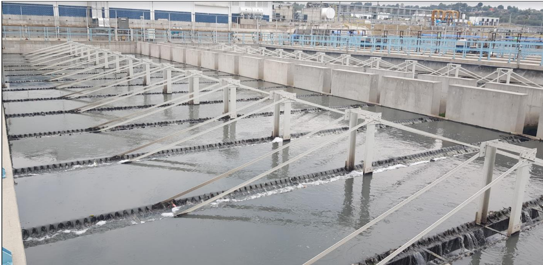
Figura 342. Sedimentador primario
