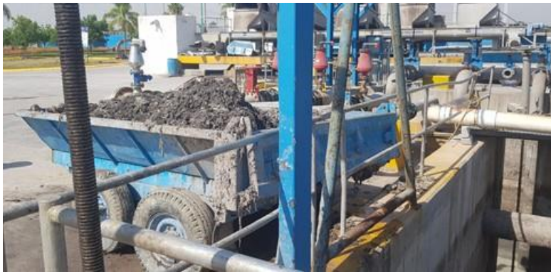
Figura 555. Obtención de residuos del cárcamo de bombeo
