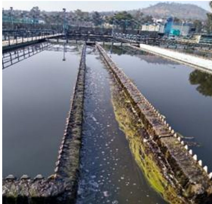
Figura 16 Sedimentador secundario Sur
