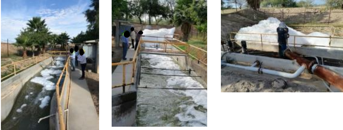
Figura 199 Canal Parshall y tanque de almacenamiento
