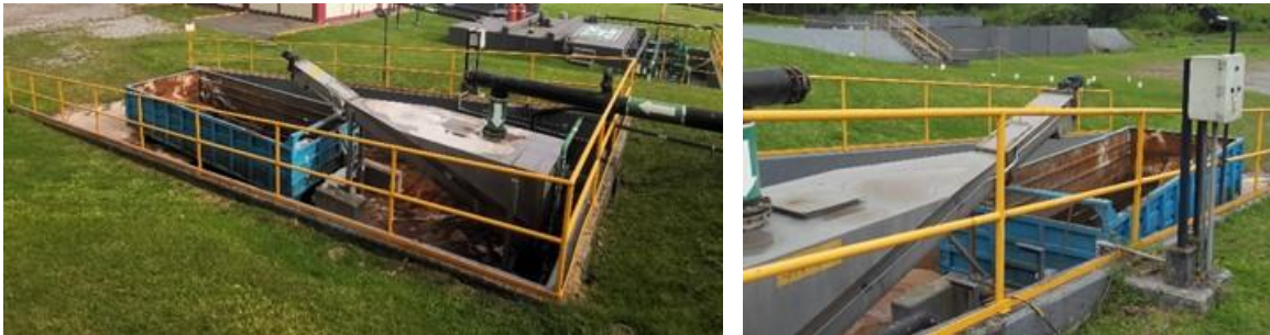
Figura 755. Lavado y recolección de arenas.
