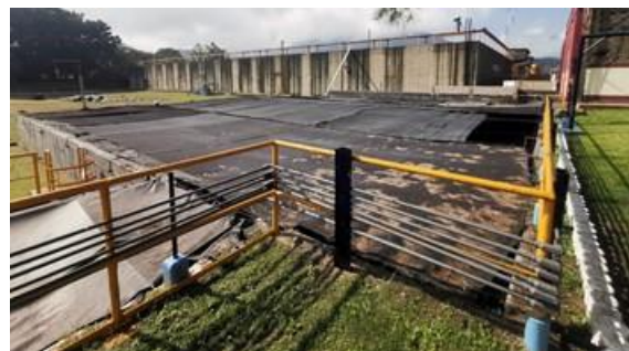
Figura 806. Tanque de contacto TQ-400.
