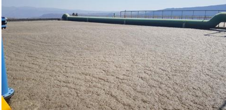
Figura 688. Reactor de lodos activados operando parcialmente
