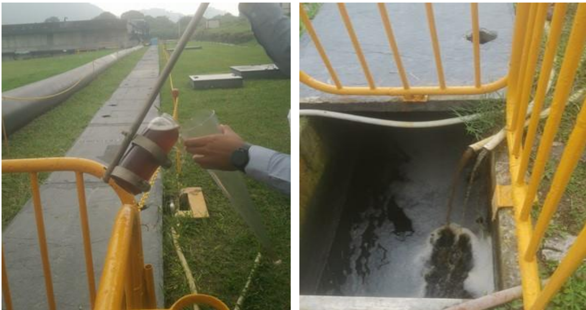
Figura 804. Canal cubierto hacia tanque de contacto para la desinfección del efluente de reactores aerobios
