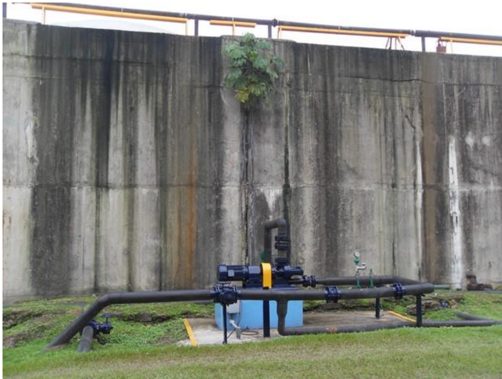
Figura 813. Vistas de la infraestructura de la PTAR.
