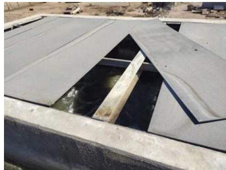
Figura 106. Caja rompedora de velocidad
