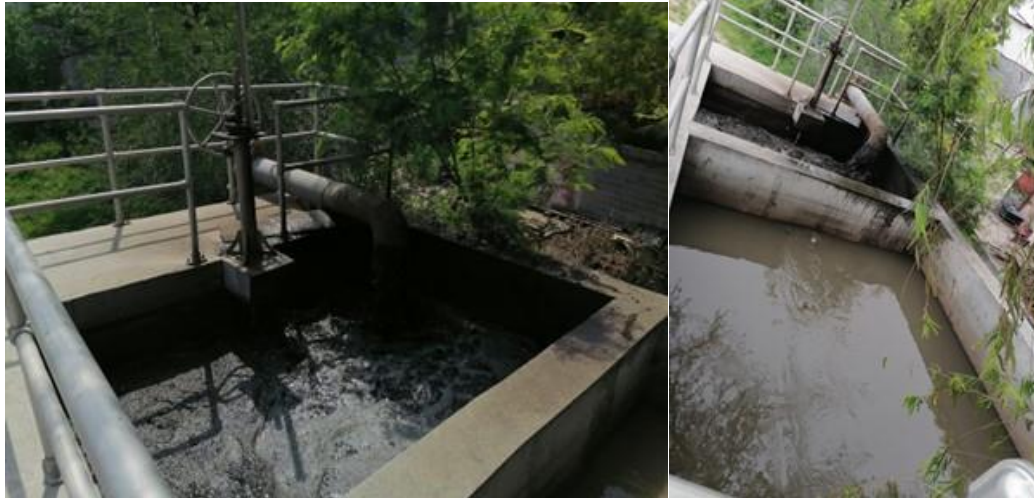
Figura 868. Canal de distribución Tren 6
