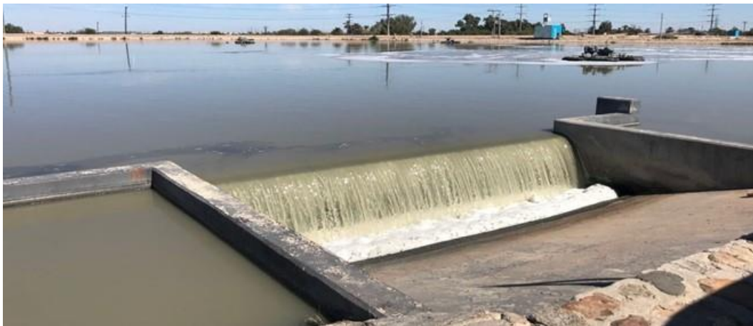
Figura 143. Interconexión entre las lagunas de aireación y las lagunas de sedimentación
