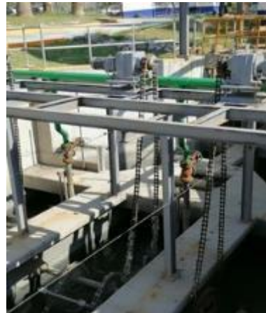
Figura 202 Tolva de arenas y desarenador fuera de operación
