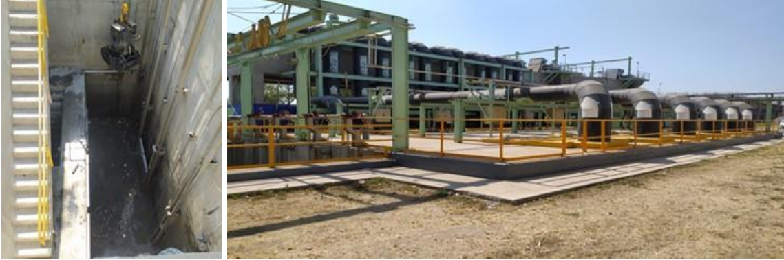
Figura 602. Bombeo de agua cruda
