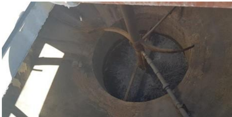
Figura 109. Desarenador tipo vórtice
