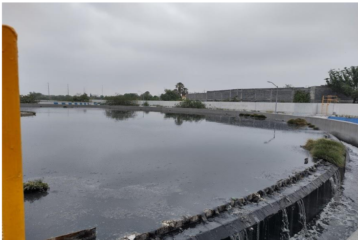
Figura 924. Estado actual de los sedimentadores primarios
