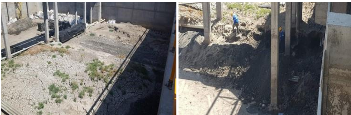
Figura 691. Acumulación de sólidos y basura en el reactor biológico
