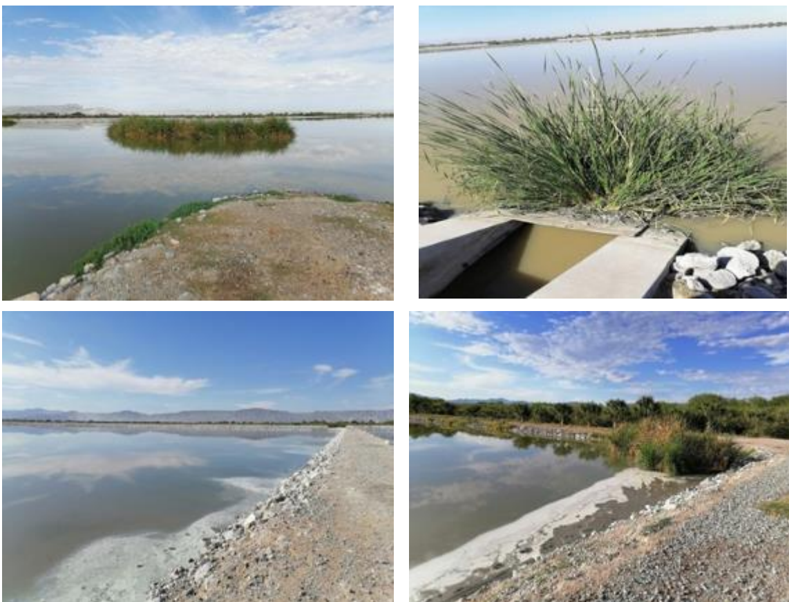
Figura 204 Maleza en lagunas facultativas y canales preferenciales
