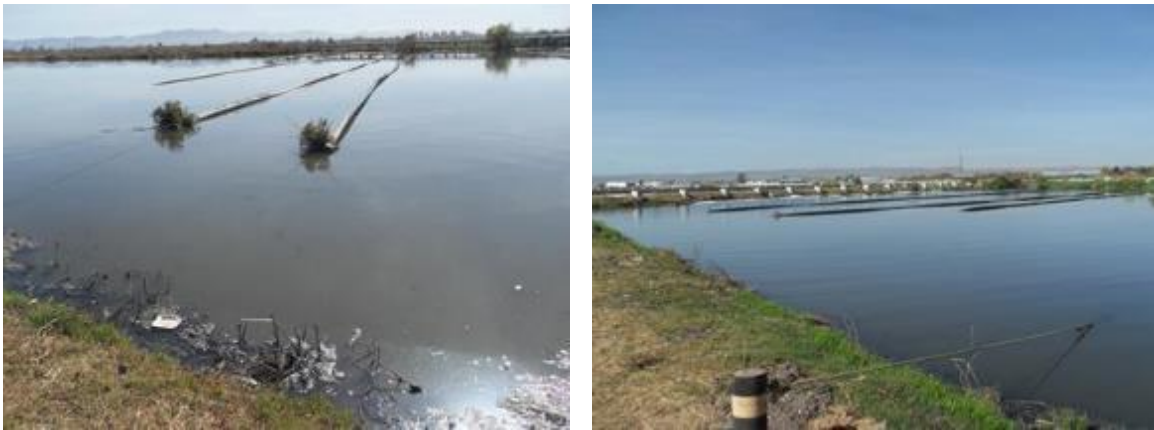
Figura 293. Líneas de distribución hundidas
