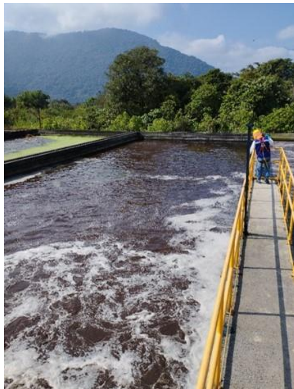
Figura 801. Aeración no uniforme en reactores RAE-301
