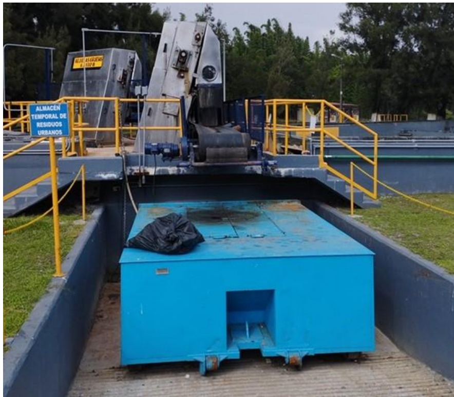
Figura 784. Almacenamiento temporal de residuos
