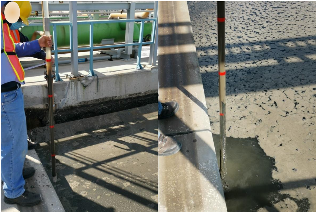
Figura 374. Lodo biológico flotado sobre los sedimentadores secundarios
