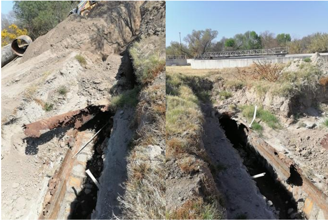
Figura 447. tubería colapsada
