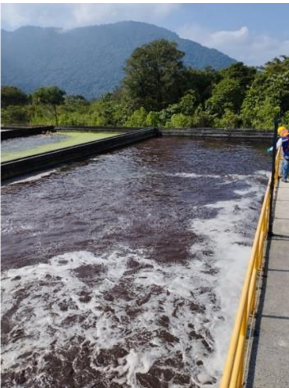
Figura 801. Aeración no uniforme en reactores RAE-301
