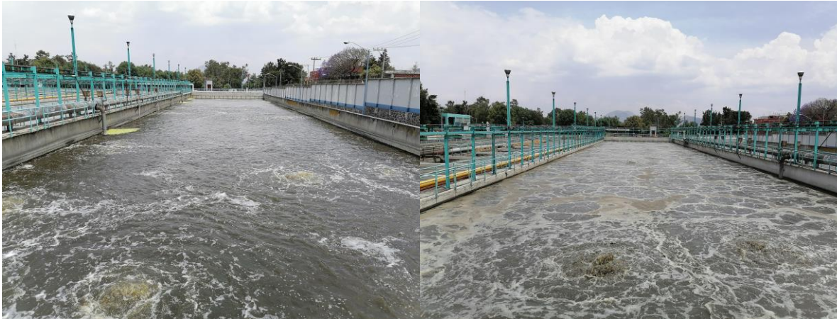
Figura 19 Reactor de lodos activados Sur 13 y 14
