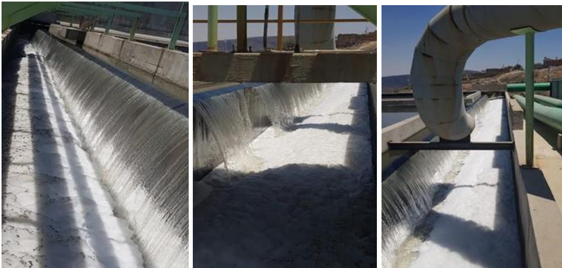
Figura 695. Efluente de los sedimentadores secundarios
