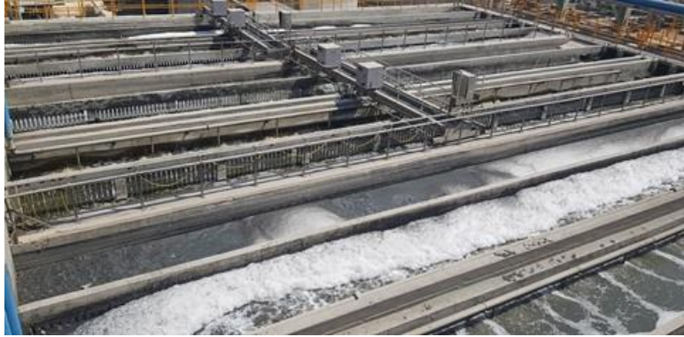
Figura 673. Sistema de desarenado-desengrasado
