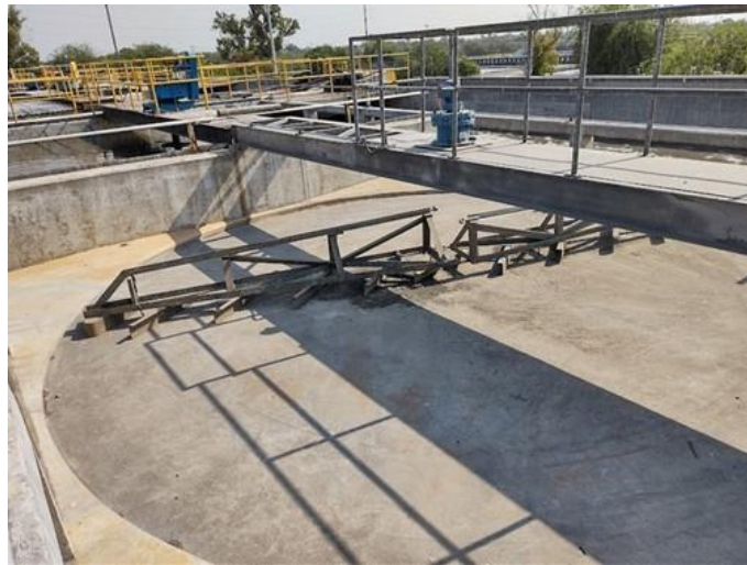
Figura 923. Desarenador deshabilitado
