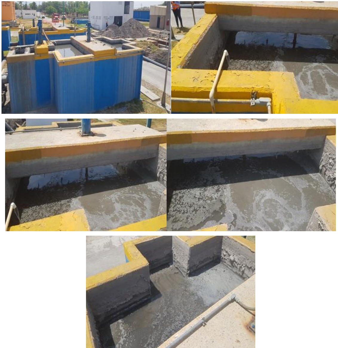
Figura 564. Proceso de coagulación-floculación
