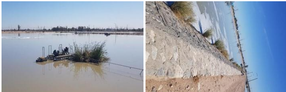
Figura 134. Presencia de vegetación en las lagunas aireadas
