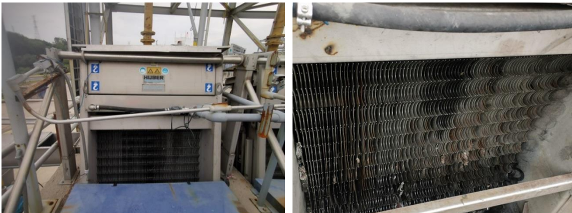
Figura 352. Rejillas gruesas automatizadas dañadas y fuera de servicio
