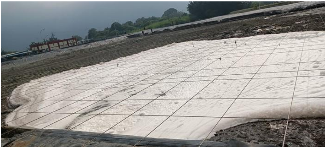
Figura 757. Vista de la laguna de igualación
