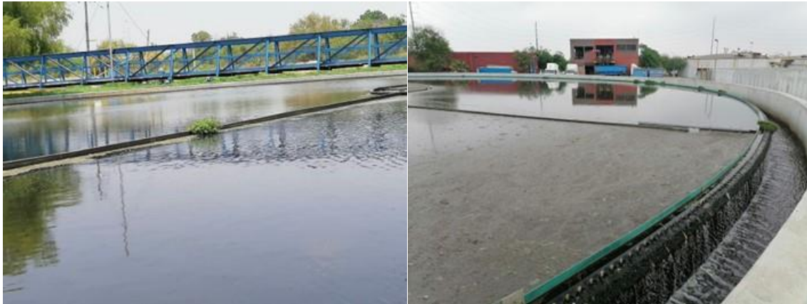
Figura 878. Estado de sedimentadores secundarios
