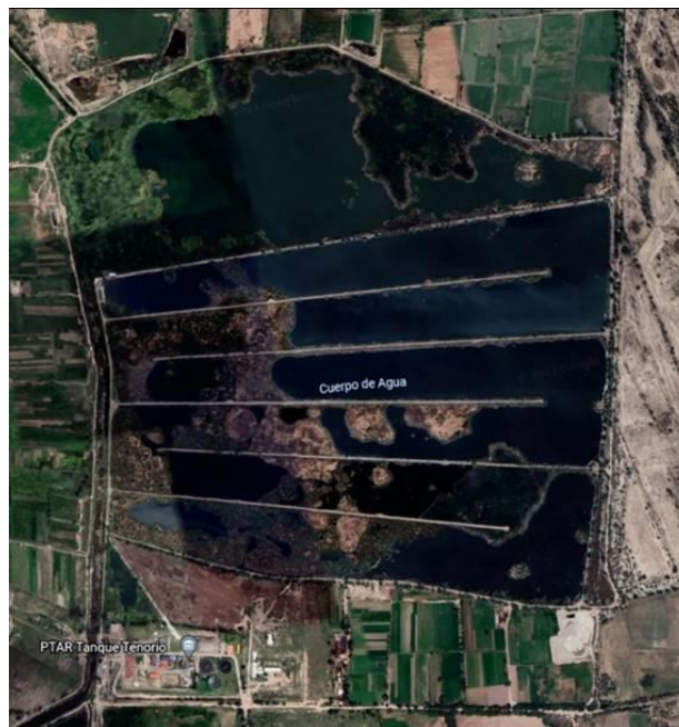
Figura 244. Vista aérea del conjunto PTAR-Humedal “El Tenorio-Tanque Tenorio”.
