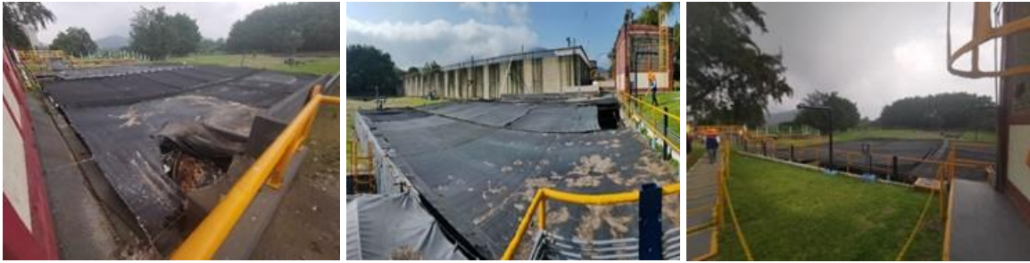
Figura 744. Tanque de cloración.
