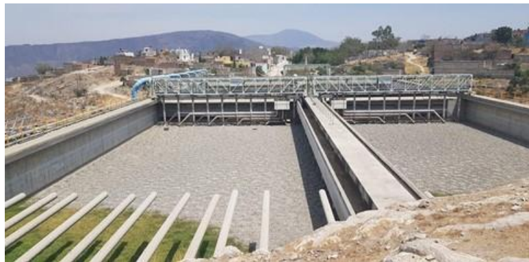
Figura 693. Reactor de lodos activados fuera de operación
