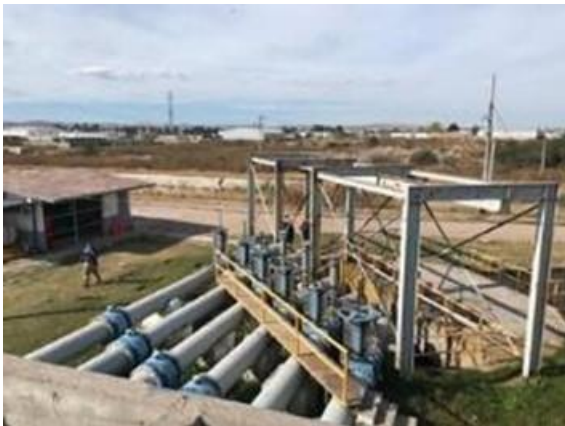
Figura 283. Cárcamo de bombeo y caja distribuidora
