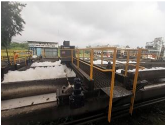
Figura 731. Pretratamiento: desarenador aireado y soplador.
