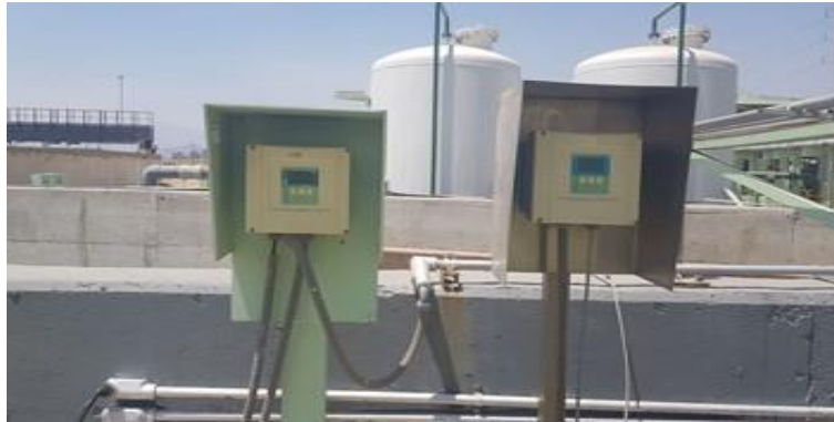
Figura 632. Descarga final del agua residual tratada de la PTAR El Ahogado.
