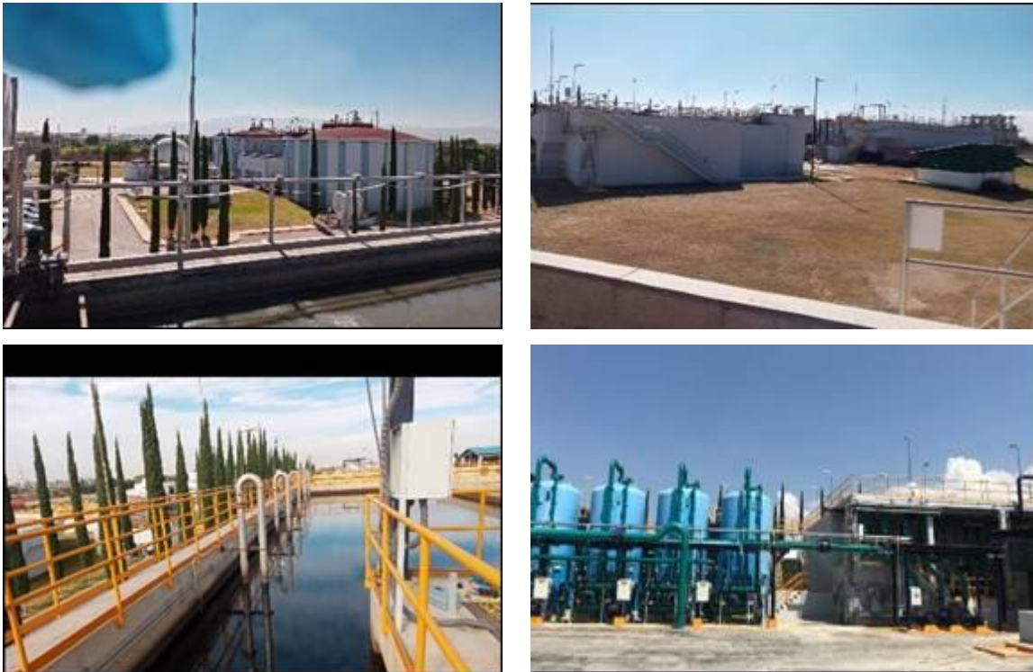
Figura 250. Vistas de la infraestructura de la PTAR.
