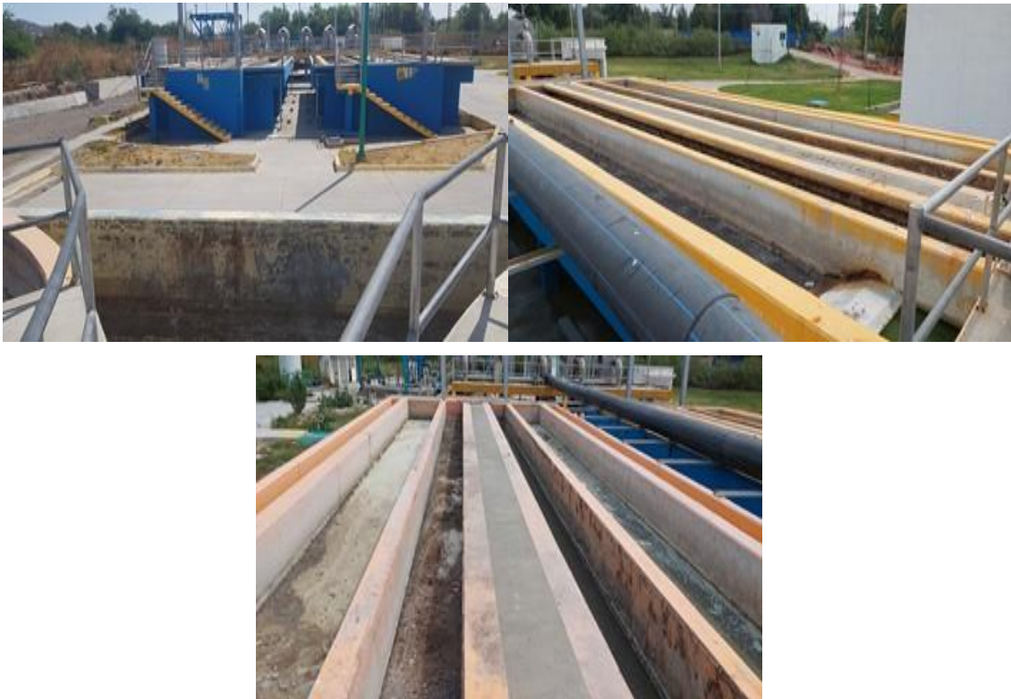
Figura 559. Canales desarenadores-desgrasadores
