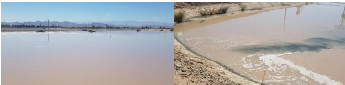
Figura 136. Presencia de bacterias púrpuras de azufre en la laguna aireada C
