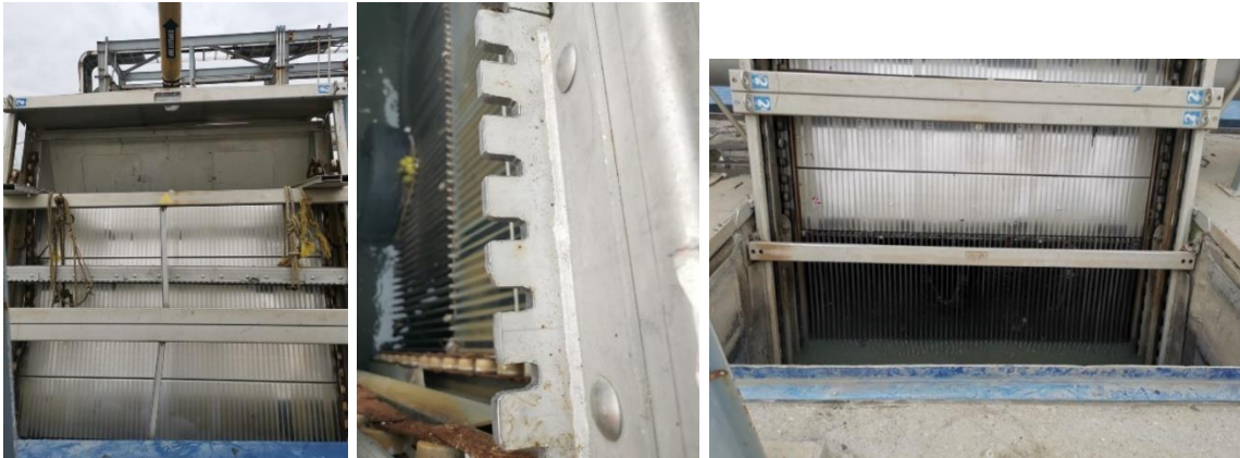
Figura 337. Rejillas gruesas automatizadas
