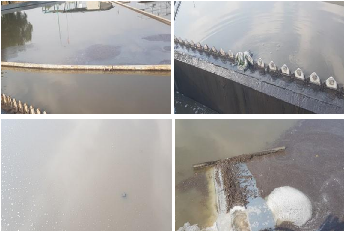
Figura 521. Estado actual de los sedimentadores secundarios
