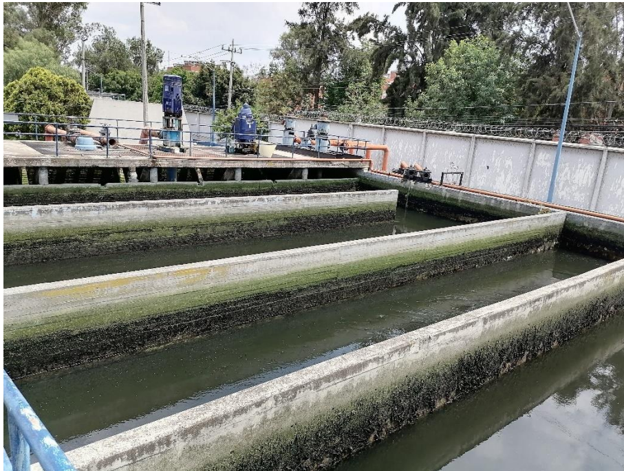
Figura 36 Estado de sedimentadores secundarios
