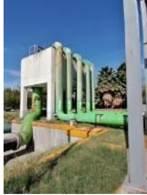
Figura 195 Cárcamo de bombeo y caja distribuidora
