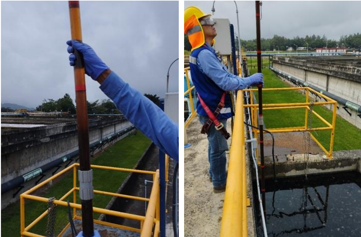
Figura 803. Medición del manto de lodos en reactor de aeración/sedimentación.
