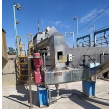
Figura 108. Tornillo transportador
