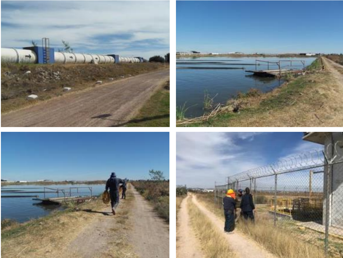
Figura 294. Vialidades internas en la PTAR
