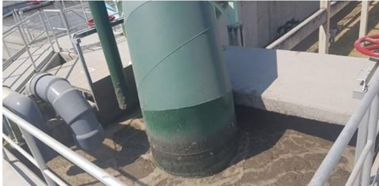
Figura 624. Caja de amortiguamiento
