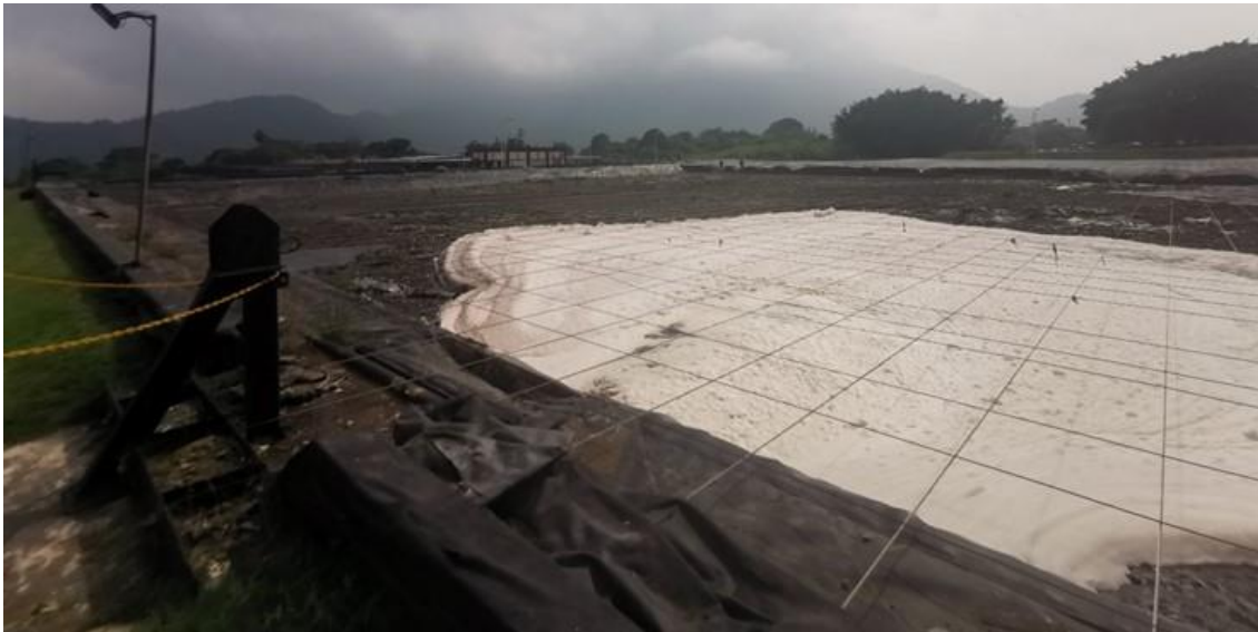
Figura 733. Laguna de homogenización en mantenimiento correctivo.
