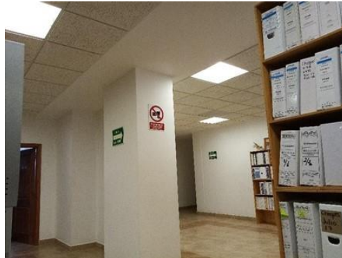
Figura 390. Señales de las rutas de evacuación
