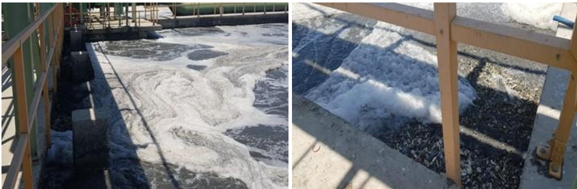
Figura 691. Acumulación de sólidos y basura en el reactor biológico
