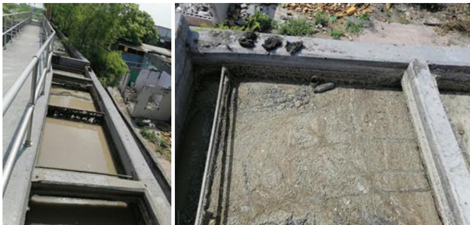
Figura 873. Sólidos en canales de distribución
