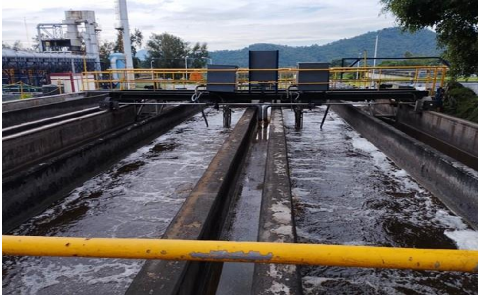
Figura 786. Desarenadores aireados
