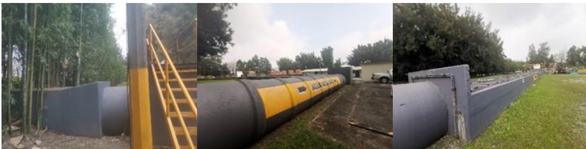
Figura 729. Colector general (influyente) de la PTAR FIRIOB.
