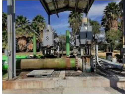
Figura 195 Cárcamo de bombeo y caja distribuidora
