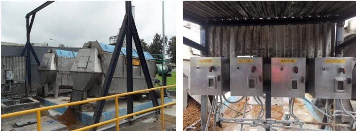
Figura 732. Pretratamiento: rejillas finas de tambor rotatorio.
