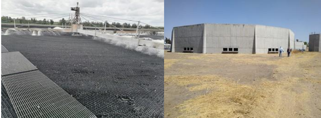
Figura 440. Biofiltros o filtros percoladores
