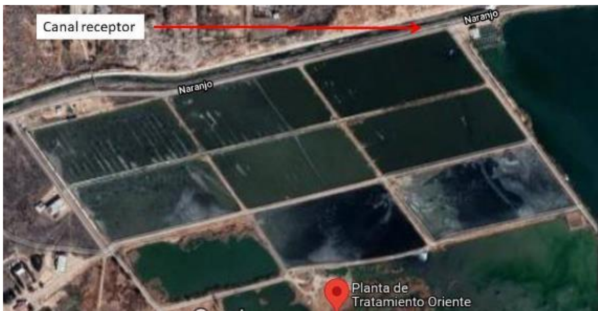
Figura 270. Ubicación de la descarga de la PTAR Durango Oriente
