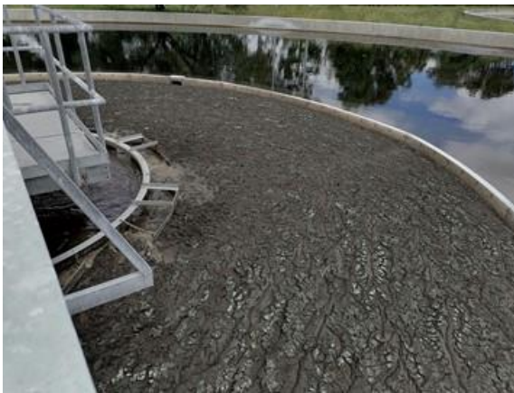
Sedimentador secundario 1
