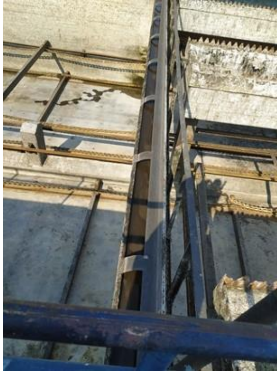
Figura 75 Media caña en el sedimentador secundario
