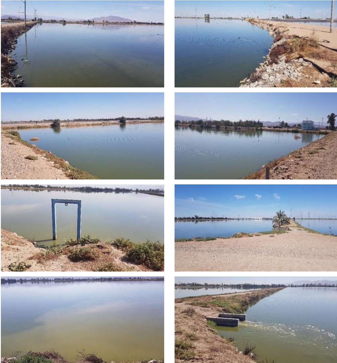
Figura 147. Lagunas de maduración de la PTAR de Zaragoza
