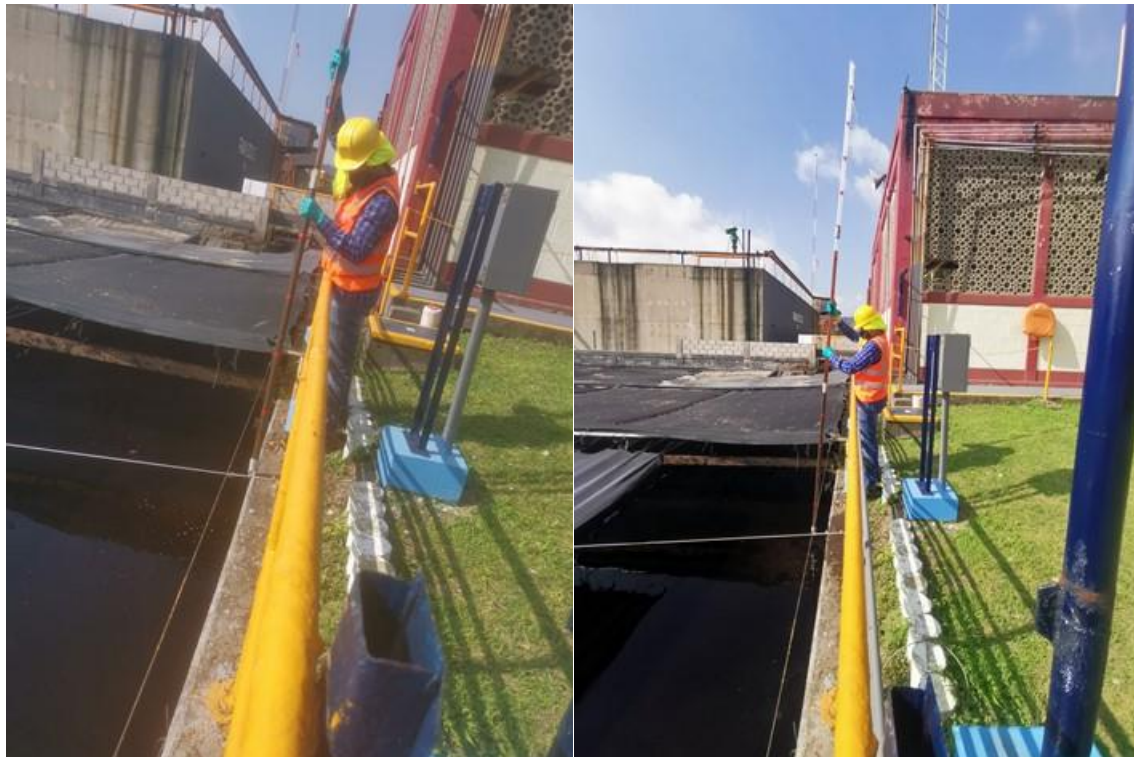
Figura 810. Medición de nivel de azolve en del tanque de contacto.
