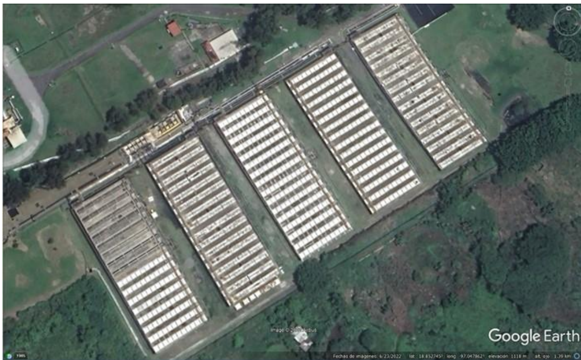
Figura 758. Vista aérea de los reactores anaerobios.
