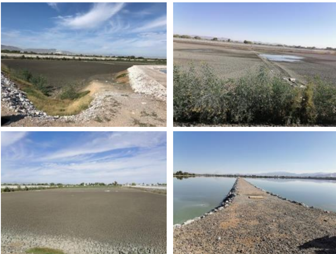
Figura 203 Laguna anaerobia C y conexión entre laguna facultativa C y D
