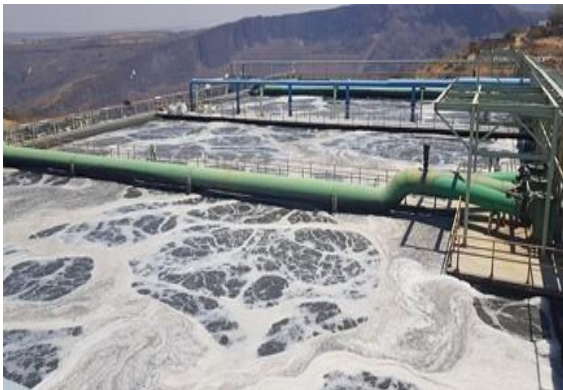
Figura 688. Reactor de lodos activados operando parcialmente
