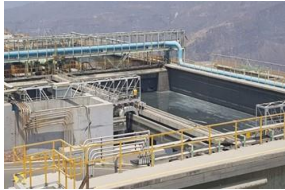
Figura 700. Sedimentadores secundarios fuera de operación
