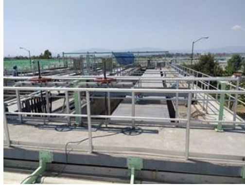
Figura 607. Sistema de desarenado-desengrasado
