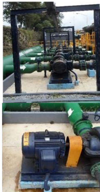
Figura 734. Bombas alimentadoras de reactores anaerobios BC-209 A-B-C-D-E).
