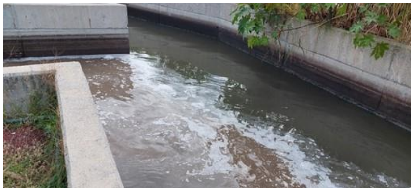
Figura 509. Mezcla del excedente de agua residual y del efluente del tanque de contacto de cloro
