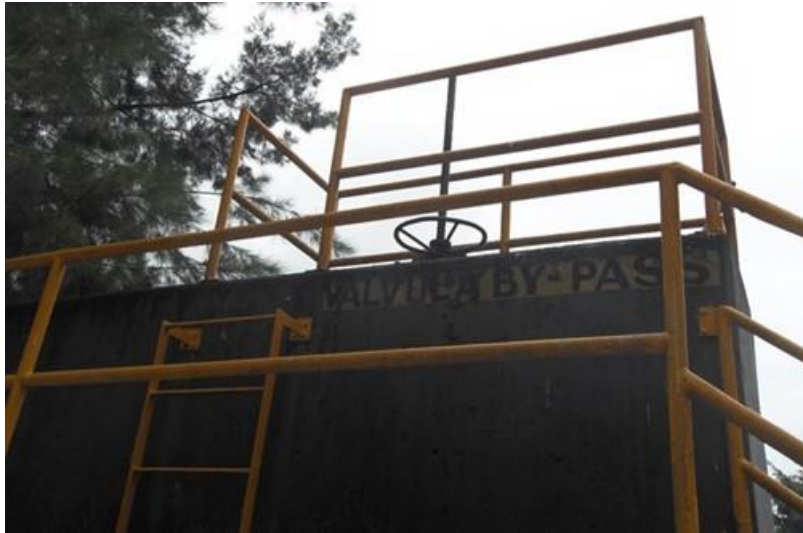
Figura 725. Caja derivadora y válvula de by-pass para excedencias.
