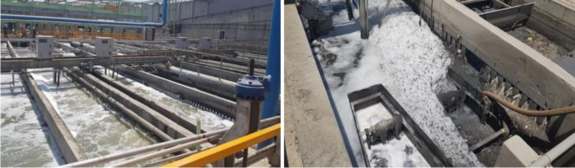
Figura 684. Desarenadores-desgrasadores
