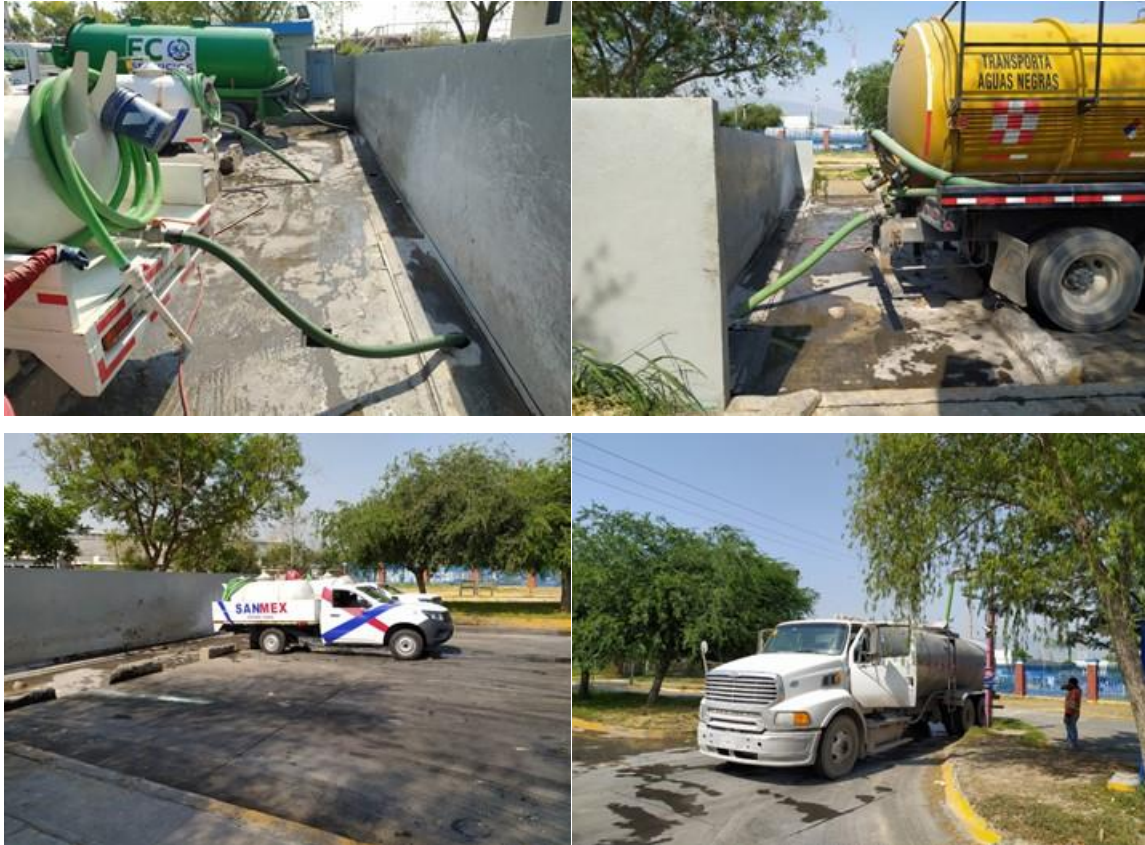
Figura 861. Zona de descarga de pipas con agua residual industrial y de servicios sanitarios
