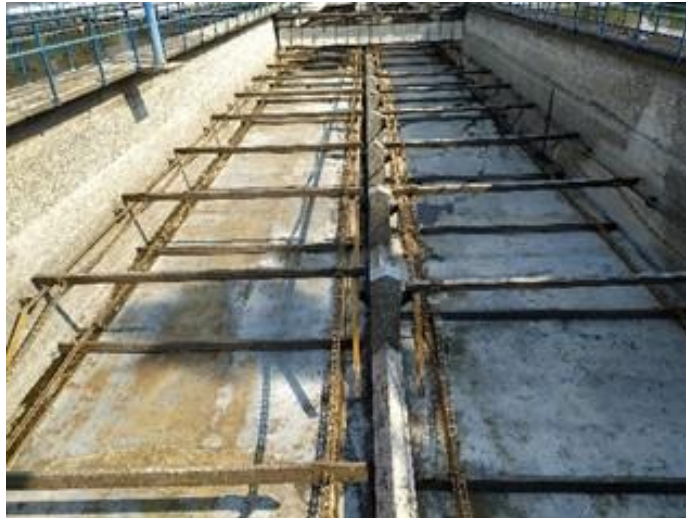
Figura 11 Rastras del sedimentador secundario Norte
