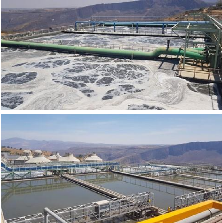
Figura 676. Sistema de tratamiento secundario
