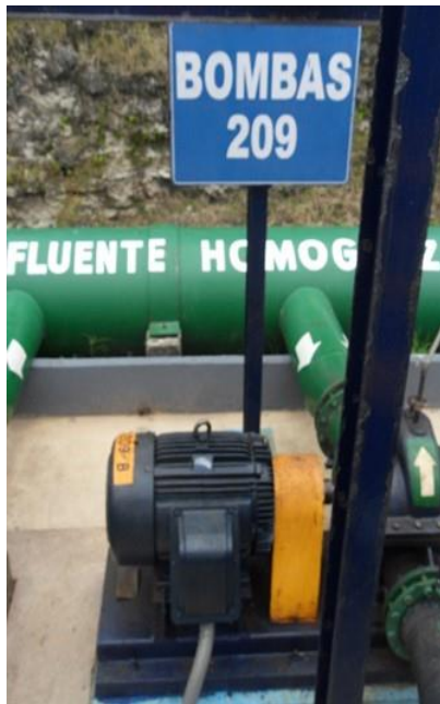
Figura 734. Bombas alimentadoras de reactores anaerobios BC-209 A-B-C-D-E).
