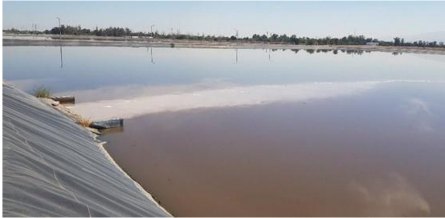
Figura 144. Lagunas de sedimentación de la PTAR de Zaragoza
