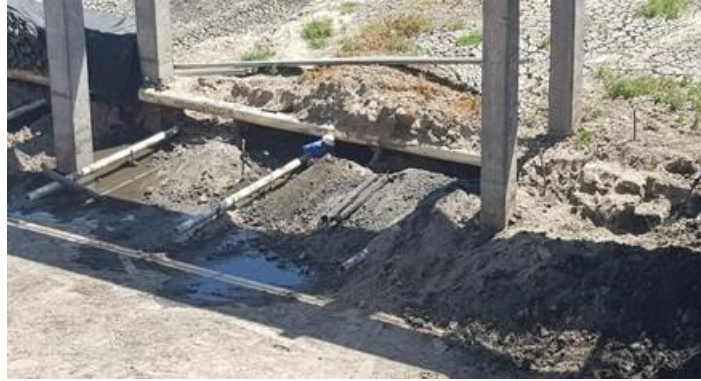
Figura 692. Acumulación de arenas en el fondo de un reactor de lodos activados
