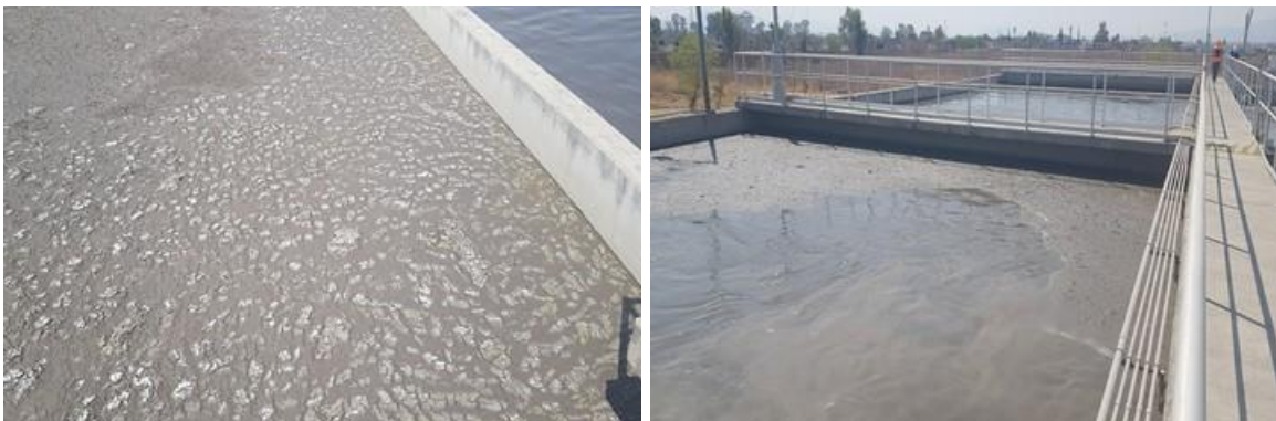
Figura 626. Presencia de zonas muertas en los reactores anaerobios
