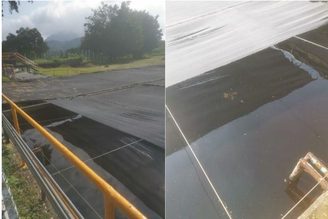
Figura 808. Áreas descubiertas del tanque de contacto.
