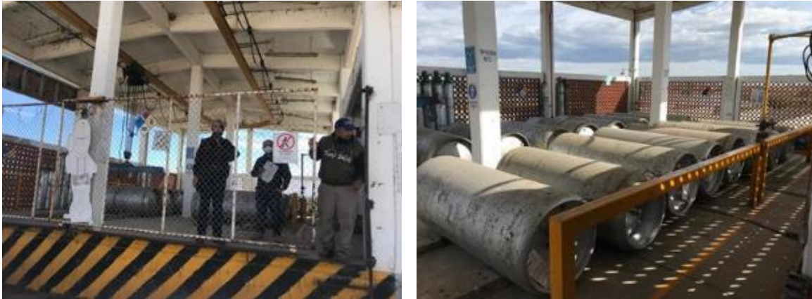
Figura 297. Estado físico de la sección de desinfección de la PTAR
