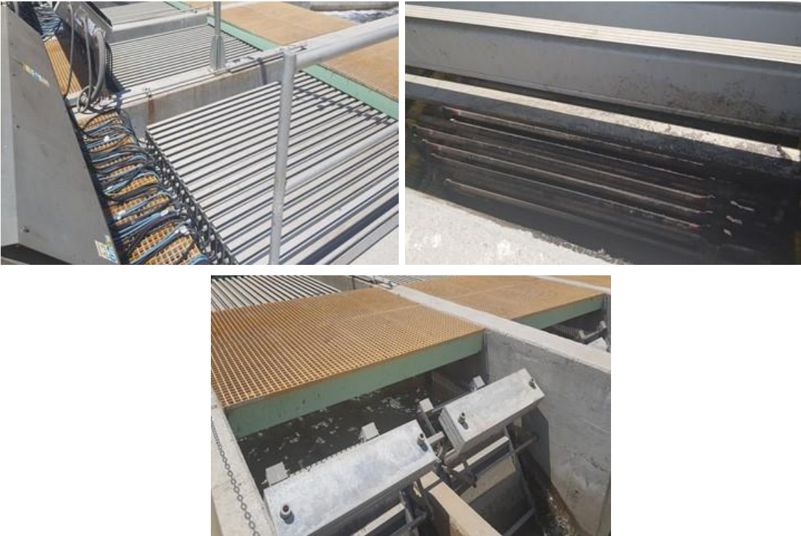
Figura 631. Sistema de desinfección UV
