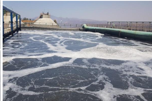
Figura 688. Reactor de lodos activados operando parcialmente
