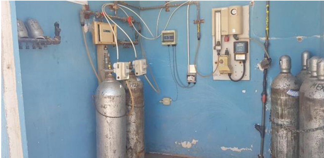
Figura 157. Caseta de cloración del tren de tratamiento terciario de la PTAR de Zaragoza
