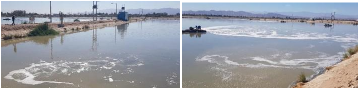
Figura 135. Cortos circuitos presentes en las lagunas aireadas
