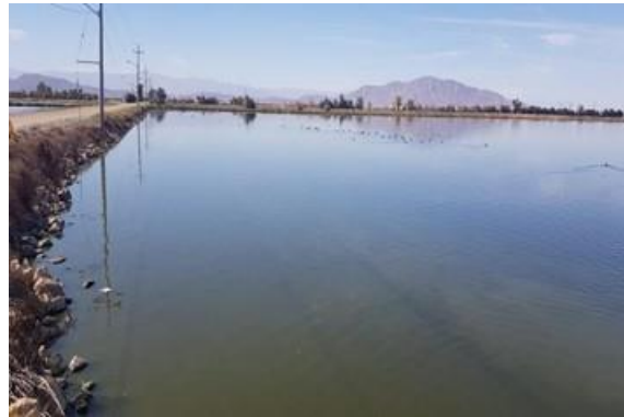
Figura 116. Laguna de maduración
