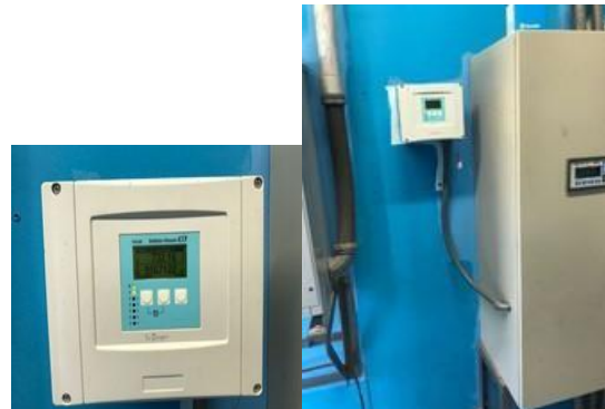
Figura 131. Medidor de flujo colocado en el canal Parshall
