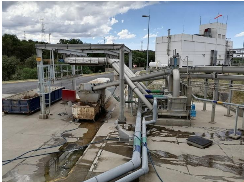
Figura 354. Compactador de basuras
