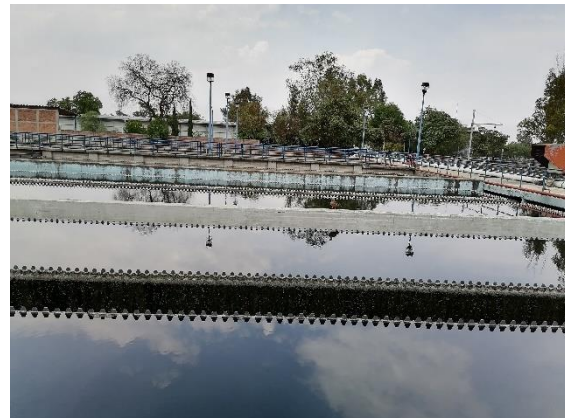
Zona de vertedores
