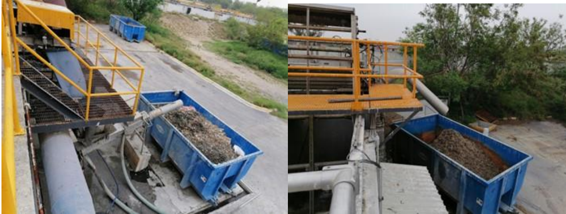
Figura 865. Basura de rejillas medianas y finas
