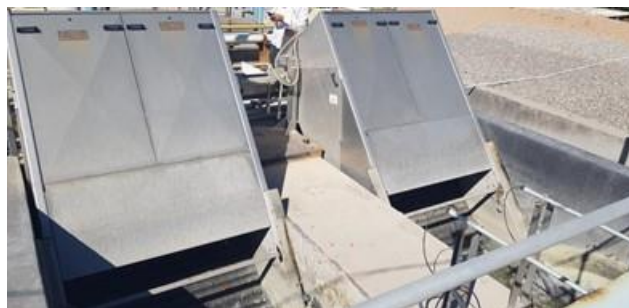
Figura 107. Cribas finas tipo escalera
