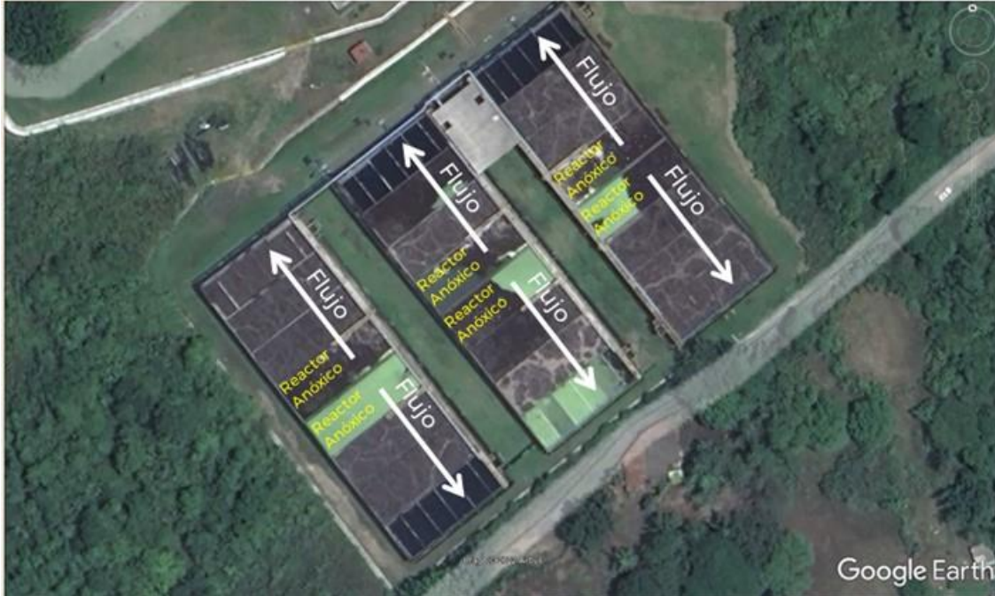
Figura 760. Vista aérea de los rectores secuenciales anóxico-aerobio.
