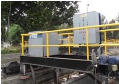
Figura 751. Caseta de soplador para desarenadores aireados.
