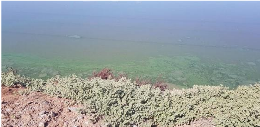
Figura 148. Presencia de vegetación en las lagunas de maduración
