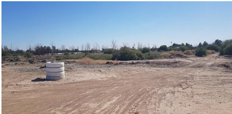
Figura 158. Lagunas de deshidratación de la PTAR de Zaragoza
