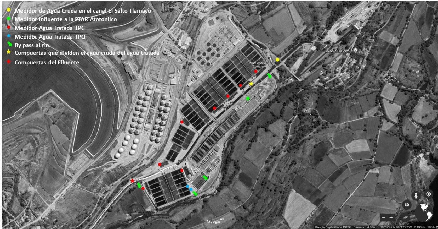
Figura 321. Ubicación de puntos de aforo y de compuertas de la PTAR Atotonilco
