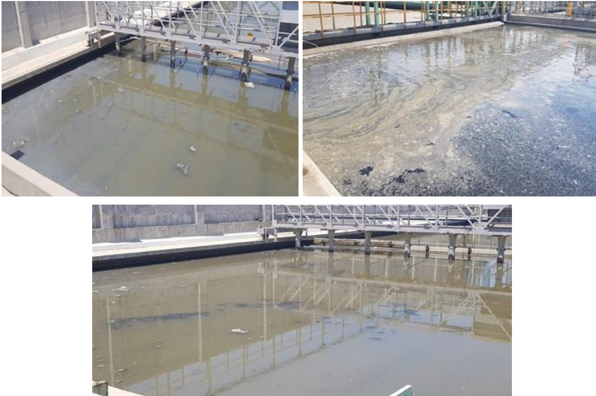
Figura 696. Presencia de natas y grasas y aceites en los sedimentadores secundarios
