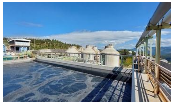
Figura 689. Reactores de lodos activados en malas condiciones de operación
