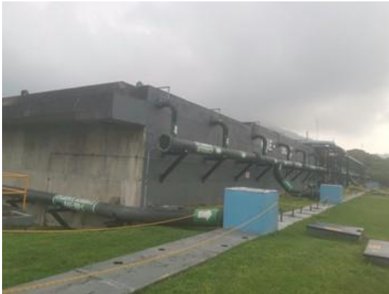
Figura 805. Canal cubierto y punto de inyección de hipoclorito de sodio.
