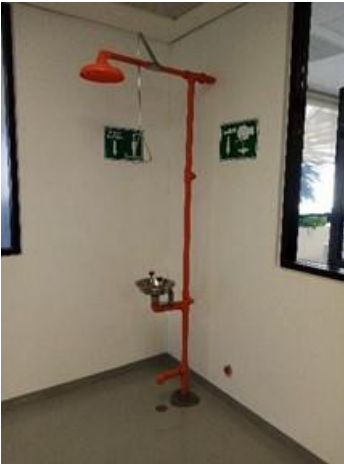
Figura 393. Señales de la ubicación de los lavajos
