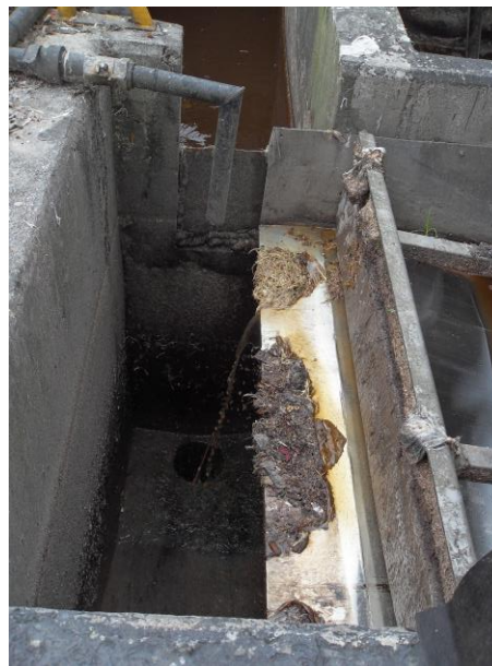
Figura 821. Desarenadores A, B y C
