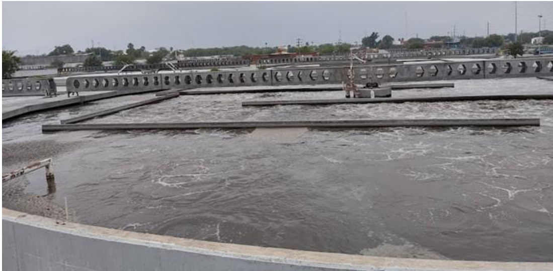
Figura 896. Puente en reactores biológicos del 1 al 6.
