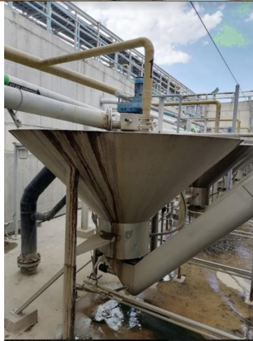
Figura 356. Clasificadores de arenas
