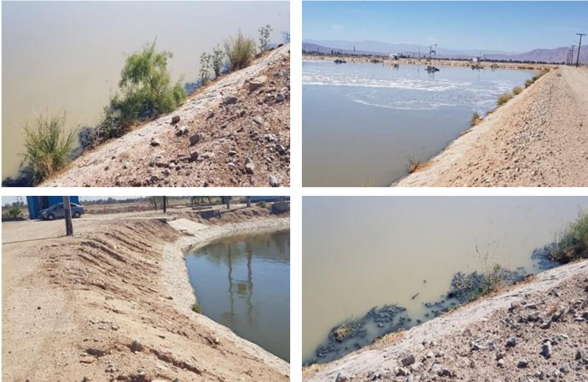
Figura 133. Arenas y piedras sobre los taludes de las lagunas aireadas
