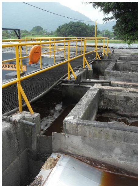
Figura 821. Desarenadores A, B y C
