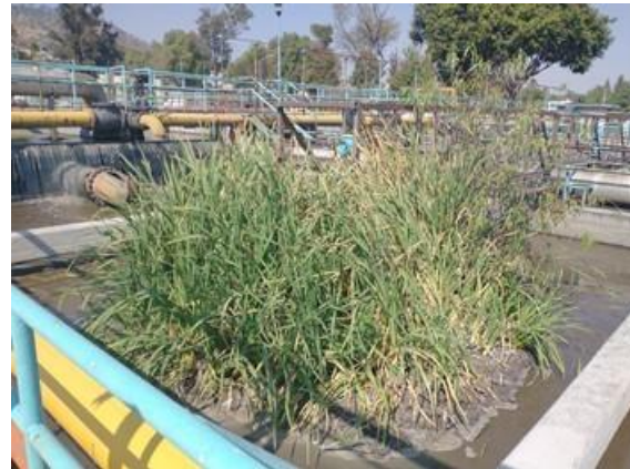
Reactor 12. Presencia de vegetación
