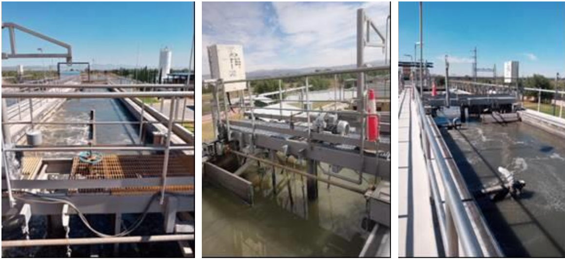
Figura 241. Desarenadores aireados.
