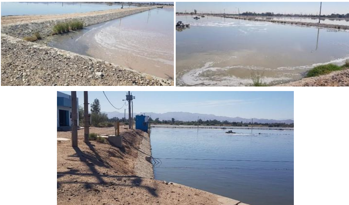
Figura 141. Zonas muestreo y flujos preferenciales en las lagunas de aireación
