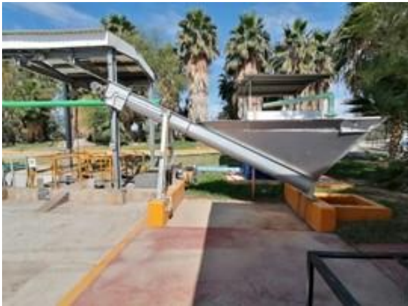
Figura 202 Tolva de arenas y desarenador fuera de operación
