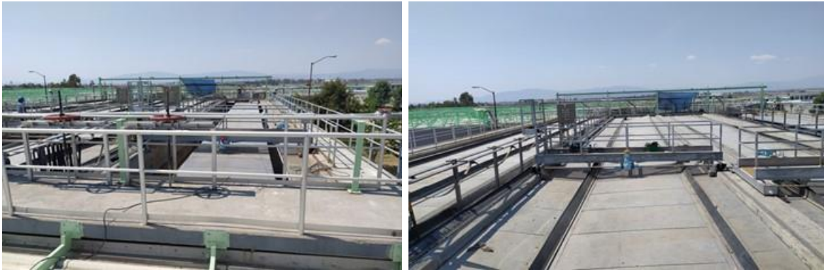
Figura 619. Desarenadores-Desgrasadores
