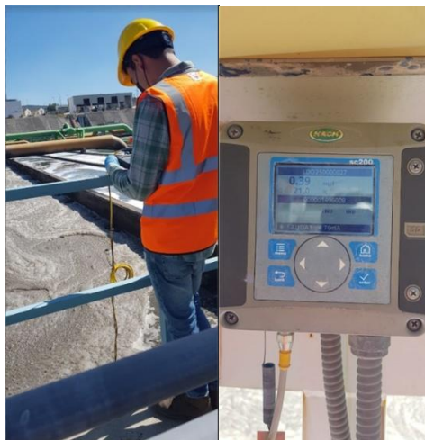
Figura 363. Medición del oxígeno disuelto y pH en los reactores biológicos
