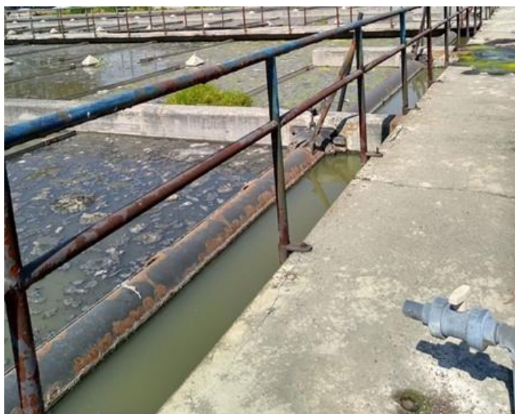
Figura 74 Media caña en el sedimentador primario
