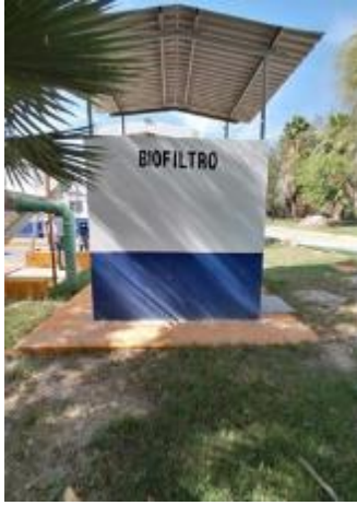
Figura 201 Biofiltro para el tratamiento de gases
