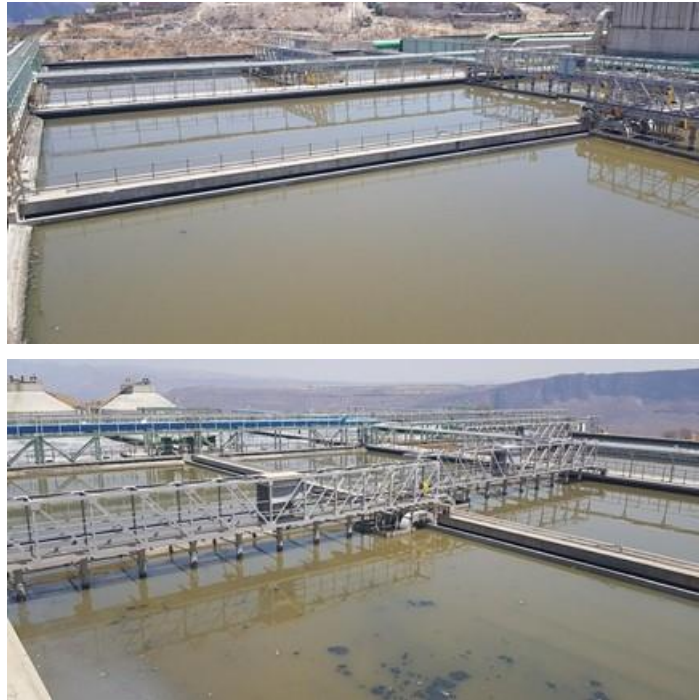
Figura 677. Sedimentadores secundarios
