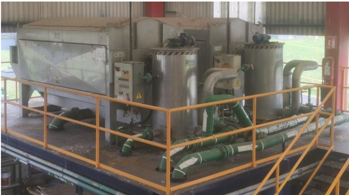
Figura 799. Decantadores centrífugos (DEC-502) y espesadores (ESP-500)
