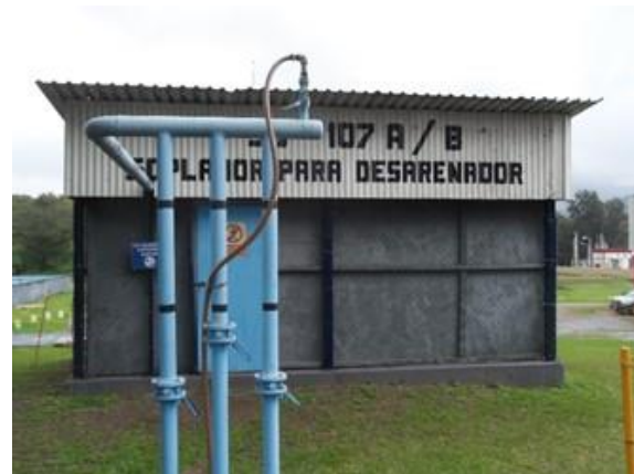
Figura 731. Pretratamiento: desarenador aireado y soplador.
