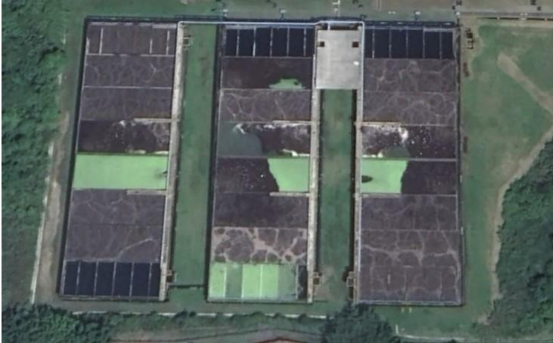
Figura 797. Vista general de los reactores aerobios, anóxicos y decantadores
