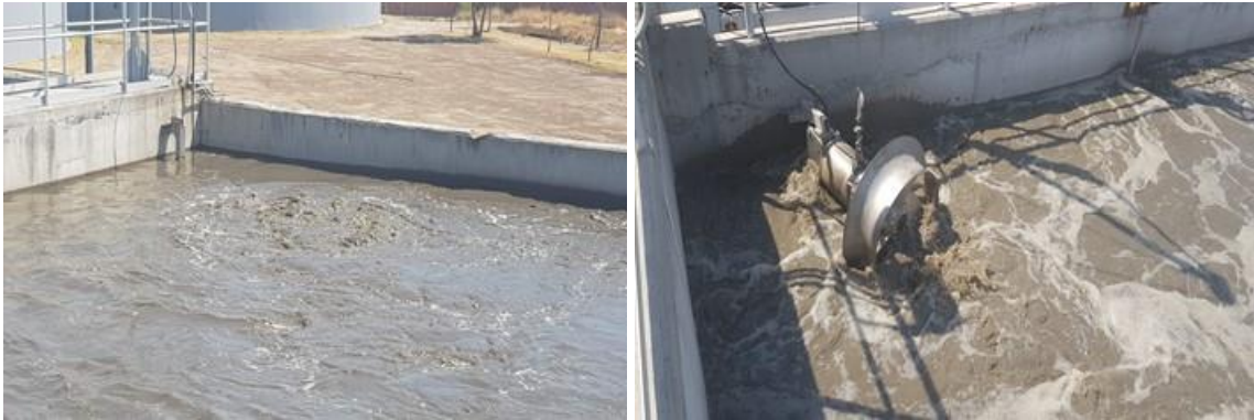
Figura 625. Reactores anaerobios con exceso de turbulencia
