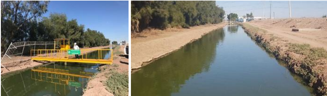
Figura 151. Conducción del efluente final de la PTAR de Zaragoza
