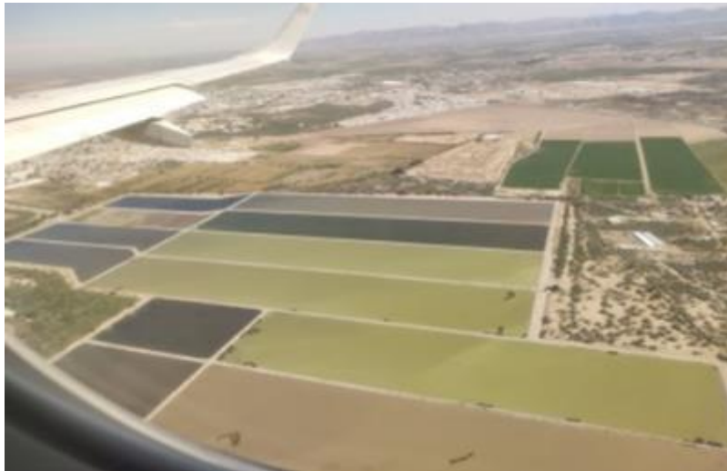
Figura 196 Vista aérea del sistema lagunar de la PTAR Torreón
