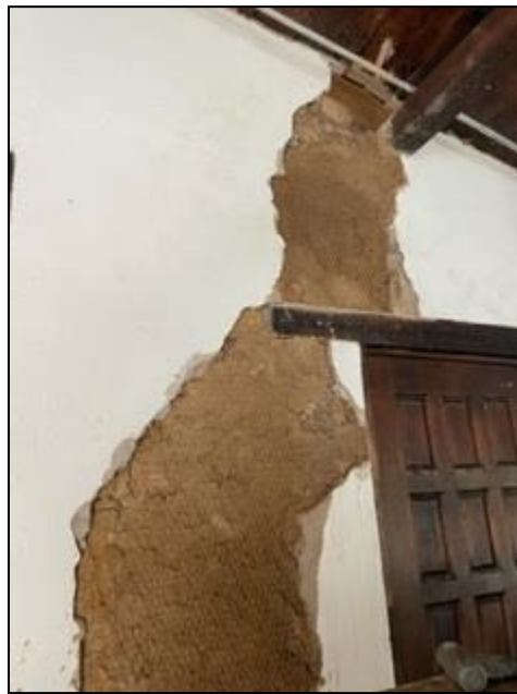
Figura 21. Colocación de malla pollera antes de aplanado para evitar grietas.
