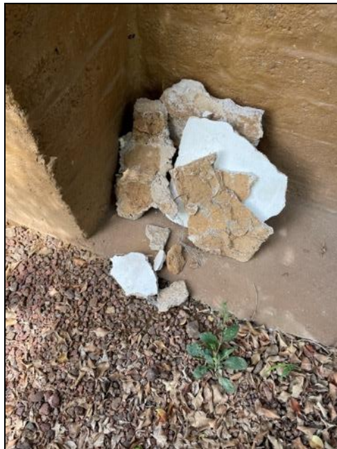
Figura 2. Escombros del retiro del aplanado del muro dañado.
