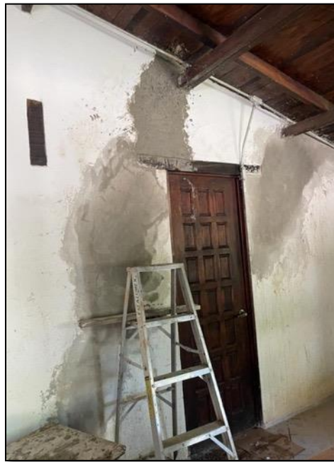
Figura 22. Aplanado en muro de acceso a cuartos.
