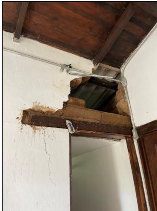
Figura 10. Colocación de adobe a un costado del tinaco de almacenamiento de agua.
