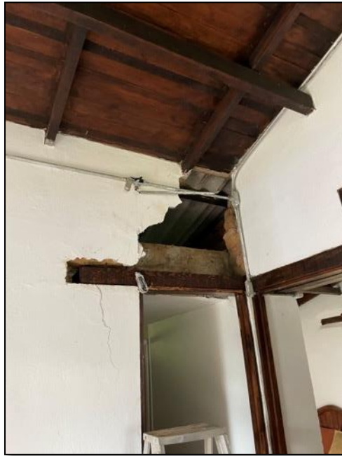
Figura 6. Retiro del cableado eléctrico
