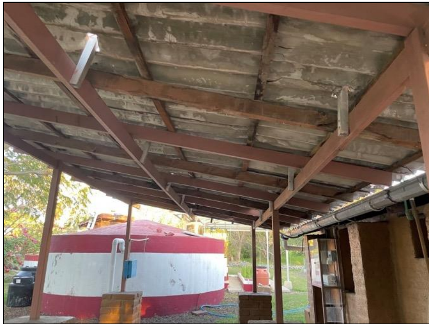
Figura 53. Canaletas en mal estado.
