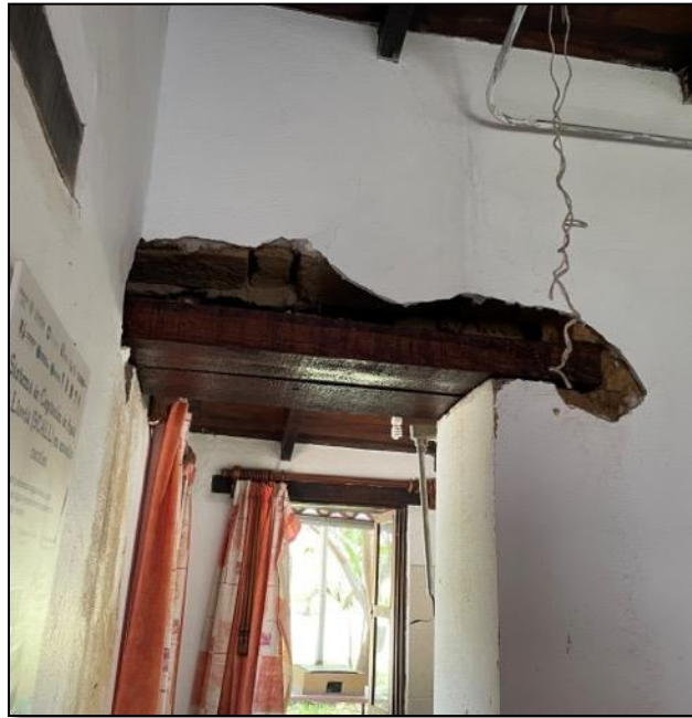
Figura 15. Colocación de vigas de madera nuevas
