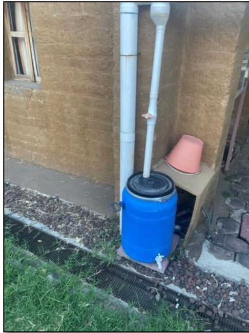
Figura 55. Separador de primeras lluvias.
