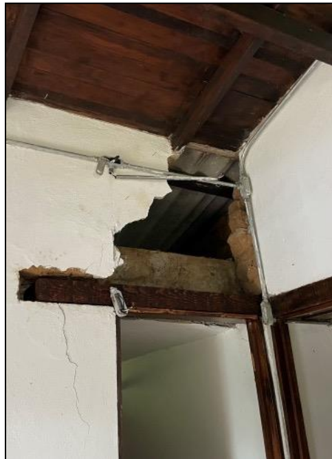
Figura 9. Viga de madera nueva colocada sobre la puerta de acceso al baño.
