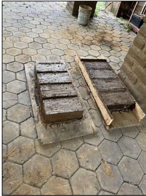
Figura 8. Adobes realizados y en secado
