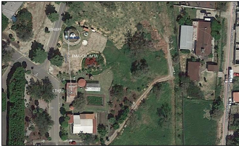
Figura 45. Estaciones de medición en las Casas Ecológicas del IMTA
