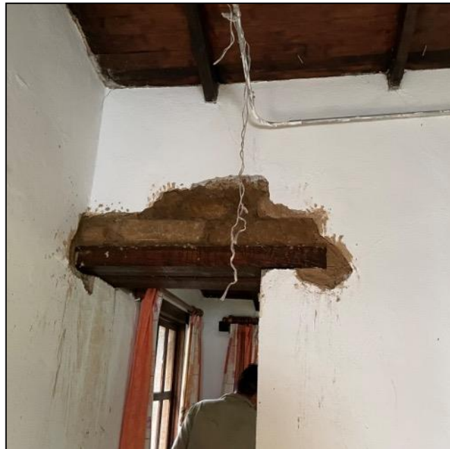
Figura 16. Reparación de muro de adobe sobre las vigas.
