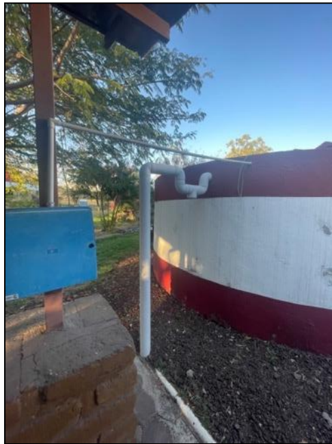
Figura 55. Separador de primeras lluvias.
