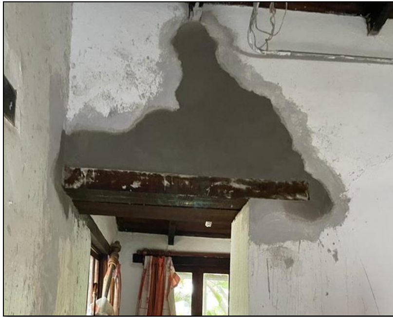
Figura 17. Aplanado en muro de adobe reparado.
