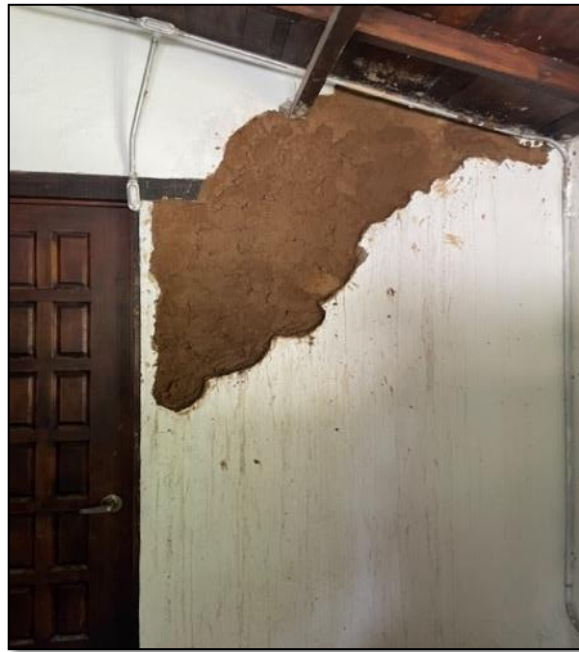
Figura 20. Reparación del aplanado en muro de adobe.
