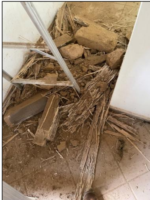
Figura 14. Escombro del retiro de viga y muro de block
