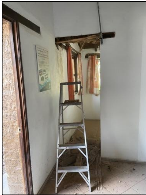
Figura 13. Retiro de viga dañada en acceso a la cocineta
