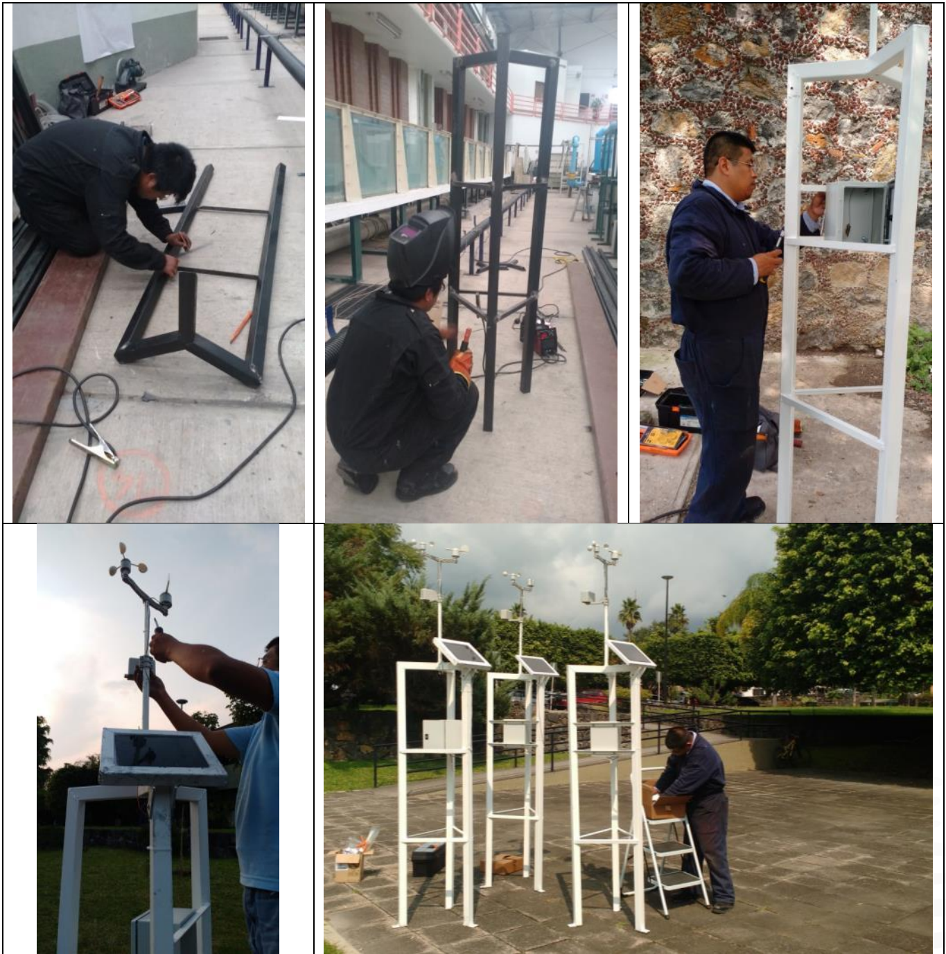
Ilustración 6.7 Proceso constructivo de las estaciones de medición de lluvia
