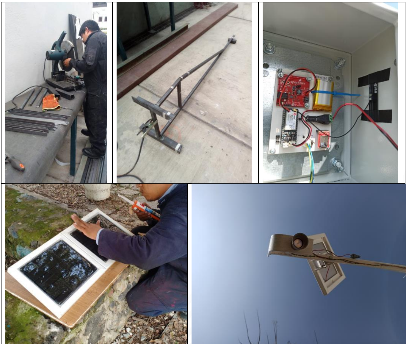
Ilustración 5.7 Proceso constructivo de las estaciones de medición de nivel
