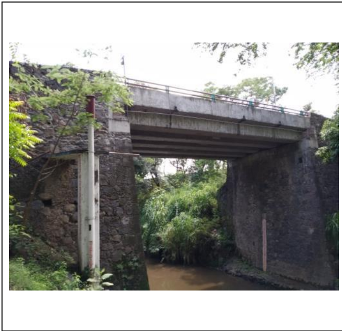
Puente para instalar punto de monitoreo 2
