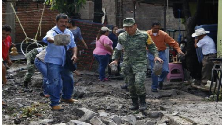
Ilustración 4.16 Más de 250 casas afectadas por las lluvias
