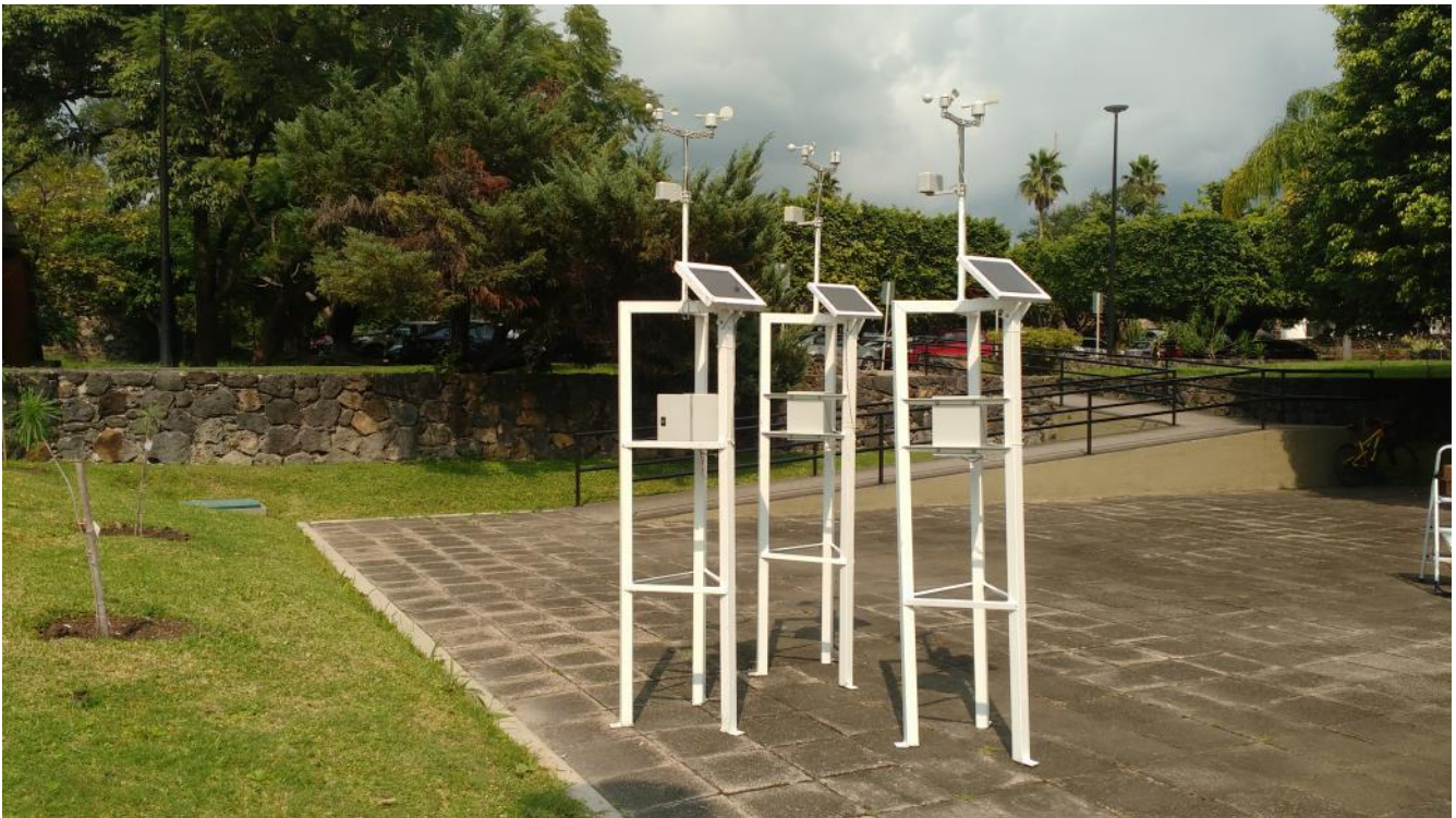
Ilustración 8.1 Instalación de sistemas de monitoreo de lluvia dentro del IMTA
