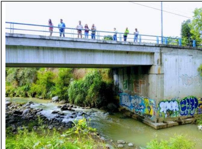
Puente para instalar punto de monitoreo 1
