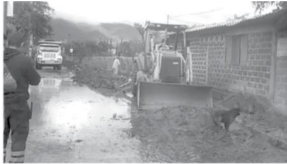
Ilustración 4.15 Los trabajos de limpieza iniciaron desde la mañana de ayer
