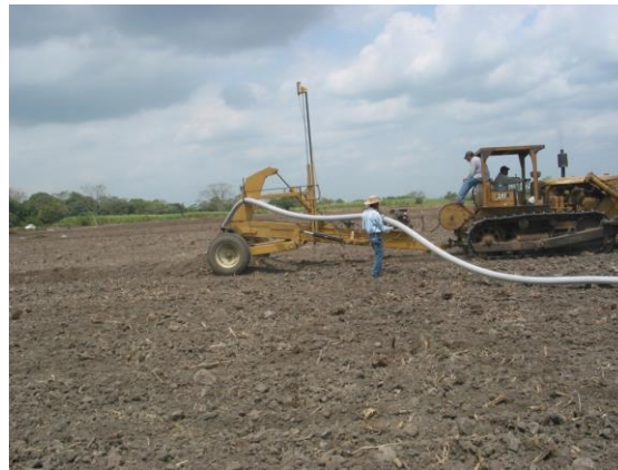
Figura 2.22 Instalación de drenaje subterráneo parcelario controlado
