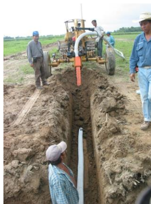
Figura 2.14 Instalación de drenaje subterráneo parcelario controlado
