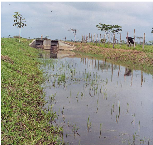
Figura 2.2 Manejo del régimen de humedad en el suelo con drenaje superficial semicontrolado
