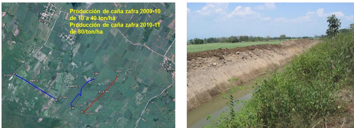
Figura 3.11 En Cantón San Fernando se construyeron 15 km de drenes superficiales y se incrementó la producción de caña
