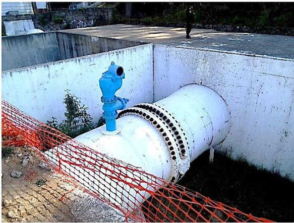
Condición inicial de la salida de la Línea 1, del tanque de almacenamiento junto a la torre de oscilación 5, el día 24 de noviembre de 2017. En preparación la nueva Línea 1.
