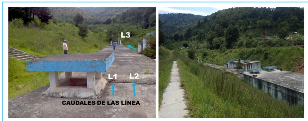
Ilustración 5.249 Portal de entrada Túnel Analco – San José donde descargan 3 líneas del sistema Cutzamala
