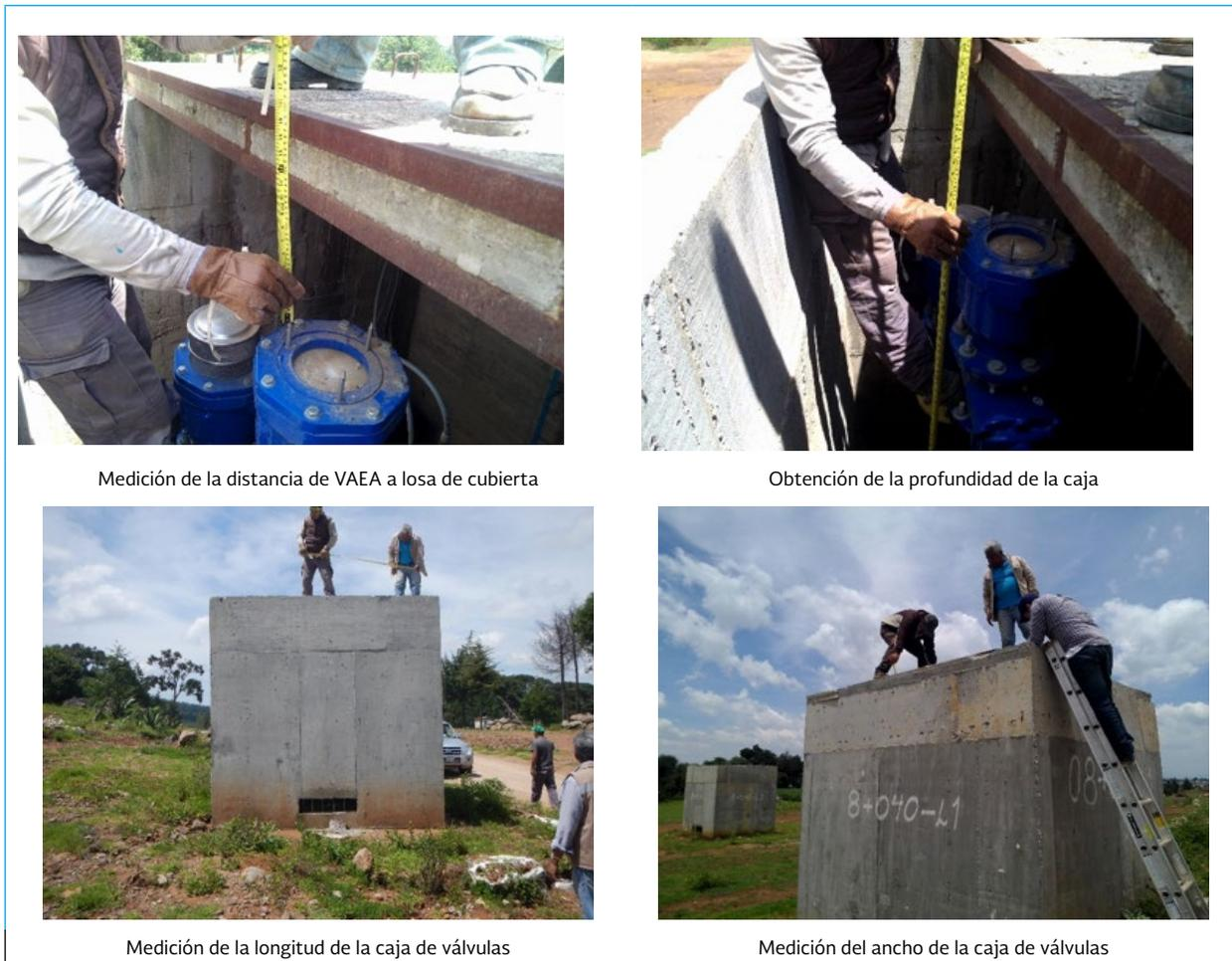
Ilustración 5.31 Medición de cajas de VAEAs
