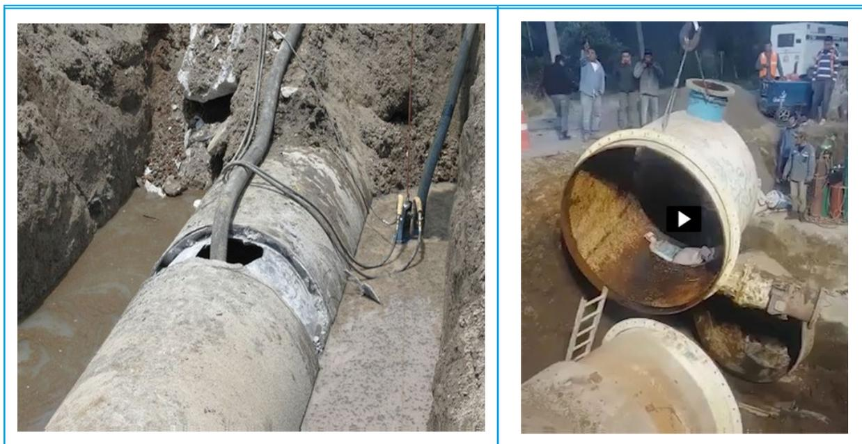
Ilustración 5.189 Reparación de fuga en la línea 1 del Sistema Cutzamala. Fuente: Conagua
