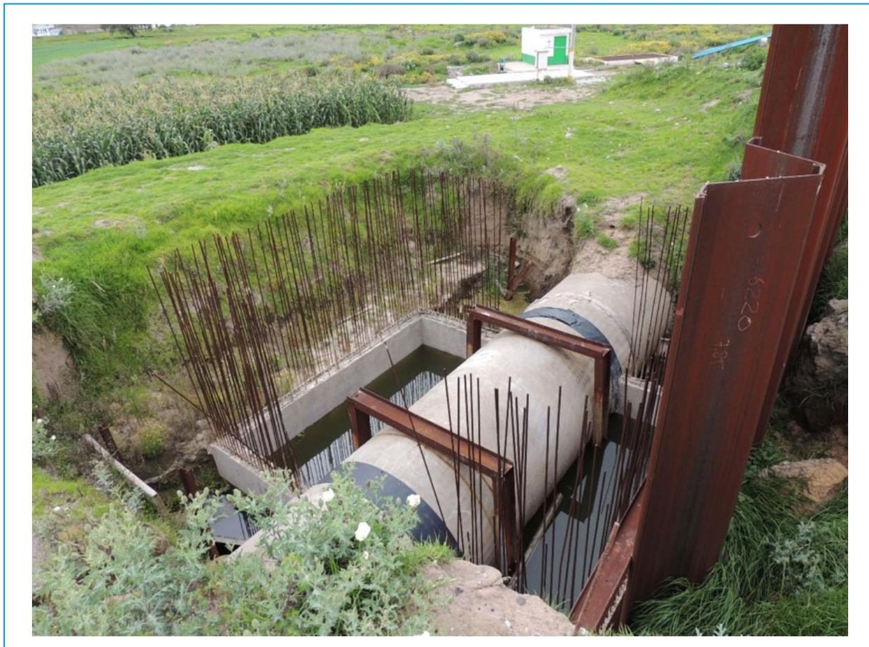
Ilustración 5.62 Avance de la obra del proyecto de OCAVM de válvulas intermedias entre los tanques
