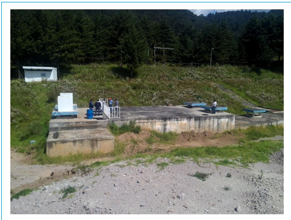
Ilustración 5.127 Estructura de transición al túnel Analco - San José
