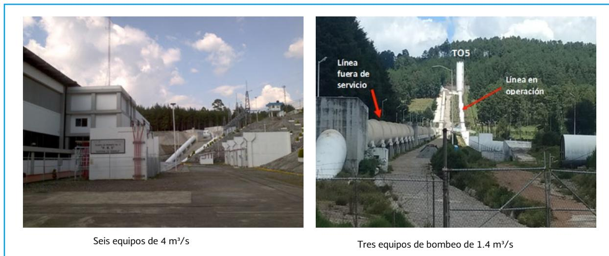
Ilustración 5.211 Planta Bombeo No. 5; dos líneas de conducción, una abastece a Torre de Oscilación No. 5
