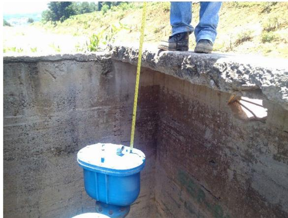
Realizando mediciones techo de la VAEA a techo de la losa
