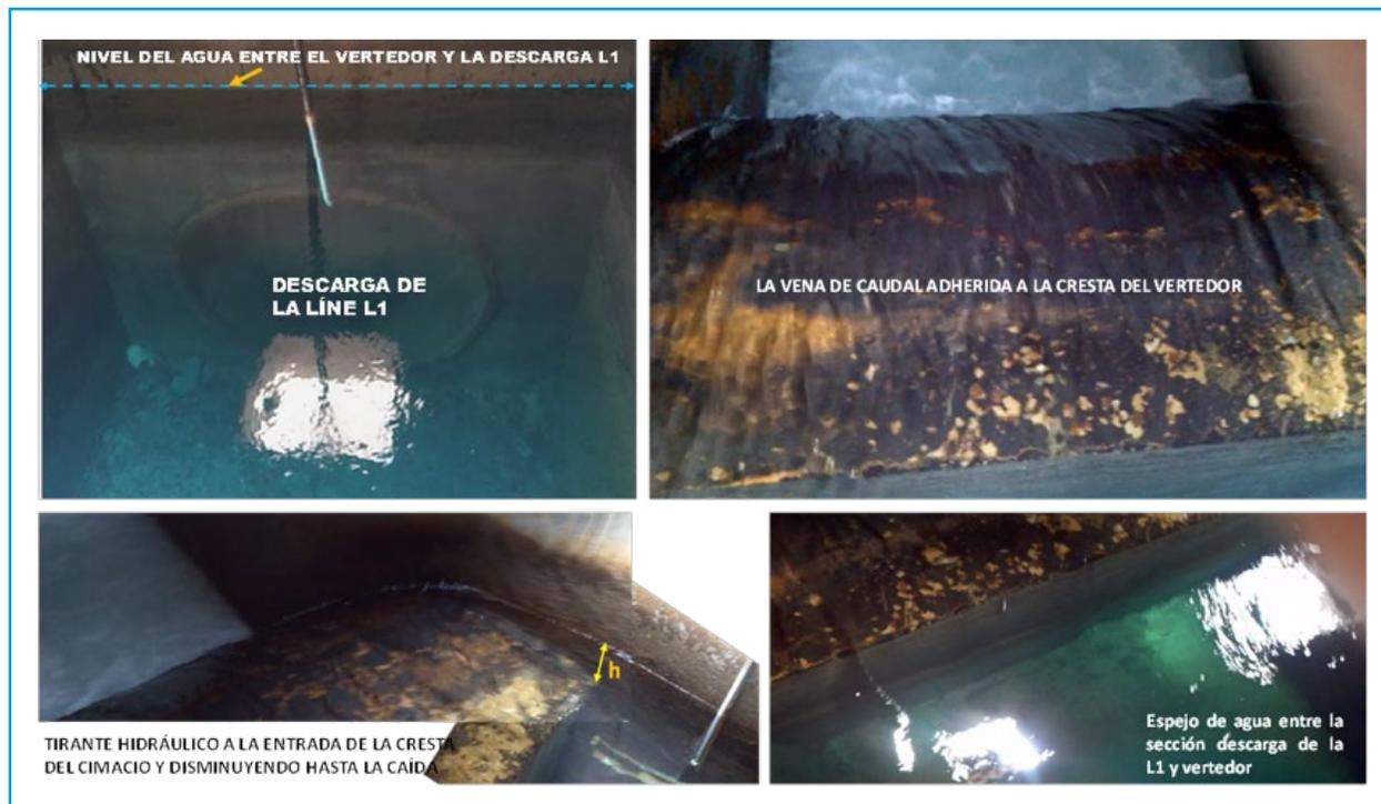
Ilustración 5.257 El caudal de descarga de la L1 se mantiene tranquilo sin turbulencia diferencia de la L2
