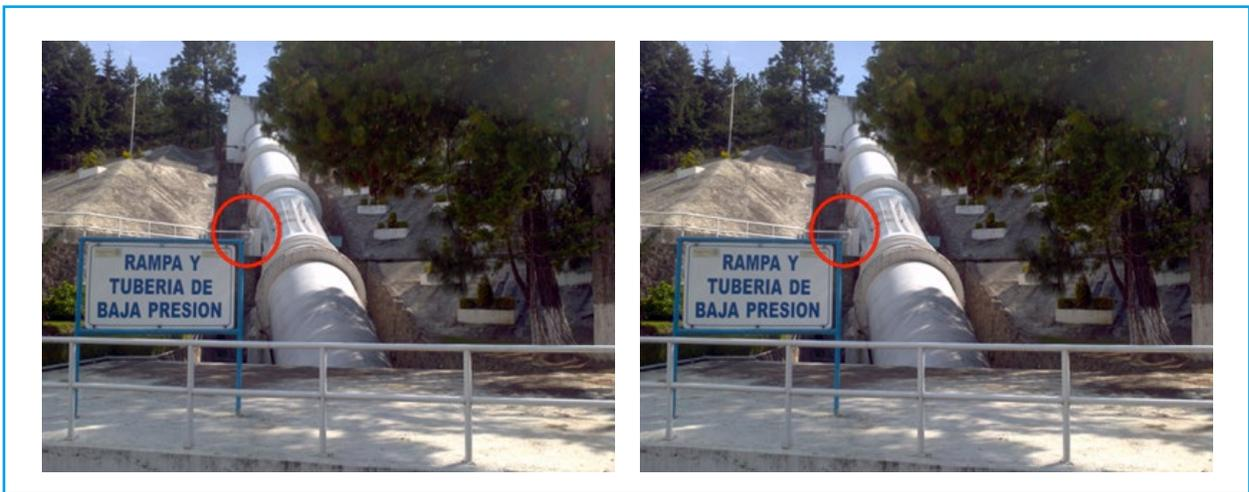
Ilustración 5.215 Tramo de tubería de interconexión cónica 99" x 70" a la Torre de Oscilación No.5
