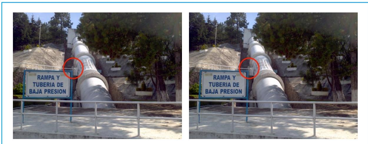
Ilustración 5.209 Sitio de medición de caudal y equipo diferencial de mercurio
