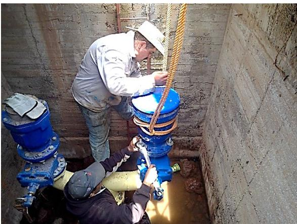
Instalando la VAEA con arreglo para manómetro
