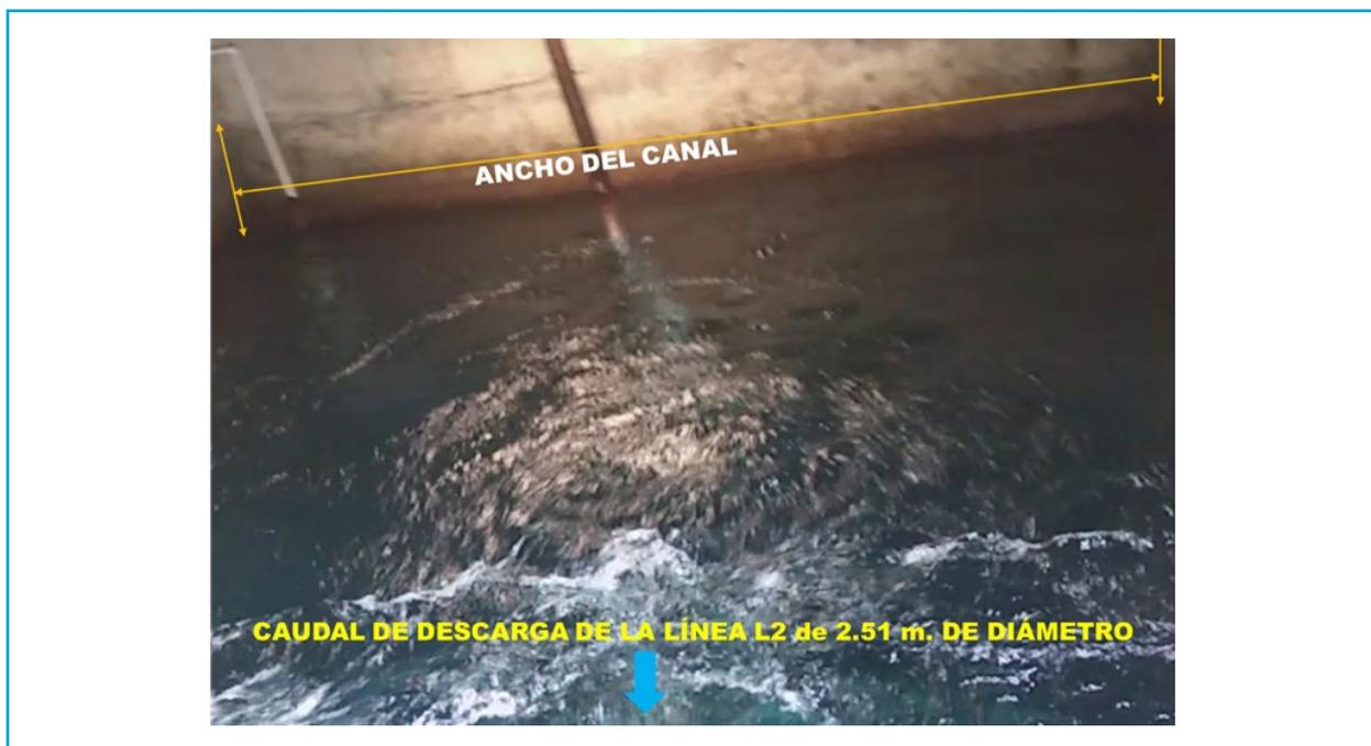
Ilustración 5.252 Llegada de caudal de la L2 en Túnel Analco en un área de 20 m<sup>2</sup> para verter por un cimacio
