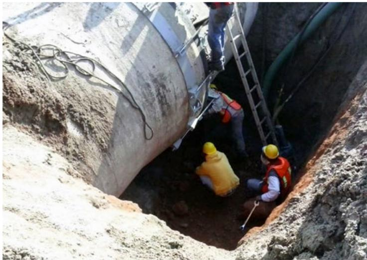
Ilustración 5.192 Trabajos de reparación de la fuga en línea 2. Fuente: CAEM
