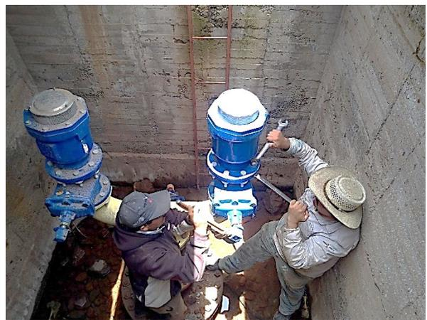
Preparando el desmontaje de la VAEA: cierre de la válvula de seccionamiento de la VAEA y quitando tornillos de la brida
