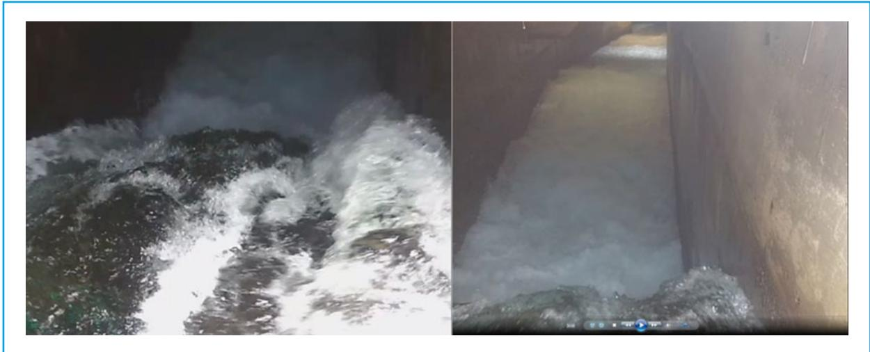
Ilustración 5.255 Flujo turbulento sobre la cresta y en canal de transición por la caída libre del flujo
