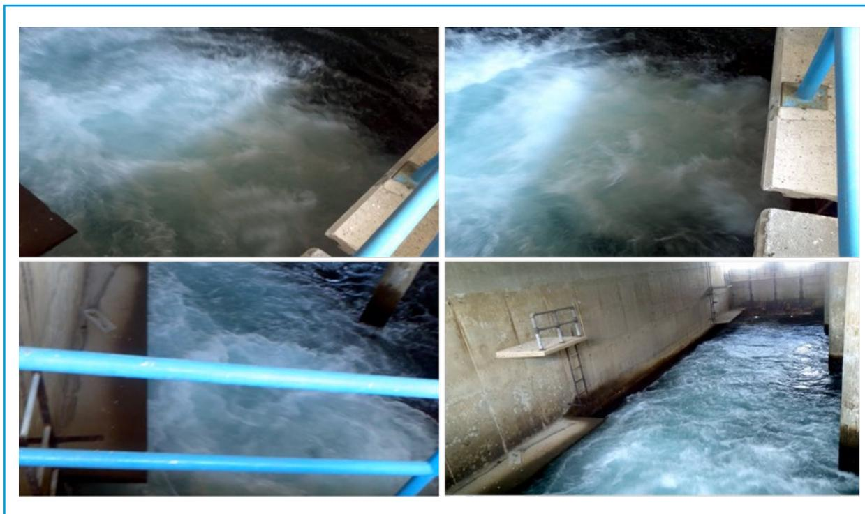
Ilustración 5.230 Turbulencia en el caudal de la Línea 2 ocasionada por el vertedor tipo cimacio
