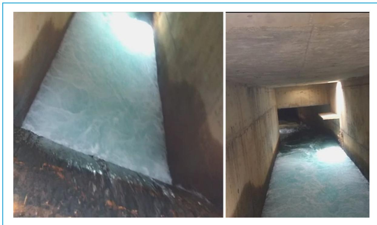
Ilustración 5.258 Canal de transición de la L1 con turbulencia
