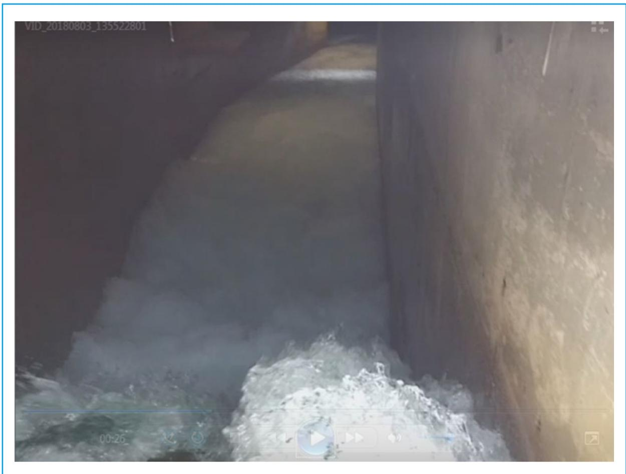
Ilustración 5.254 Flujo turbulento sobre la cresta del vertedor y turbulencia en toda la trayectoria del canal
