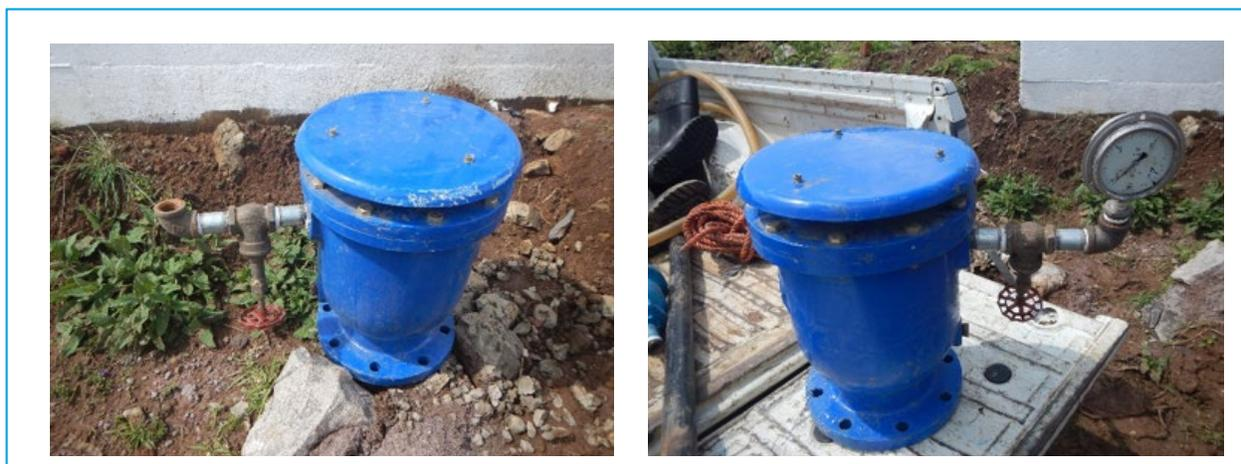
Ilustración 5.29 VAEA habilitada por la cuadrilla de mantenimiento del Sistema Cutzamala para la toma de presión
