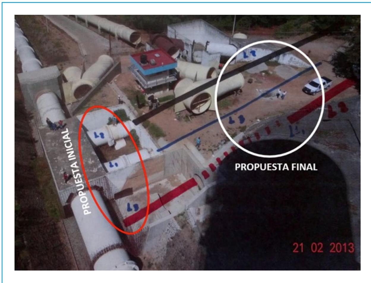
Ilustración 5.213 Propuesta de instalación de líneas de conducción inicial y final
