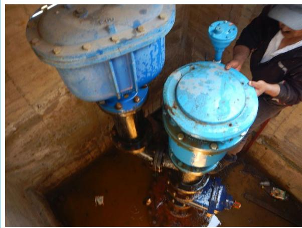
Arreglo de la VAEA, se intentó tomar presión en la salida de la eliminadora pero no sellaba el flotador de la VAEA, dejándola en su estado inicial, cerrada la válvula de seccionamiento general. Se espera en que en los siguientes días se cambie la VAEA.
