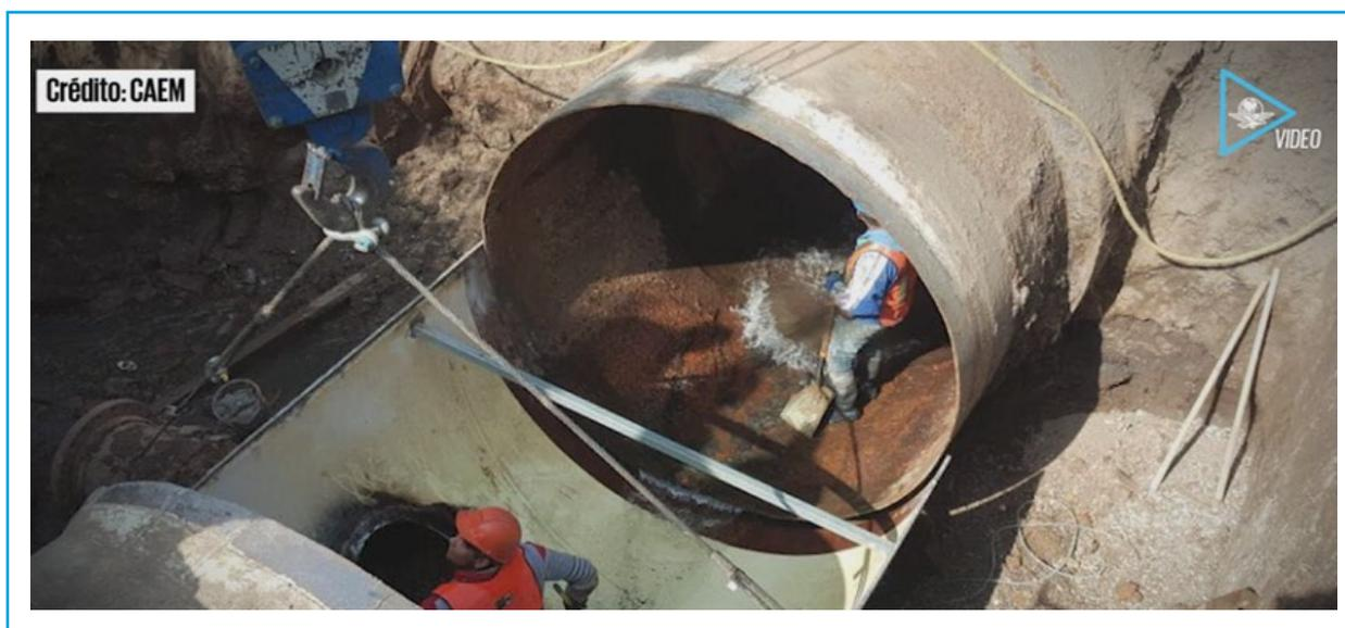
Ilustración 5.190 Color rojo o anaranjado que presenta la corrosión en la parte inferior del tubo. Fuente: CAEM
