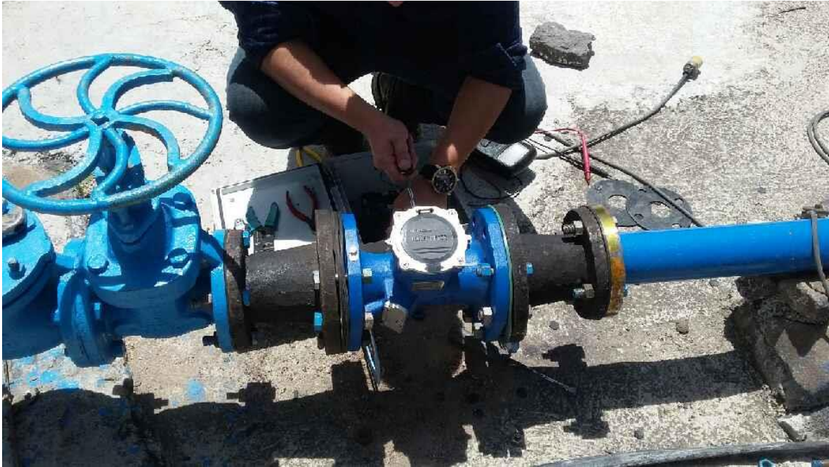
Figura 3.9.2 Instalación de flujómetro en el pozo de Punta de Obrajuelo
