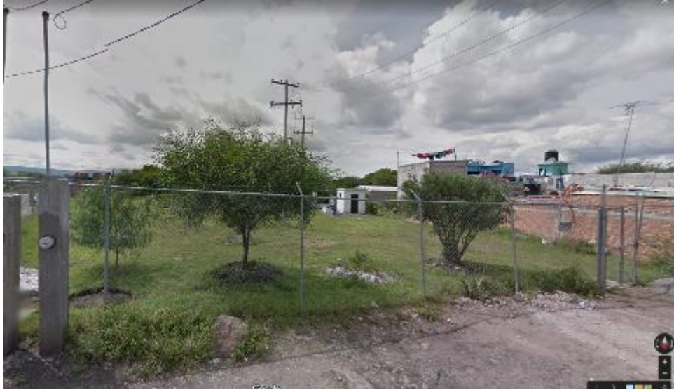
Figura 3.5.9 Pozo de agua potable San Isidro del Llanito
