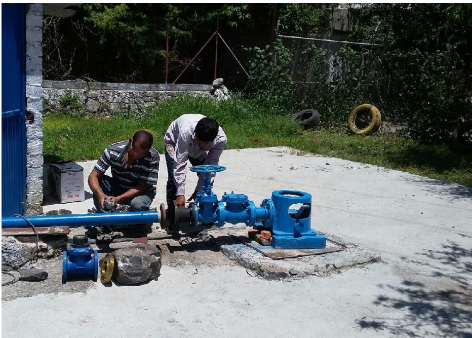
Figura 3.9.1 Instalación de flujómetro en el pozo de Punta de Obrajuelo
