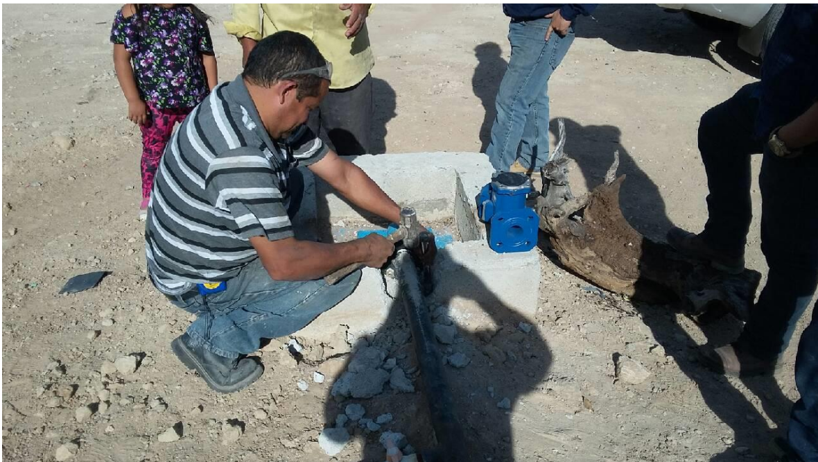
Figura 3.9.3 Instalación de flujómetro en el pozo de San Bartolomé
