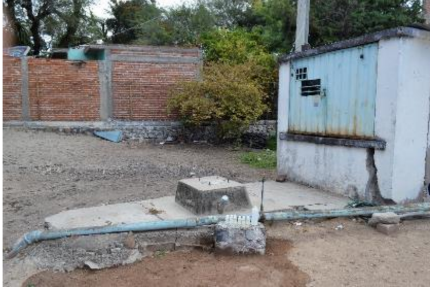
Figura 3.5.13 Muestra 2 Pozo de agua potable Punta de Obrajuelo
