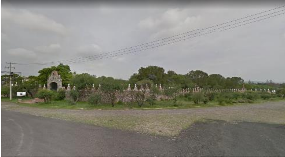
Figura 3.5.11 Pozo Hotel La Pitaya
