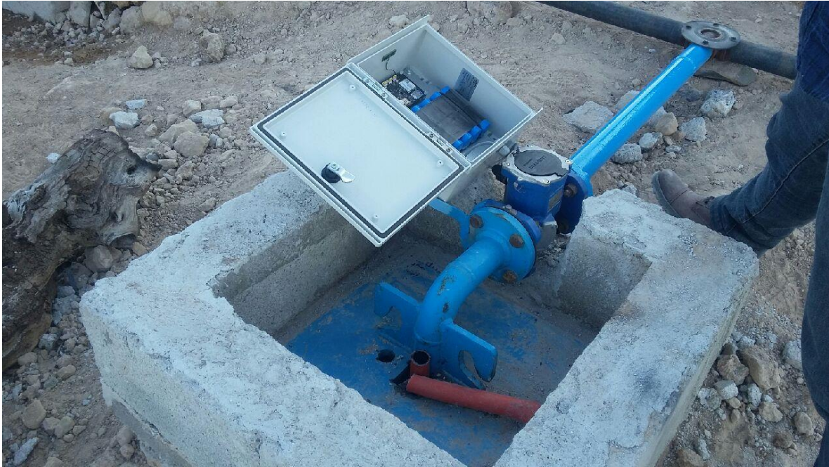
Figura 3.9.4 Instalación de flujómetro en el pozo de San Bartolomé
