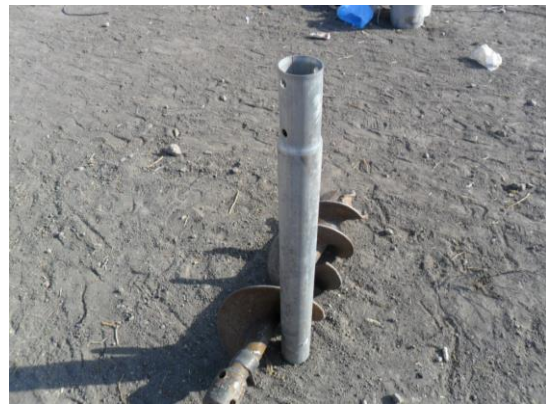
Figura 2.14 Cimientos del invernadero para mayor estabilidad
