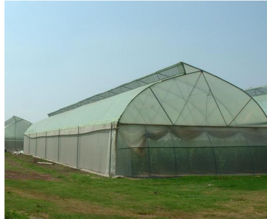
Figura 2.7 Orientación norte-sur del invernadero a dos aguas
