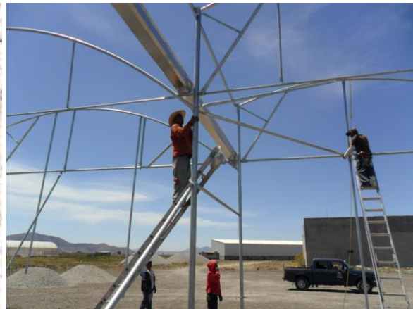
Figura 2.21 Colocación de canaleta para captación de lluvia
