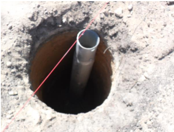
Figura 2.20 Perforación para la colocación del concreto en la base de la estructura
