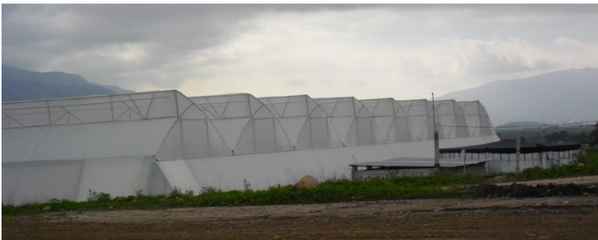
Figura 2.18 Invernadero multimodular de ocho capillas tipo cenital
