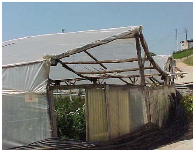
Figura 2.28 Construcción básica a base de madera (FAO, 2004)
