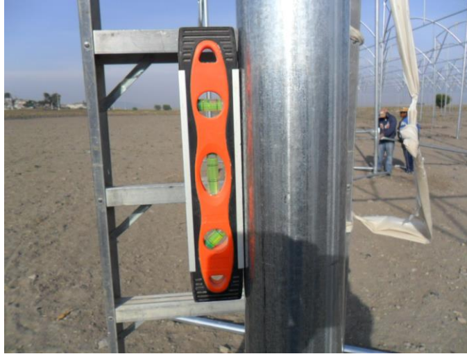
Figura 2.11 Nivelación vertical del invernadero para definir altura del mismo
