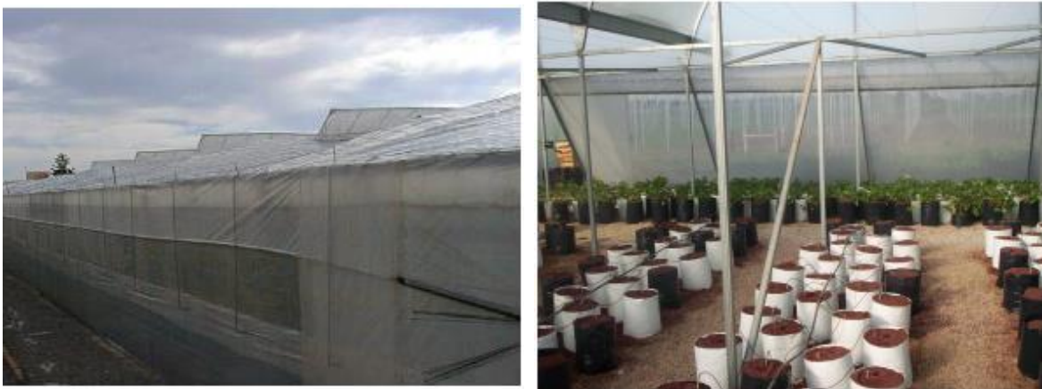
Figura 2.25 Estructuras alternativas con refuerzos en el interior
