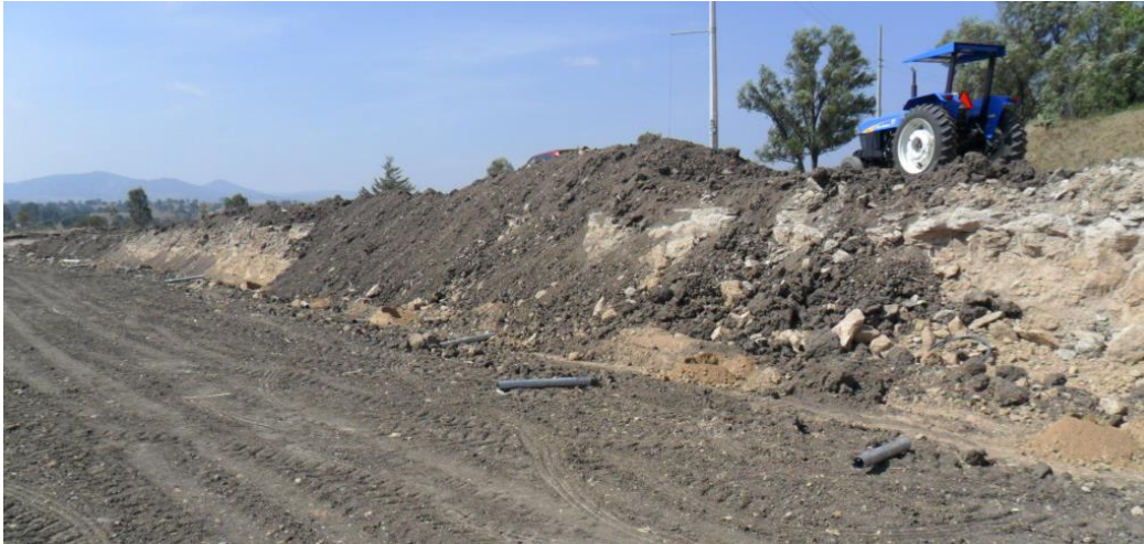
Figura 2.19 Preparación del terreno para el invernadero multimodular
