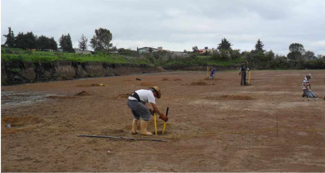
Figura 2.22 Preparación del terreno para la base de la estructura multimodular
