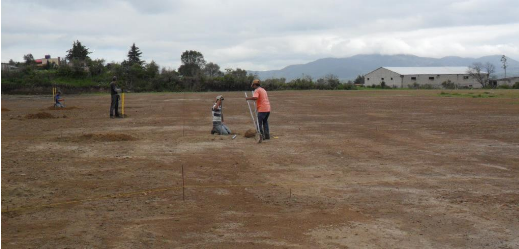
Figura 2.17 Trazo y nivelación del invernadero multimodular
