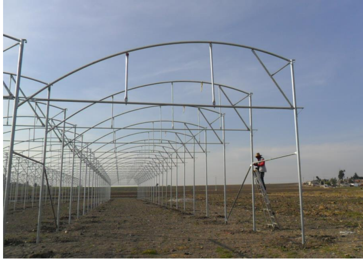
Figura 2.9 Curvatura de un invernadero cenital tipo sierra
