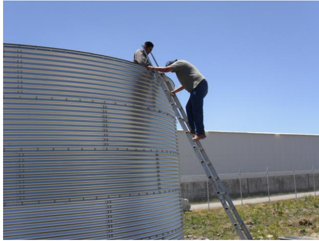
Figura 2.27 Almacenamiento de agua para suministro del invernadero
