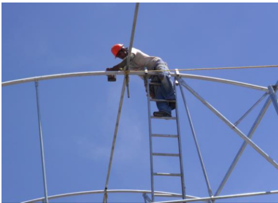
Figura 2.13 Ventilación cenital en la estructura
