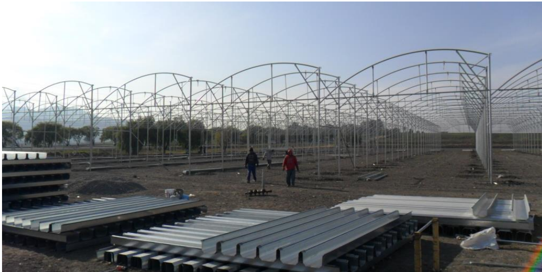
Figura 2.26 Levantamiento de la estructura vertical en un invernadero de 1 ha
