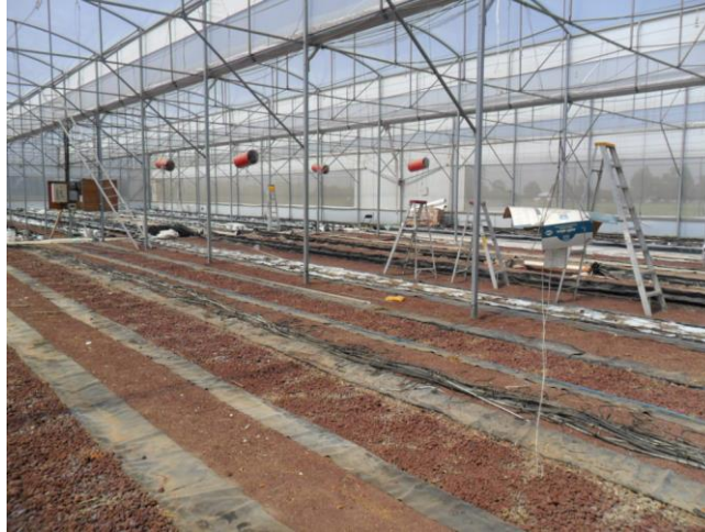
Figura 2.29 Sistemas alternativos de calefacción por mangueras
