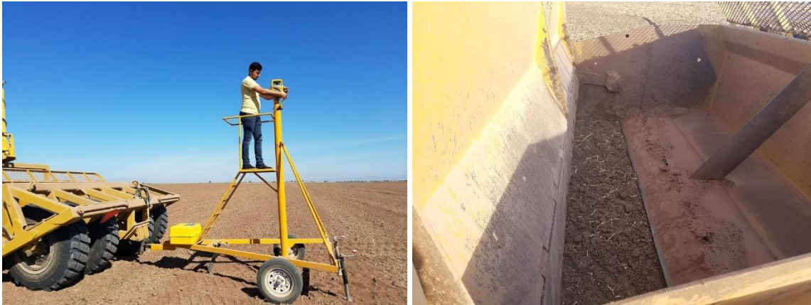
Figura 2.65 Supervisión de laser y escrepa.
