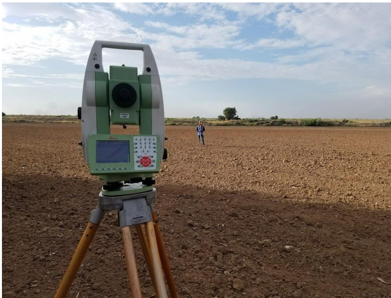
Figura 2.63 Proceso de verificación de la nivelación con Estación total.
