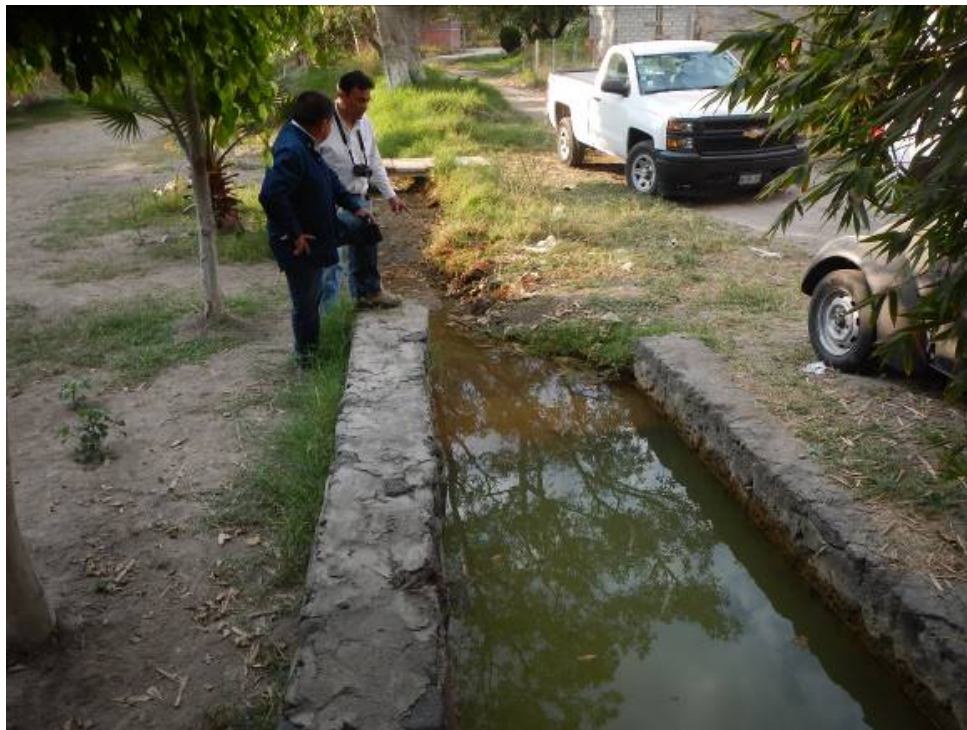
Figura 6.28 Descarga del manantial “Las Tortugas”.
