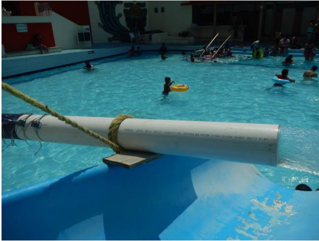
a) Salida del manantial principal "Agua Hedionda" mediante bombeo.
