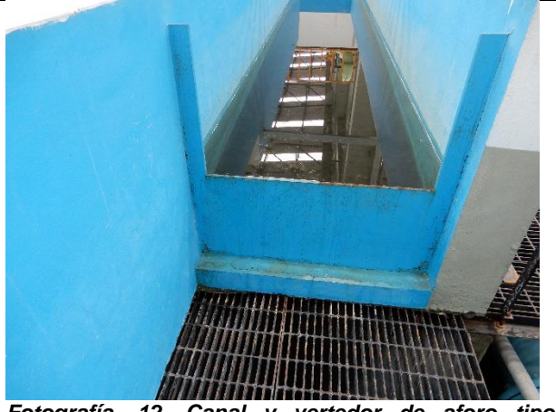
Fotografía. 12. Canal y vertedor de aforo tipo contracción lateral de 80cm de longitud vertedor.
