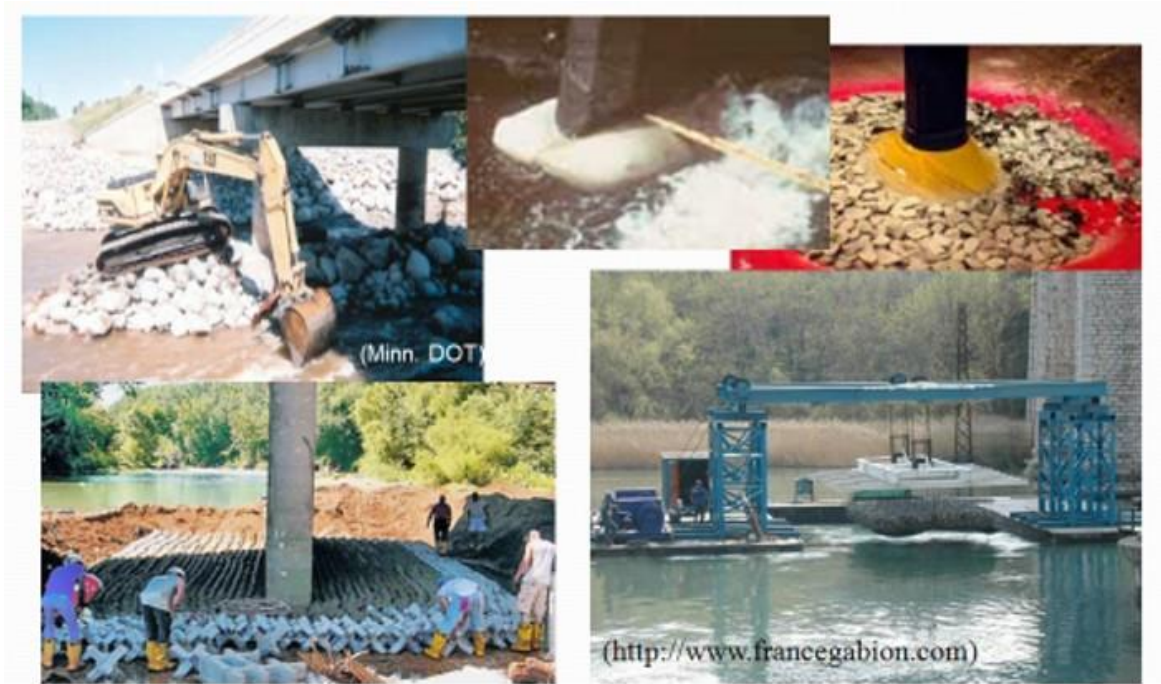
Ilustración 3. Diferentes medios de acción usados contra la socavación.
