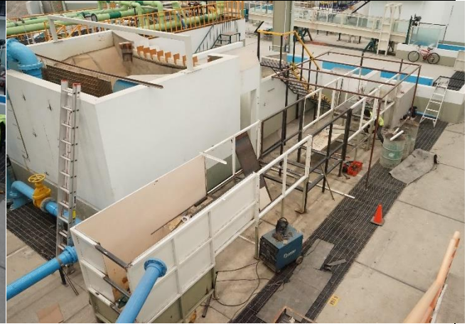
Fotografía. 4. Proceso de modificación del canal. Rearmado del canal final.
