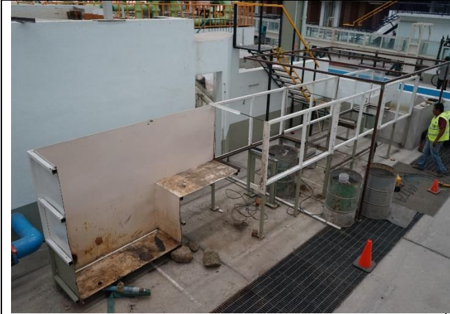
Fotografía. 3. Proceso de modificación del canal. Desarmado del canal original
