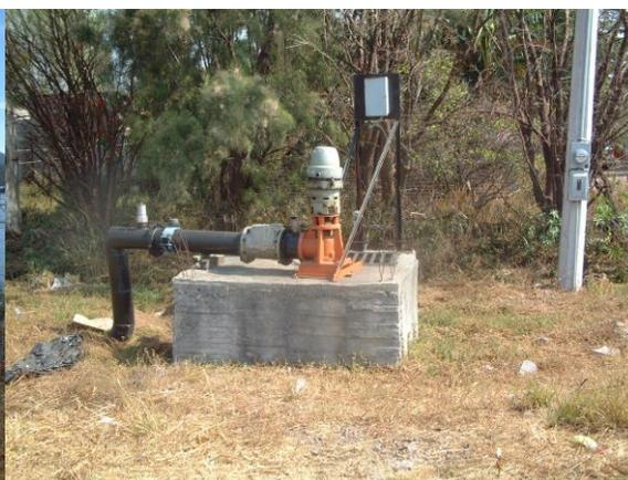
Foto 3.2 Equipo de bombeo ubicado en canales con nivel de agua inferior al nivel de las parcelas
