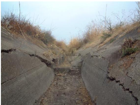
Foto 3.3. Problemas de rompimiento de la losa en algunos tramos del canal principal
