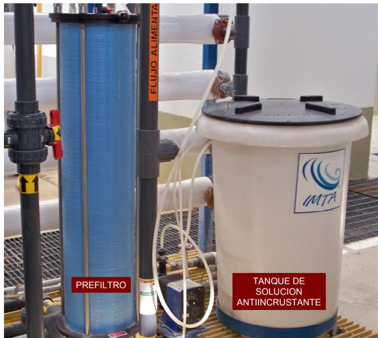
**Figura IV.6.2 Pretratamiento al banco de filtración: prefiltro y tanque de solución antiincrustante**
