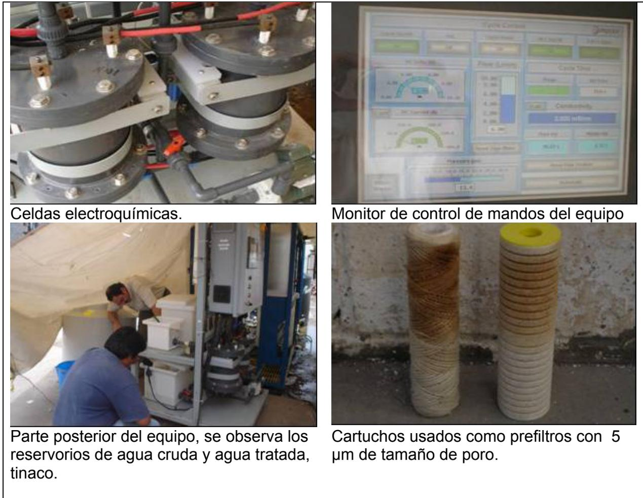
**Figura IV.3.2. Diferentes vistas del equipo de deionización capacitiva**
