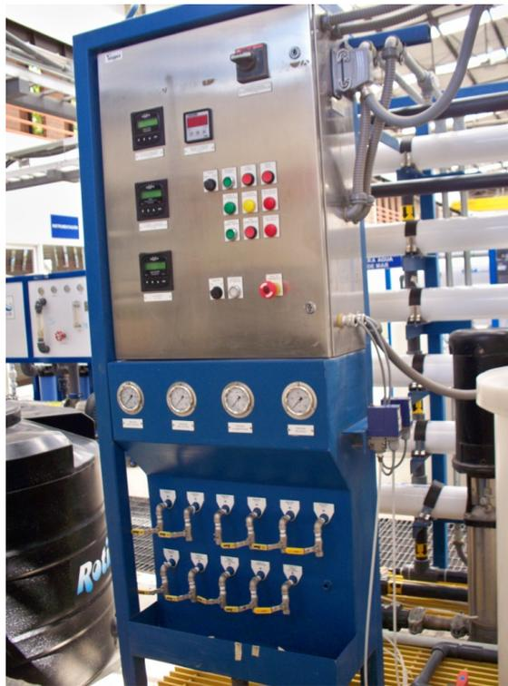
**Figura IV.6.7 Panel de control del proceso**
