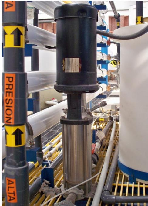
Figura IV.6.3 Bomba Grundfos de alta presión
