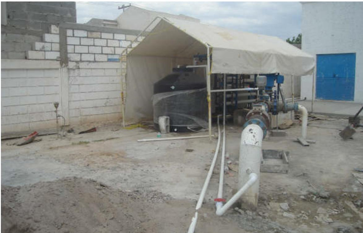
**Figura IV.6.8 Instalación del equipo de nanofiltración en el pozo 32R, incluye la línea de conexión del agua tratada a la red de distribución**
