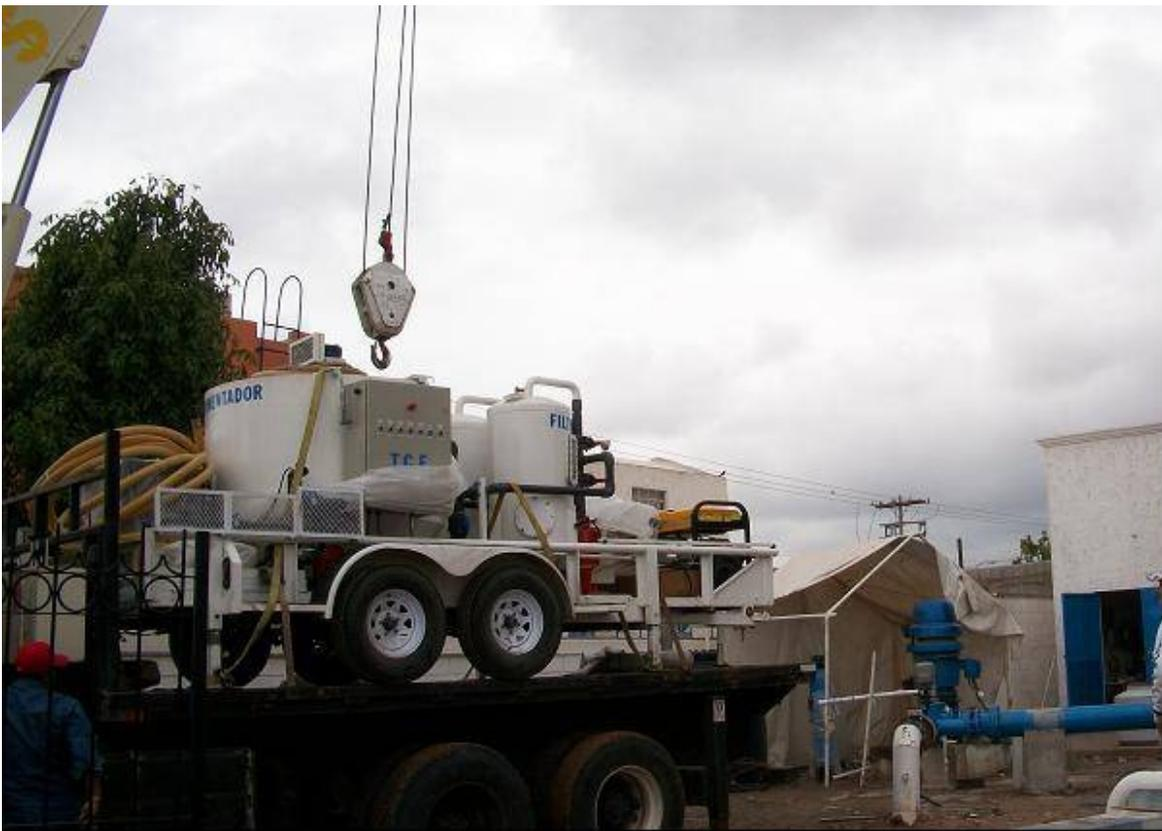
**Figura IV.2 9 Traslado e instalación de la planta piloto en el pozo 32 de Torreón Coah.**
