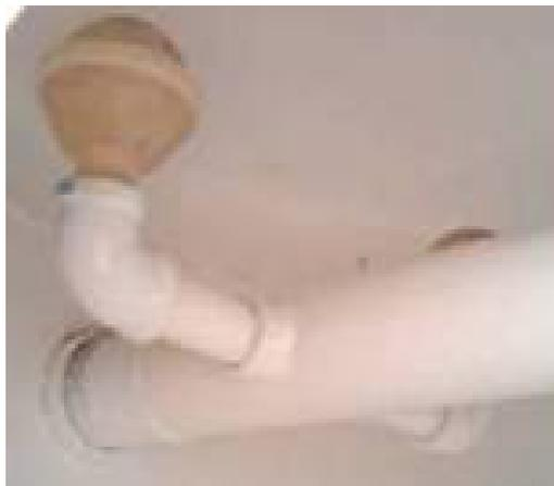
**Figura IV.2 6 Una de las cuatro hidroesferas colocada en el fondo del filtro.**
