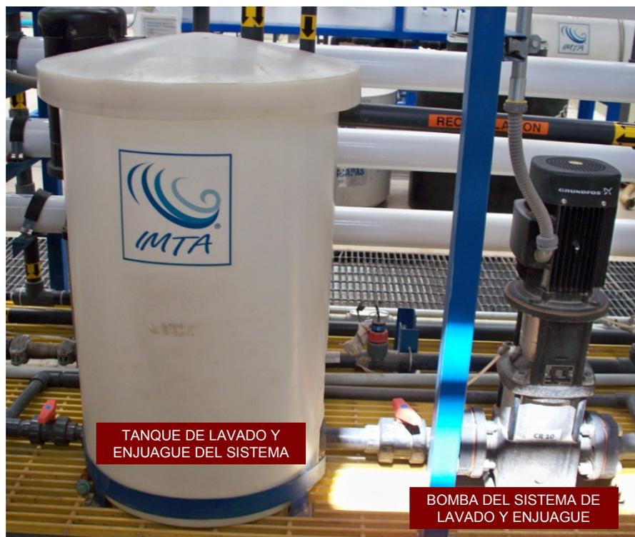
**Figura IV.6.6 Sistema de limpieza del proceso de nanofiltración**
