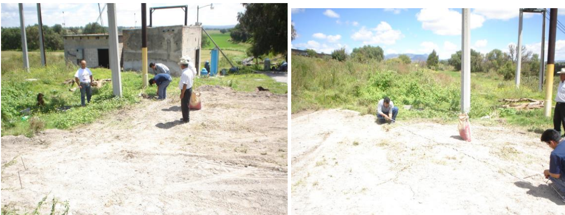
Fotos. 4.1 y 4.2 Realización del trazo para la instalación del invernadero en los sitios seleccionados.
