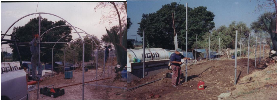
Fotos. 4.3 y 4.4 Instalación y construcción del invernadero en los sitios seleccionados.
