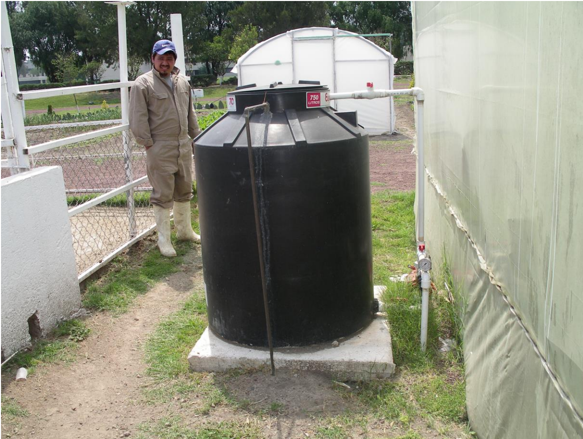
Foto 1.9. Tanque de agua con la solución nutritiva. Módulo de producción de forraje verde hidropónico del Colegio de Postgraduados, Montecillo, Edo. De México.
