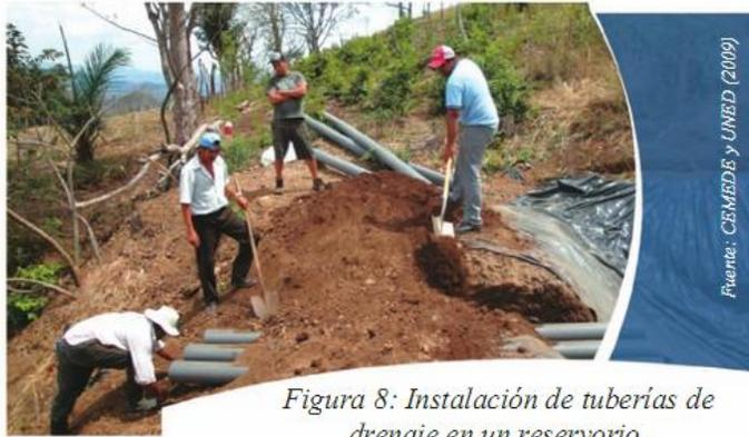
*Figura 8: Instalación de tuberías de drenaje en un reservorio.*
