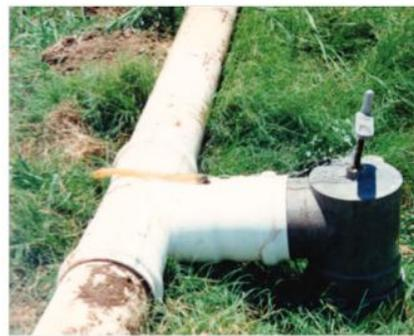
Ilustración 3. Codo de arranque.
