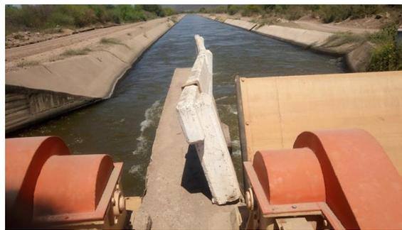
Estructura de protección colapsada
