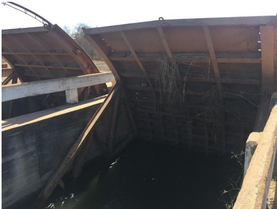
Figura 2.12 Compuertas con fisuras y dañadas en represa del km 92+572 (KM 88+406).
