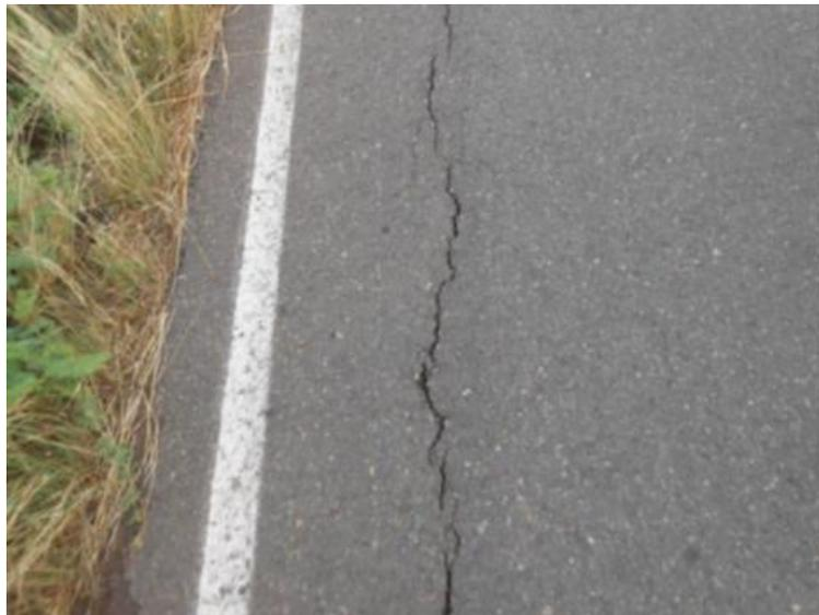
Figura 5.88 Detalla de la grieta longitudinal sobre la corona del Dique Palos Amarillos.
