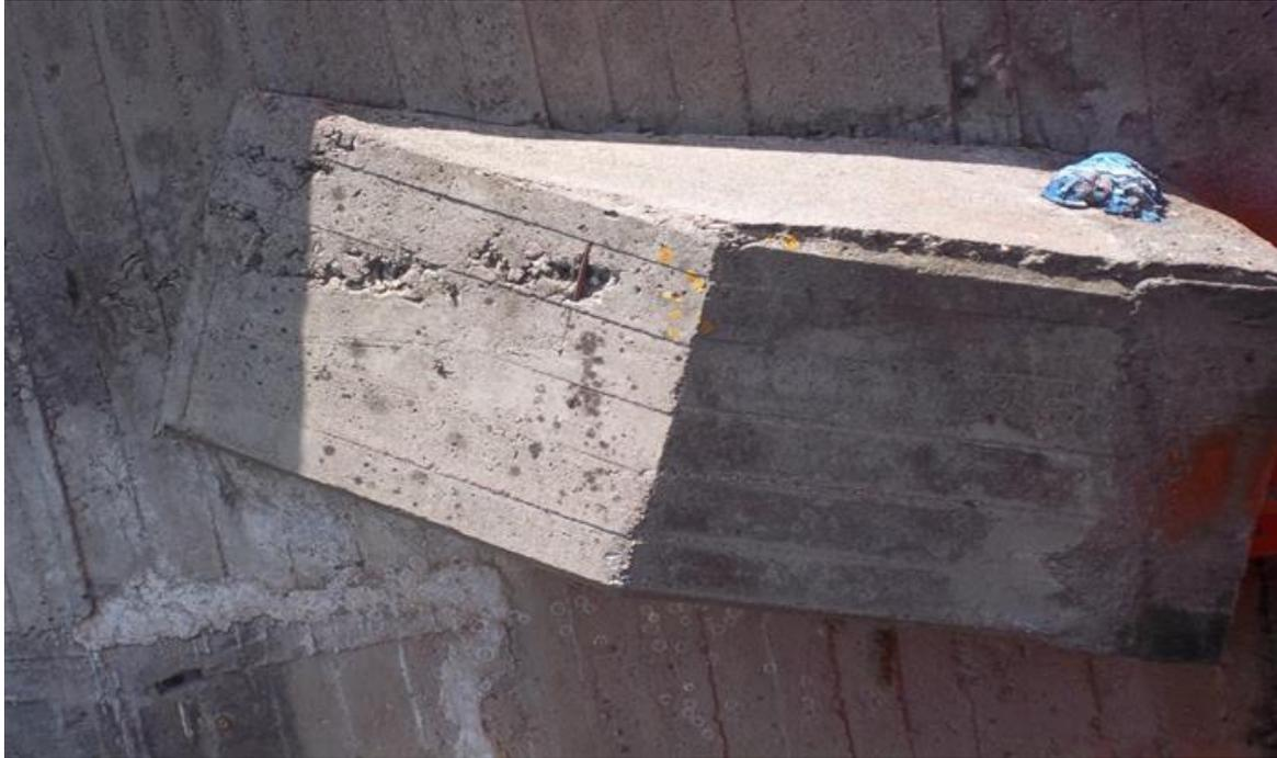
Figura 1.41 Ménsulas de las compuertas.
