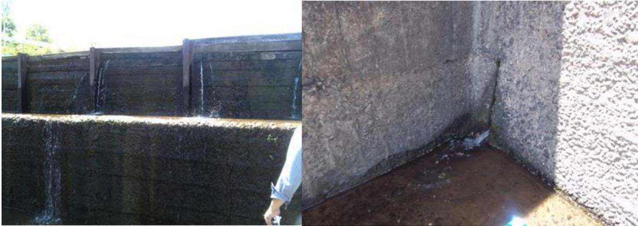
Figura 1.31 Agujas de la presa PDAW y fisuras en la pantalla de la PDAW.
