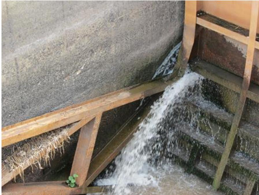
Figura 2.5 Fisuras y Oxidación en compuerta en la represa Km 60+892 (KM 55+984).
