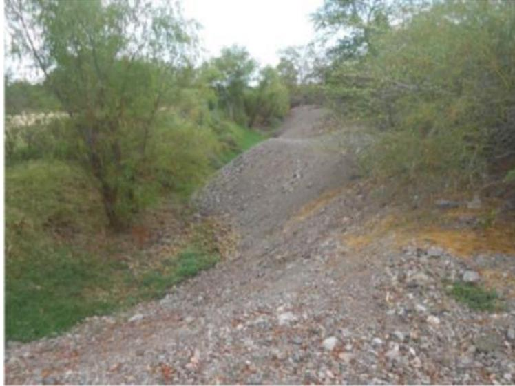
Figura 5.86 Material del Dique Palos Amarillos depositado al pie del talud.
