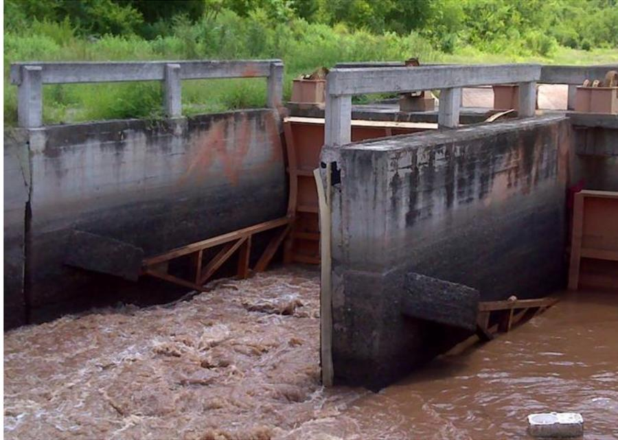
Figura 2.15 Deterioro de Concreto en la represa del km 107+511 (KM 103+206).
