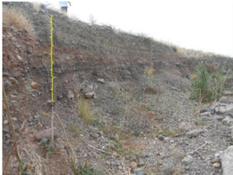
Figura 5.82 Aspecto de las capas de material compactado.
