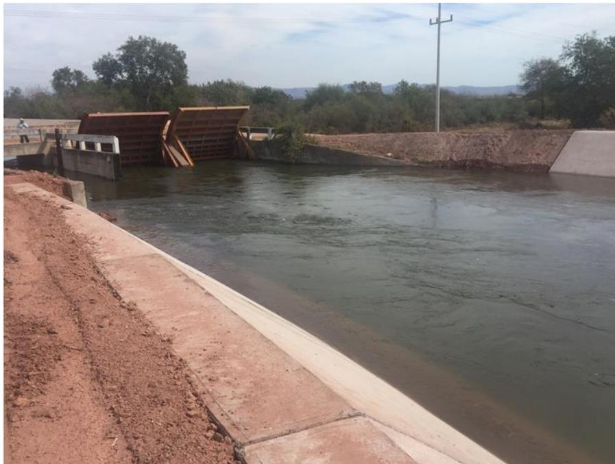
Figura 2.8 Zonas de talud sin recubrimiento en la represa del km 73+221 (KM 68+090).
