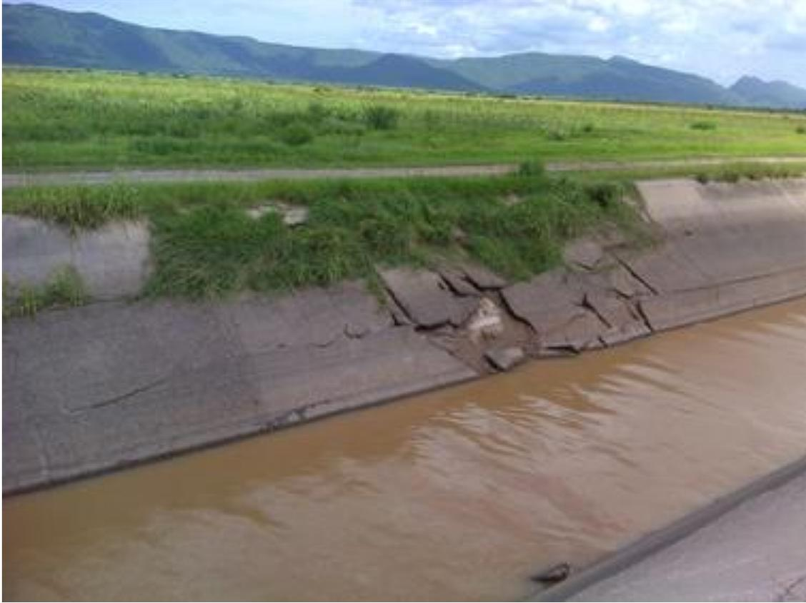
Figura 4.4 Losas dañadas en el CPH.
