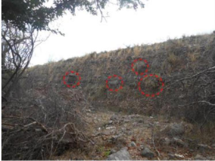
Figura 5.83 Enrocamiento dentro del terraplén compactado.
