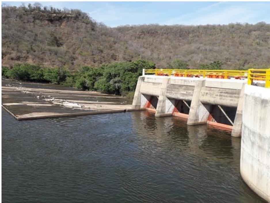
Figura 1.40 Panorámica de la entrada al canal desarenador controlada por tres compuertas radiales.
