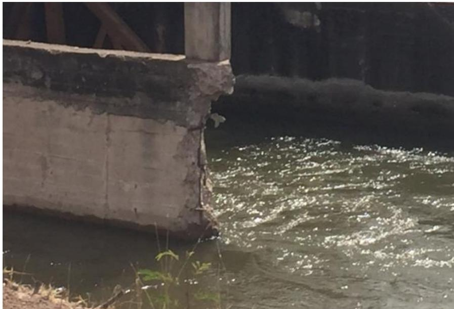
Figura 2.10 Deterioro de Concreto en la represa del km 82+809 (KM 77+720)
