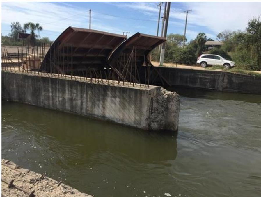
Figura 2.6 Acero de refuerzo expuesto en la represa Km 60+892 (KM 55+984).
