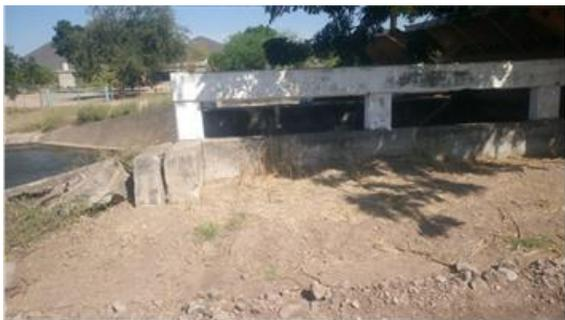
Desprendimiento de la losa de transición de salida y parapeto desplomado
