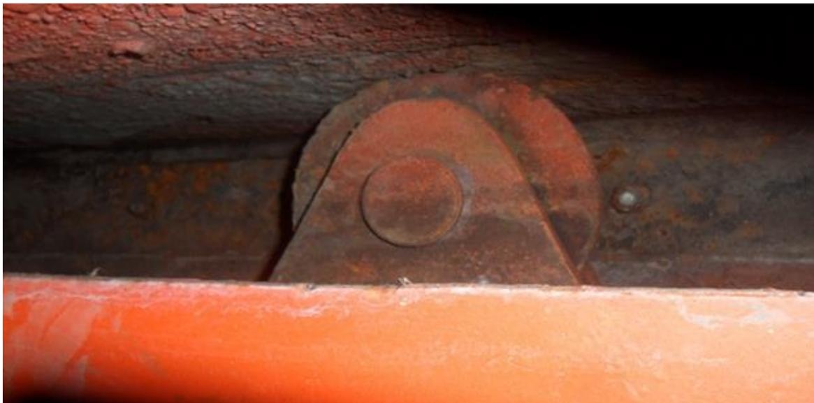
Figura 1.42 Mecanismos de apertura de las compuertas.
