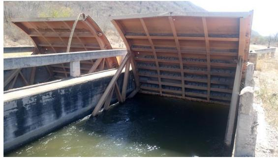
Protecciones de concreto reforzado destruido y expuesto al intemperismo
