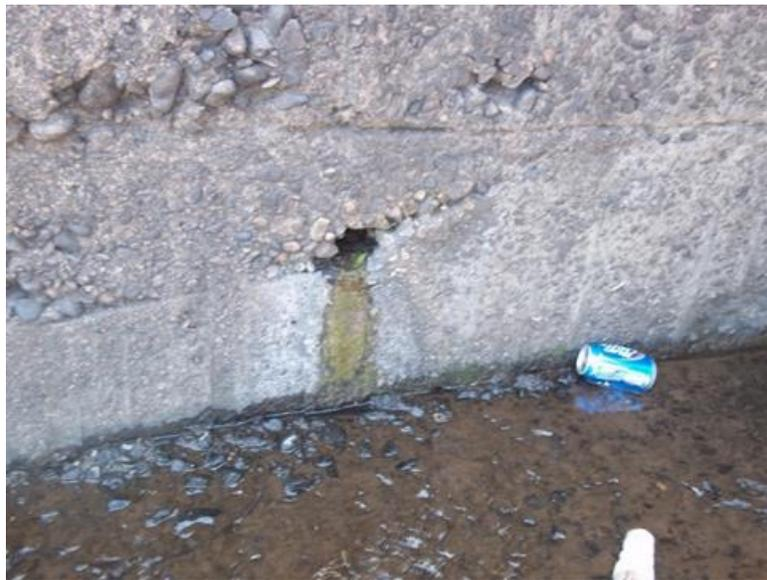
Figura 1.32 Fisuras en la pantalla impermeable de la PDAW.
