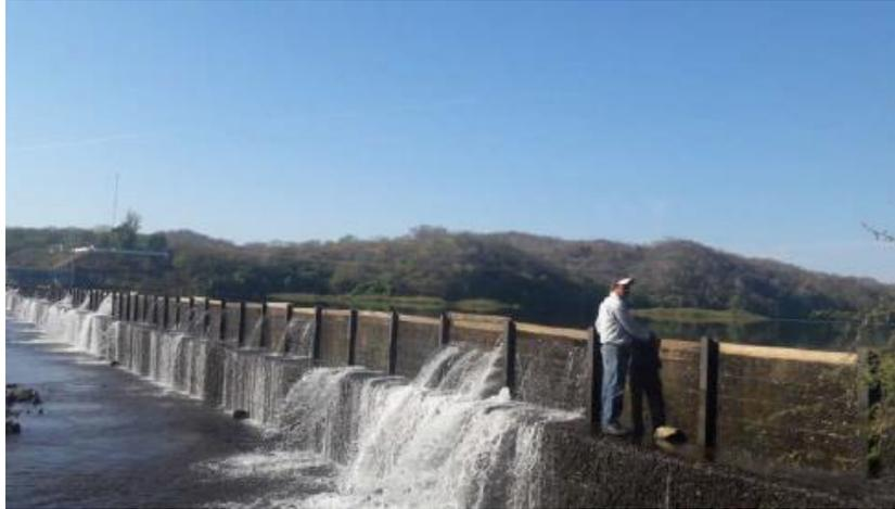
Figura 1.29 El nivel de la SLA coincide con el labio superior de los tabloncillos de madera.
