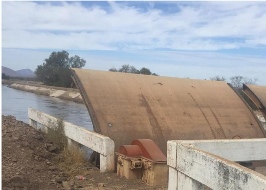
Figura 2.7 Fisuras en compuertas radiales en la represa del km 68+285 (KM 63+160).
