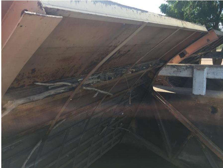
Figura 2.11 Compuertas con fisuras y dañadas en represa del km 87+735 (KM 83+659).
