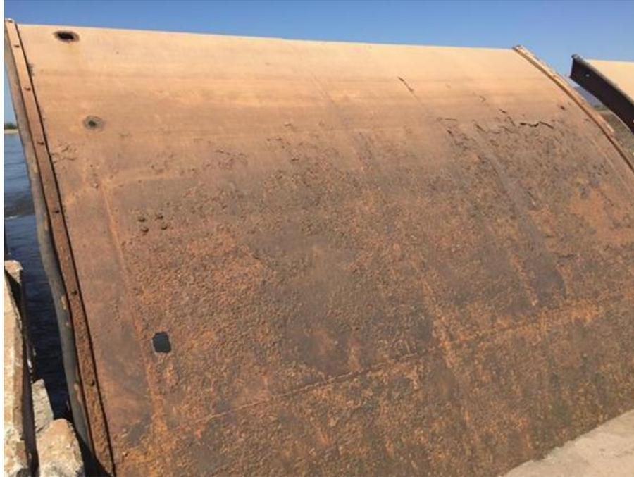
Figura 2.13 Compuertas dañadas y fisuradas de la represa del km 97+282 (KM 92+920).
