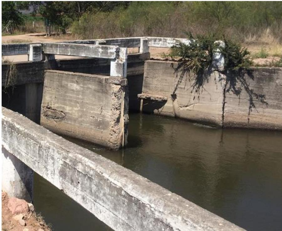
Figura 2.16 Deterioro del concreto de la represa km 111+182 (KM 106+359).
