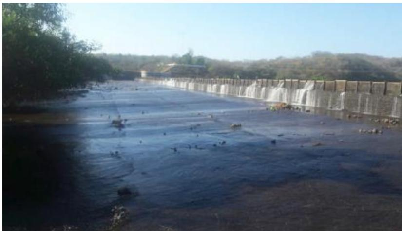
Figura 1.28 Fuga de agua a través de las aberturas que dejan los tablonces en malas condiciones.
