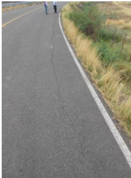
Figura 5.87 Grieta longitudinal sobre la corona del Dique Palos Amarillos.
