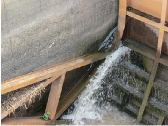
Compuerta radial con fisuras en placa de retención
