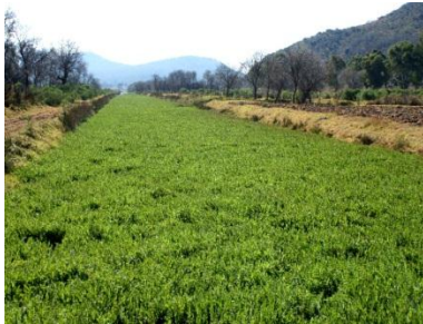
Fotografía IV-14. Otro aspecto de la infestación del dren por Berula erecta .
