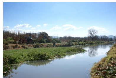
Fotografía IV-13. Otra vista de los mismos trabajos de limpieza en donde se observa parte del dren ya libre de malezas.
