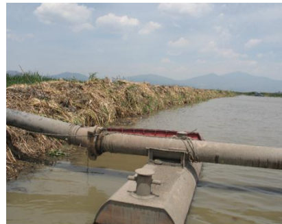
Fotografía IV-7. Formación de camellones de vegetación y sedimentos producto de las acciones de dragado.
