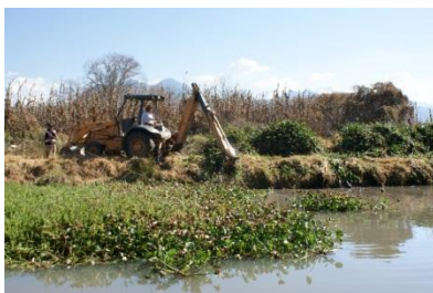
Fotografía IV-12. Aspectos de los trabajos de limpieza en el dren con maquinaria pesada y apoyo para agregar los tapetes de vegetación
