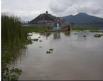
Fotografía IV-17 Despalotizador, vista del abrevadero cinco a Janitzio, inicio de trabajos 22 de octubre de 09
