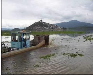
Fotografía IV-19 Vista del abrevadero cinco al área de trabajo, 22 de octubre de 2009
