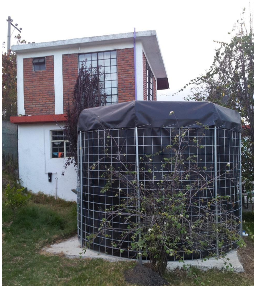
Figura 6. Tanque de almacenamiento de agua (Isla Urbana, 2012).
