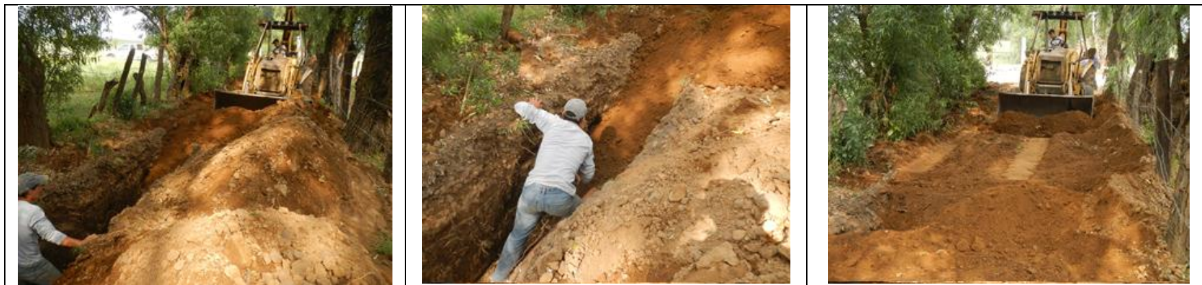
Ilustración 54 Relleno de Zanja con Material Producto de la Excavación
