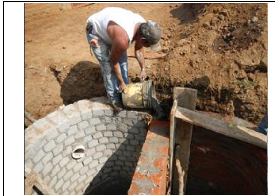
Ilustración 57 Armado, Cimbrado y Colado de Castillos de Refuerzo
