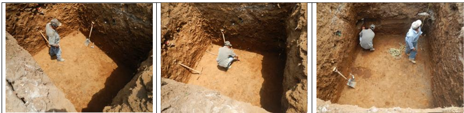
Ilustración 45 Afine en paredes y piso de caja para desplante con medios manuales
