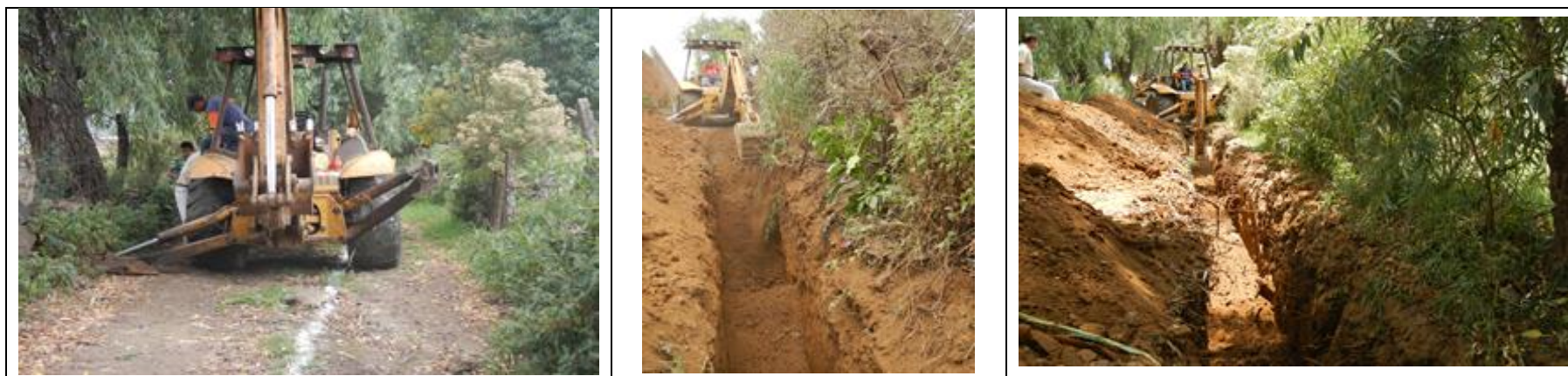
Ilustración 48 Excavación con medios Mecánicos para colocación de Tubería de 0.00 a 2.50 m de Profundidad
