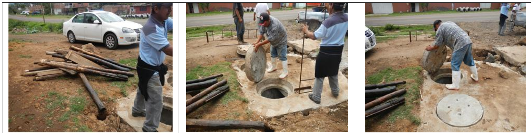
Ilustración 64 Descimbrado y Conclusión de los Trabajos
