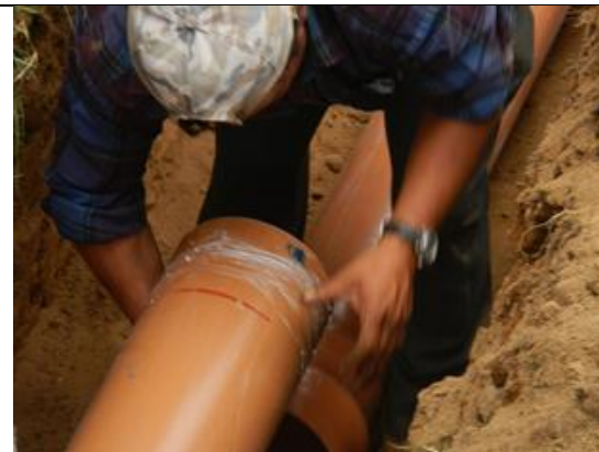
Ilustración 53 Detalle de Colocación de Tubería de 8" serie 25 PVC
