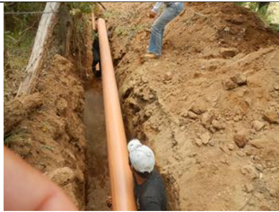
Ilustración 52 Suministro y Colocación de Tubería de 8" serie 25 PVC
