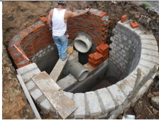
Ilustración 56 Enrase de Muros de Mampostería en Pozo de Visita Especial
