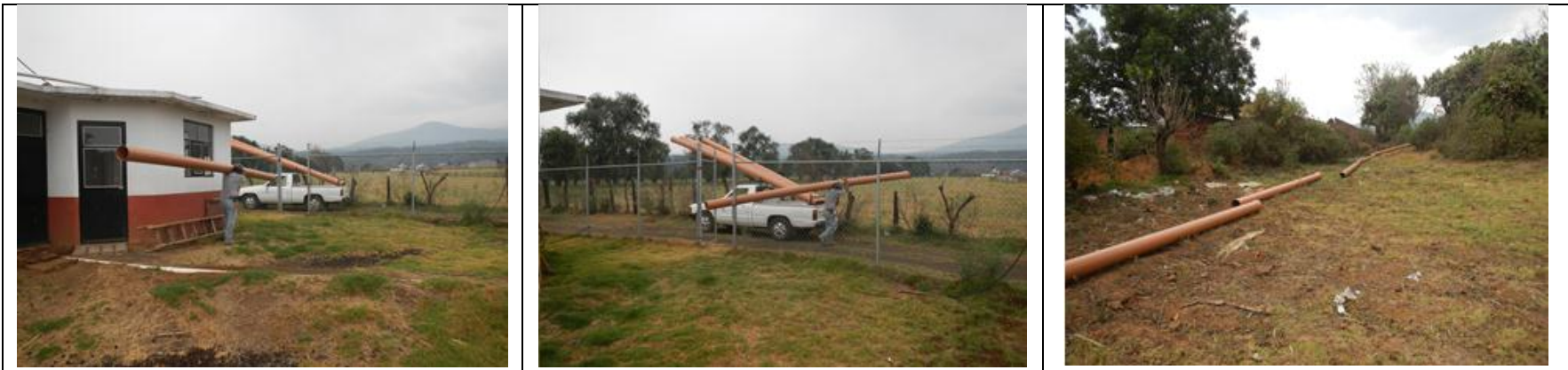
Ilustración 51 Acarreo y Suministro de tubería en sitio de trabajo
