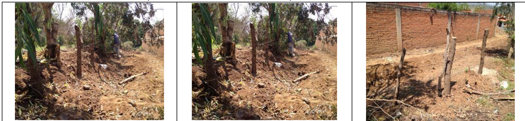
Ilustración 61 Restitución de Cerco con Alambre de Púas
