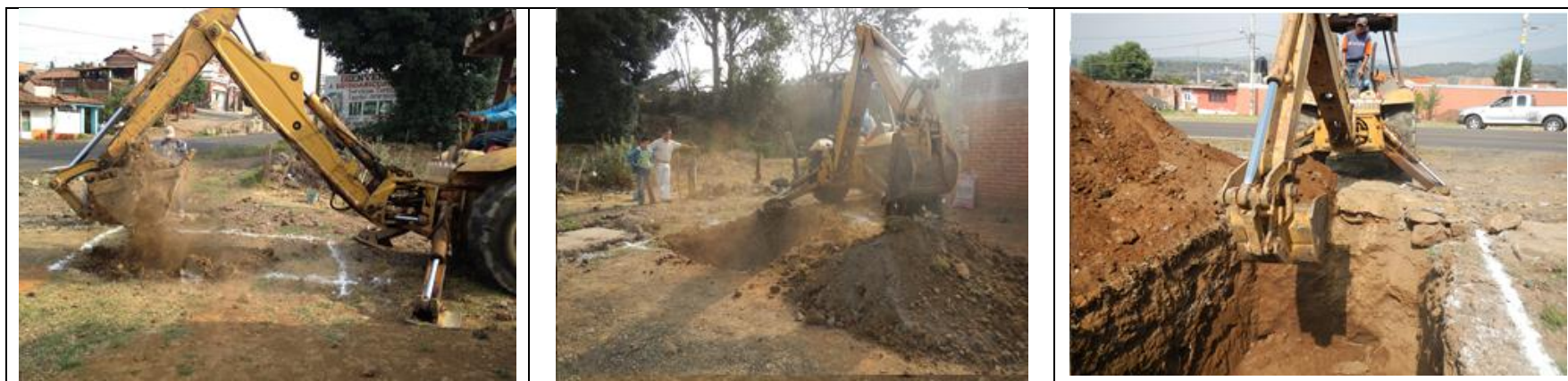
Ilustración 44 Excavación para Pozo Especial con Medios Mecánicos de 0.00 a 3.00 m de Profundidad
