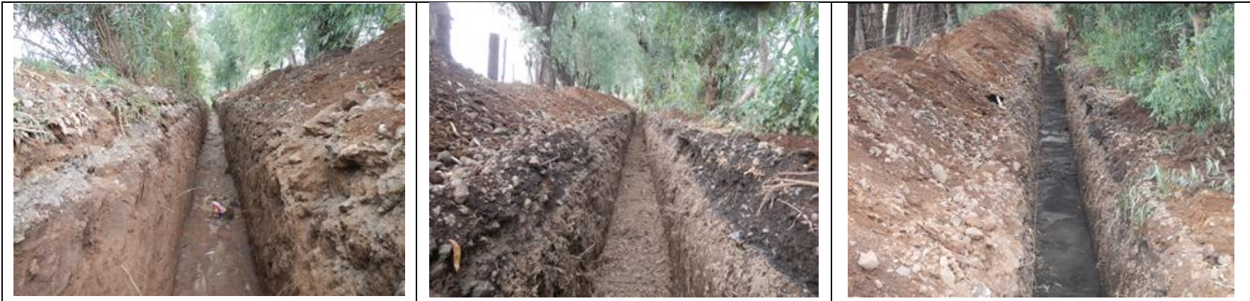
Ilustración 50 Afine de Paredes y Piso en Cepa para colocación de Plantilla
