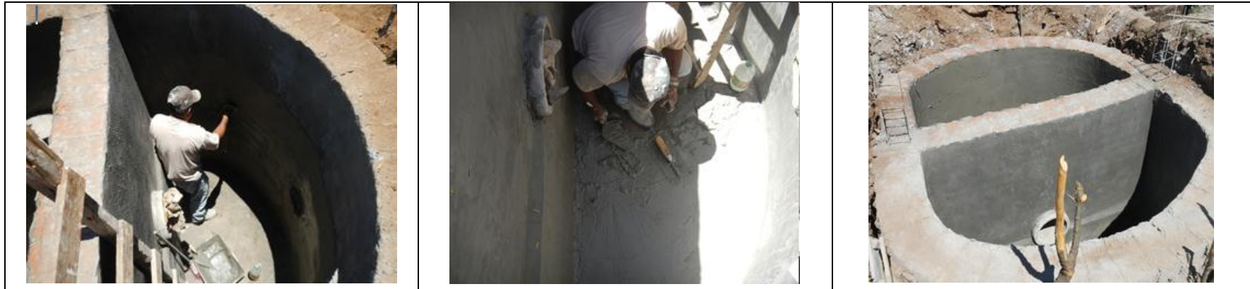
Ilustración 58 Aplanado y Pulido de Muros de Pozo de Visita Especial
