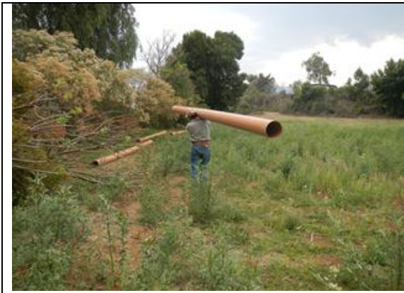
Ilustración 52 Suministro y Colocación de Tubería de 8" serie 25 PVC
