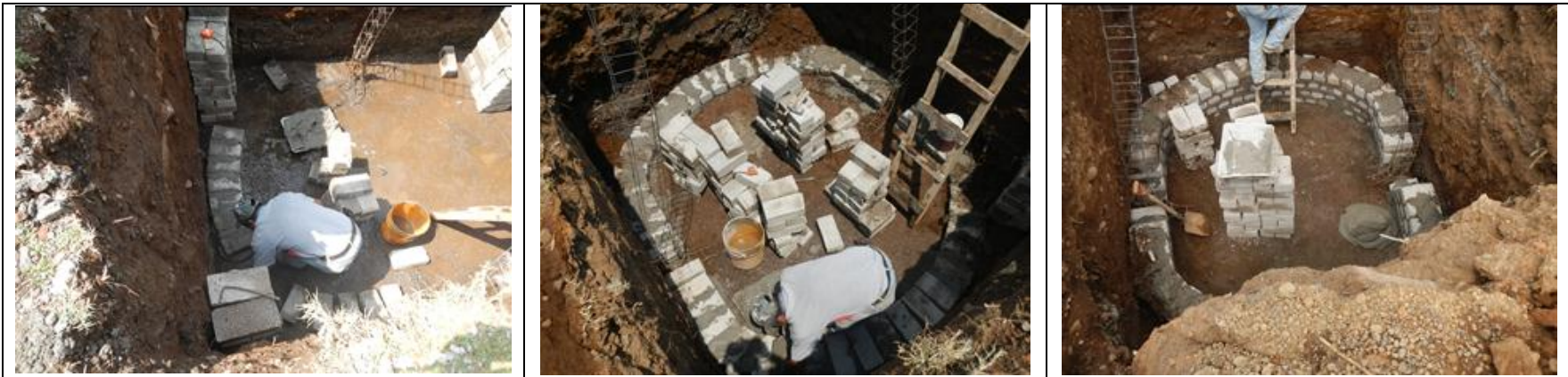
Ilustración 47 Desplante de Muros de Mampostería para Pozo de Visita Especial
