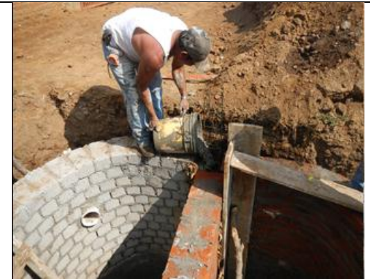
Ilustración 57 Armado, Cimbrado y Colado de Castillos de Refuerzo
