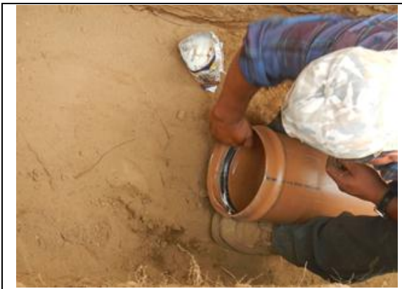
Ilustración 53 Detalle de Colocación de Tubería de 8" serie 25 PVC
