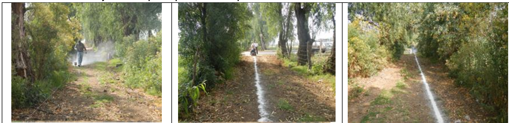
Ilustración 43 Trazo y nivelación para colocación de tubería
