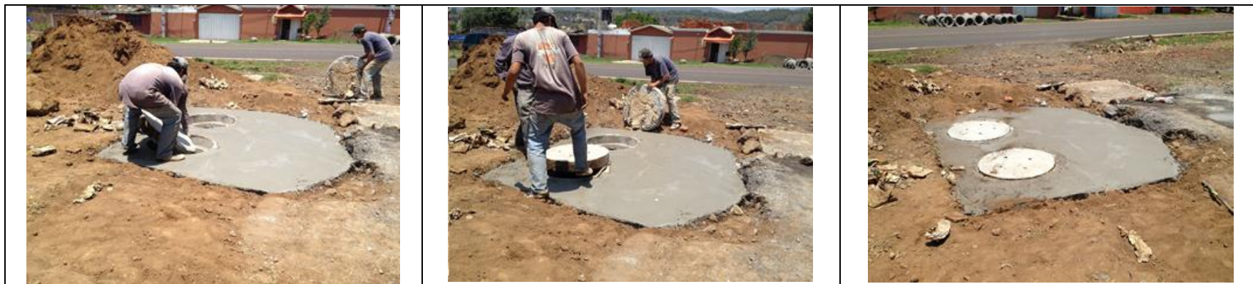
Ilustración 60 Colocación de Tapas de Concreto en Pozo de Visita Especial
