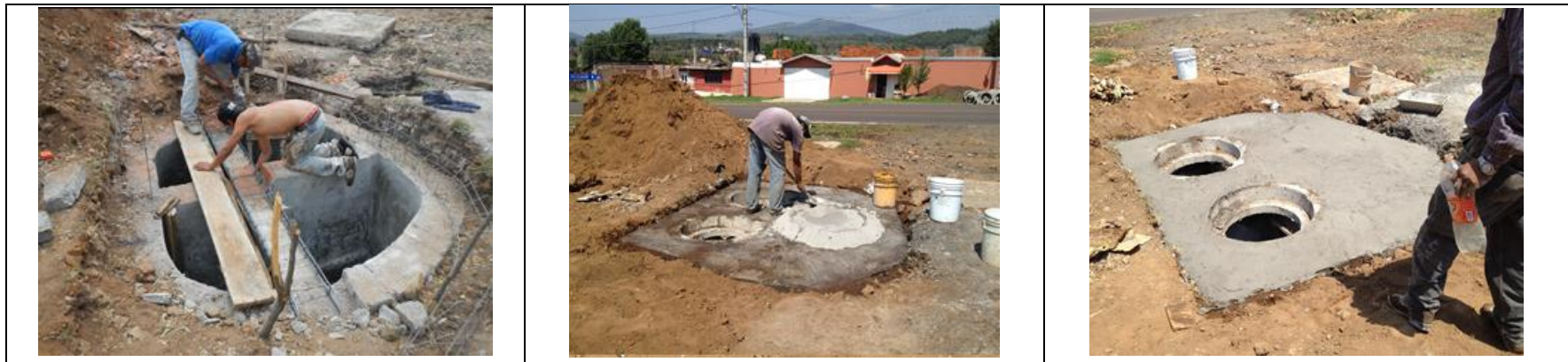
Ilustración 59 Armado, Cimbrado y Colado de Losa de Concreto de Pozo de Visita Especial
