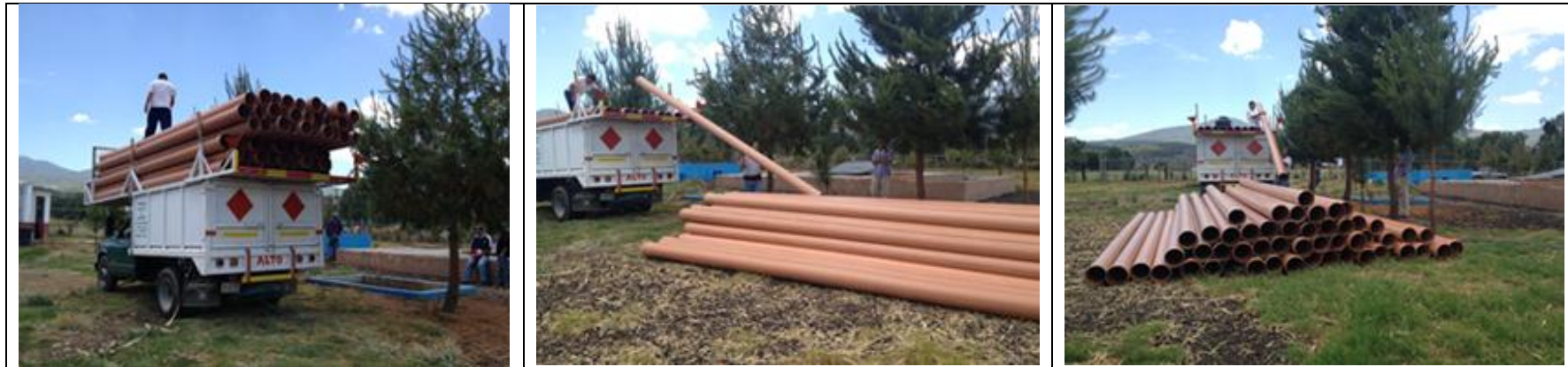
Ilustración 41 Llegada de tubería 8" serie 25 de PVC.
