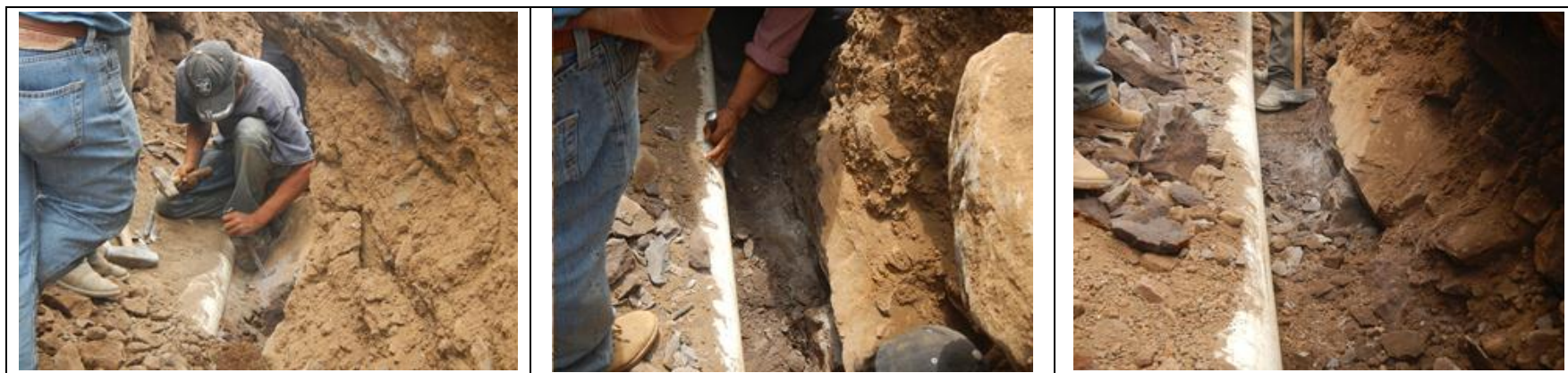
Ilustración 49 Excavación en Roca con Medios manuales
