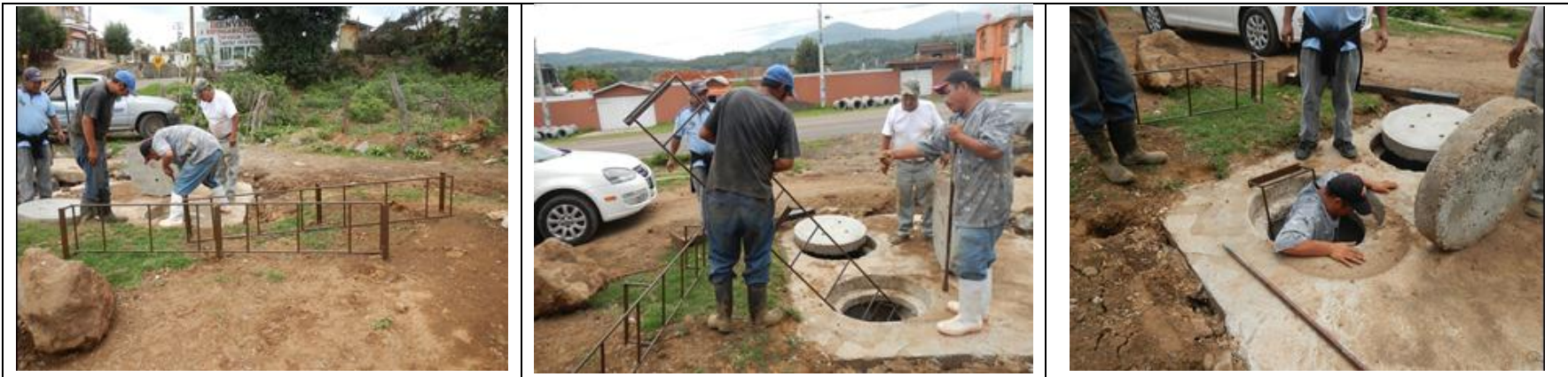
Ilustración 63 Suministro y Colocación de Escaleras de Pozo de Visita Especial
