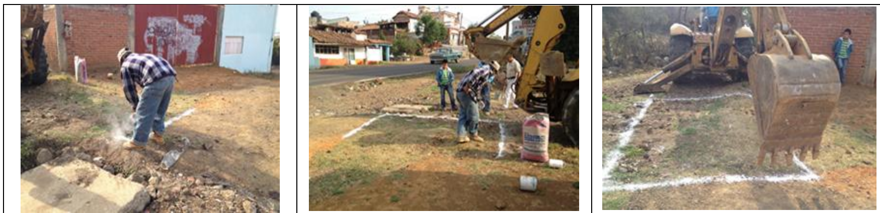
Ilustración 42 Trazo y nivelación para el pozo de visita especial
