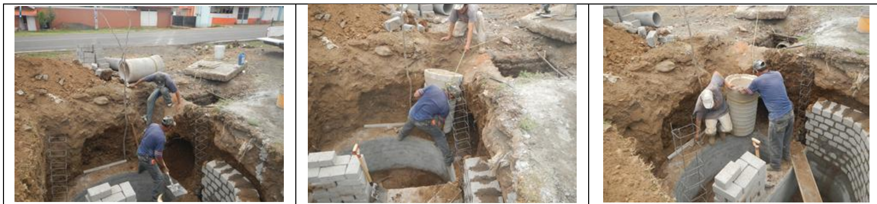
Ilustración 55 Colocación de Tubería de 18" en Pozo de Visita Especial
