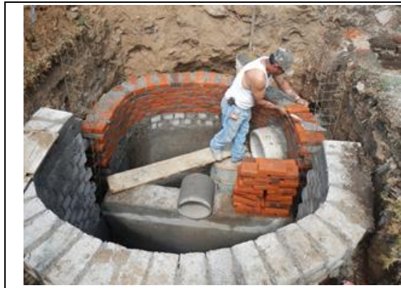
Ilustración 56 Enrase de Muros de Mampostería en Pozo de Visita Especial
