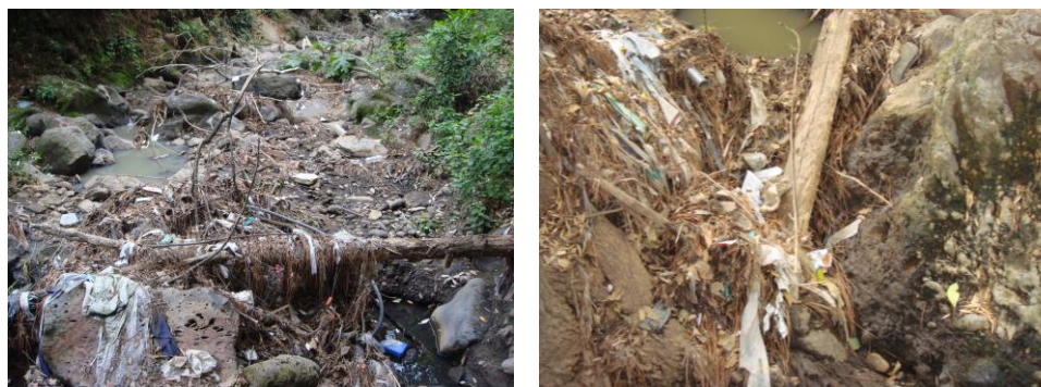
Figura 15.1. Impacto por arrastre de sedimentos en la barranca de Amanalco.
