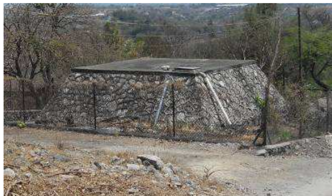
Figura 14. Viejo tanque de depósito de agua potable.
