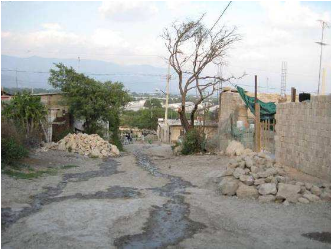
Fotografía 2. Calle principal de la colonia Lázaro Cárdenas, Tehuacán, Puebla
