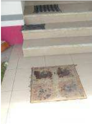
Figura 2.3. Cisterna del CDC.
