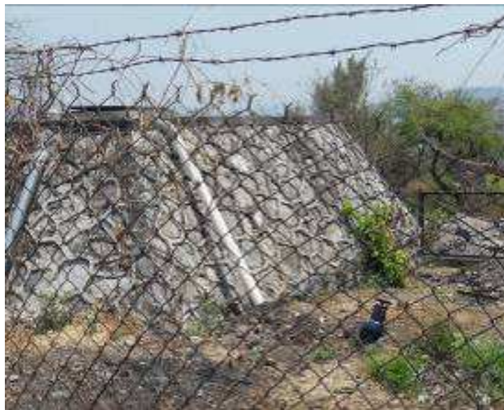
Figura 21. Antiguo depósito de agua.
