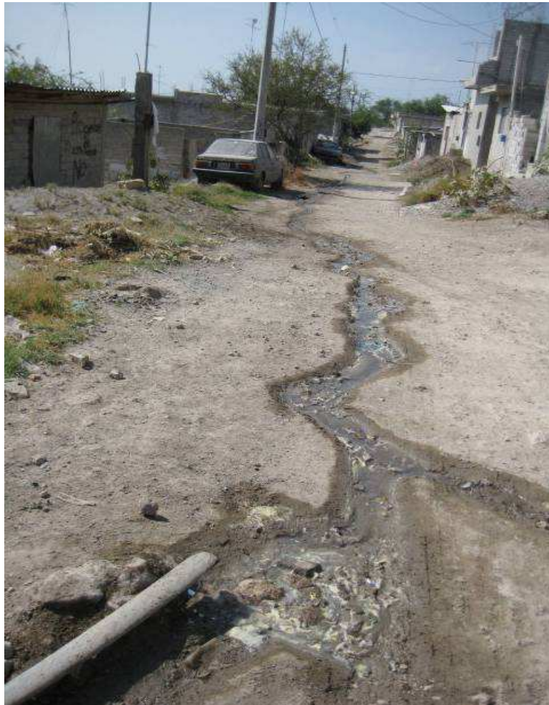
Figura 3. Desagüe de vivienda en calle, colonia Lázaro Cárdenas
