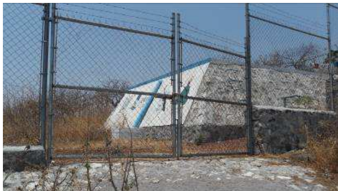
Figura 13. Nuevo tanque de agua potable.
