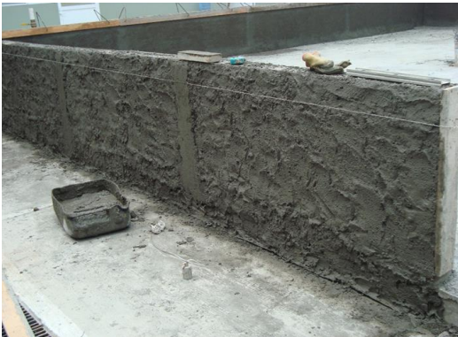
Fig. 23. Proceso de construcción de las paredes del tanque de oleaje.
