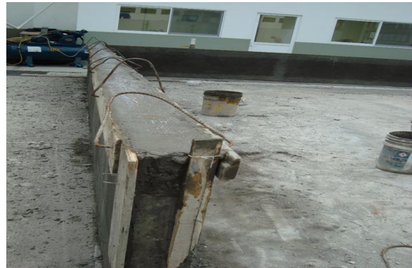
Fig. 23. Proceso de construcción de las paredes del tanque de oleaje.
