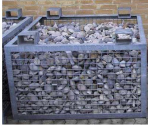
Fig. 13. Contenedor relleno de grava para amortiguar la reflexión del oleaje.
