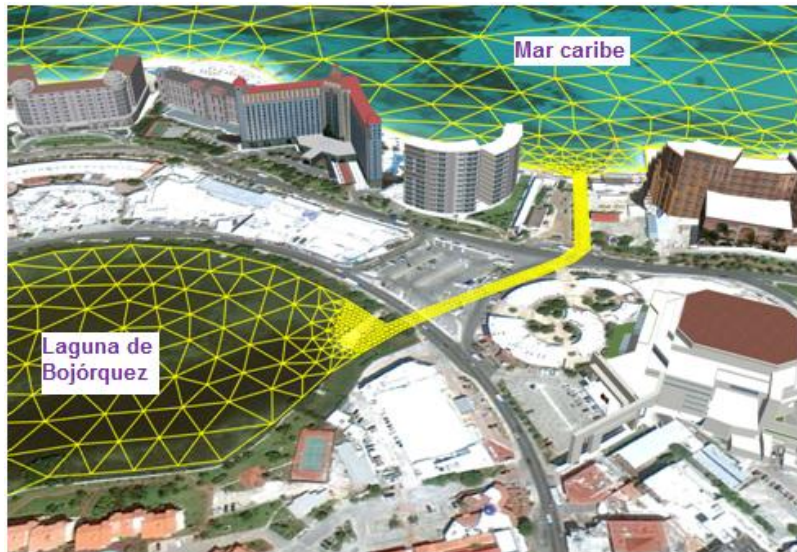
Figura 5.2.44 Vista en perspectiva de la ubicación del canal de 10 m. (Modificado de Google Earth)
