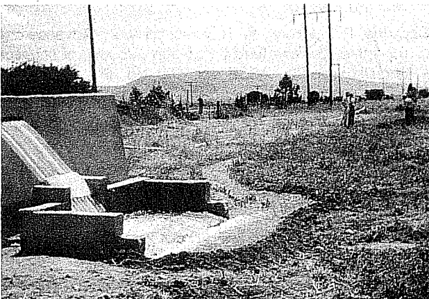
10. Descarga del diabeto a la regadera durante un riego. (El gasto de salida es mayor que el de entrada)
