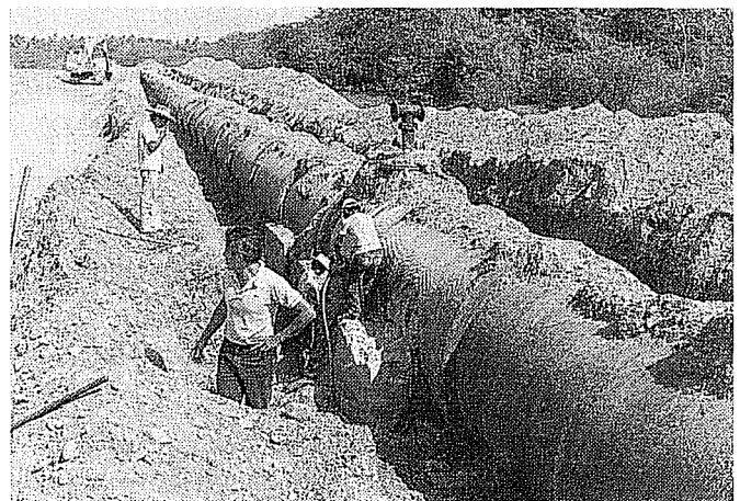
4. Desinstalación de 1,700 m de tubería por daños causados en el Acueducto Lázaro Cárdenas, en septiembre de 1985
