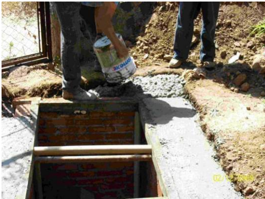
Preparación de la losa
