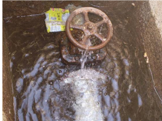
Cajas de válvulas llenas de agua por fuga en válvulas (desgaste de vástagos y estoperos)
