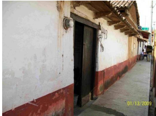
Fachada del domicilio donde se instalo el micromedidor
