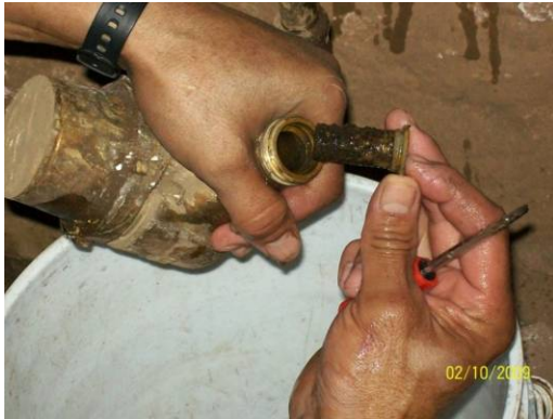
Filtro obstruido de sedimentos
