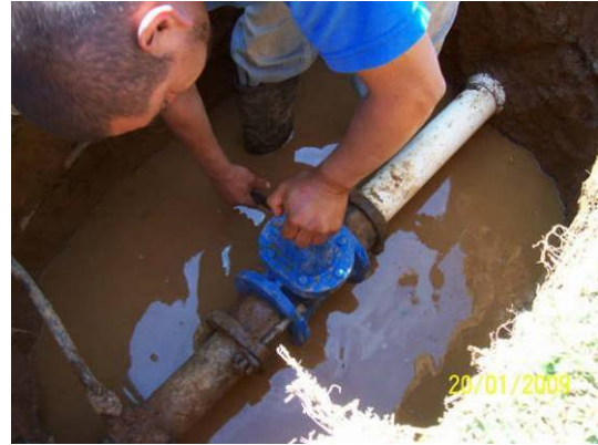
Sustitución de valvulas en Tzipandecuari
