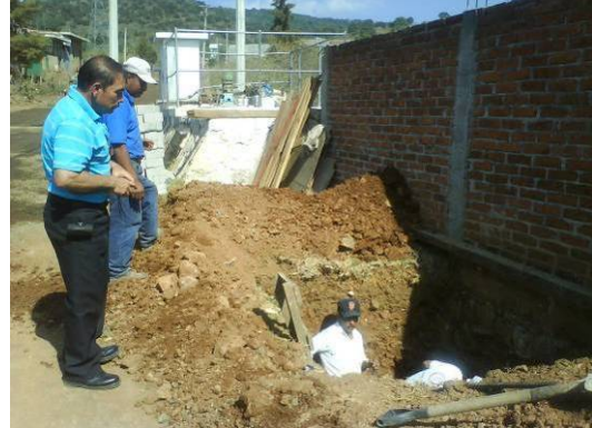
Construcción del registro
