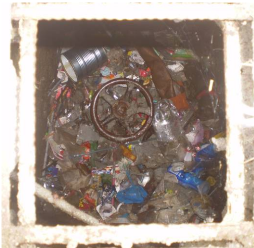
Cajas de válvulas llenas de basura, así como de otras con lodo en el interior
