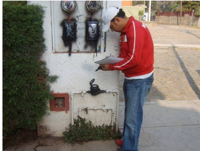
Fotografía 3.16 Levantamiento de consumos registrados en el micromedidor
