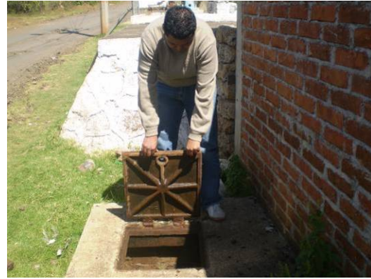
Estación de aforo, pasando este registro
