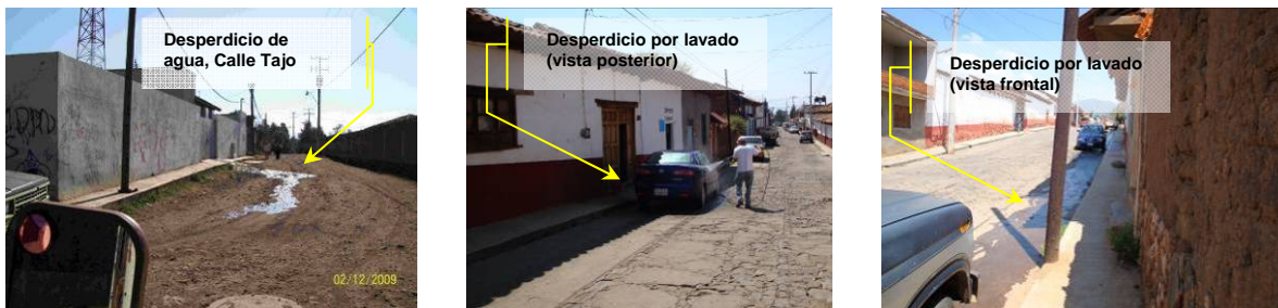
Fotografía 3.3 Desperdicio de agua.
