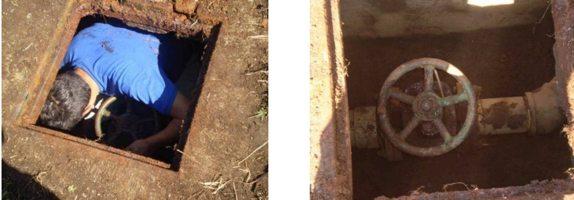
Fotografía 3.8 Trabajos de limpieza en la válvula localizada debajo del tanque elevado
