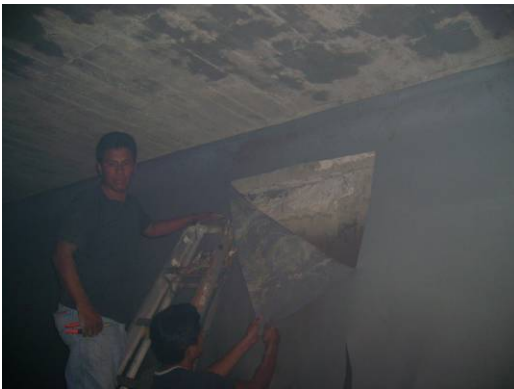
Corte de la membrana para inspección grado de fisura en el tanque
