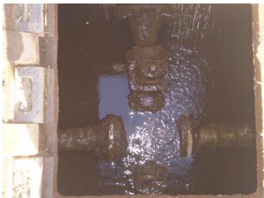
Fuga visibles en válvulas, falta de mantenimiento en vastago principalmente
