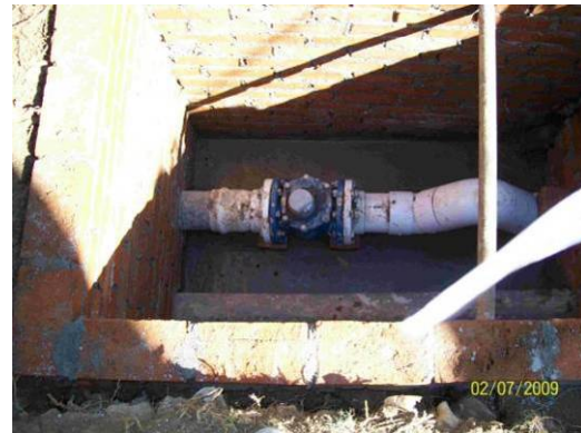
Construcción del registro
