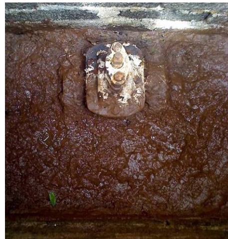
Cajas de válvulas llenas de basura, así como de otras con lodo en el interior
