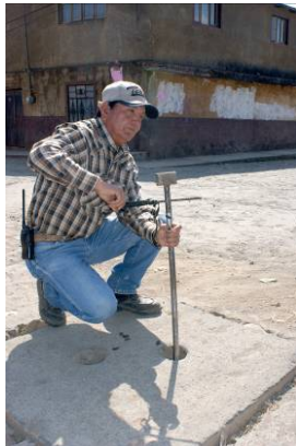
Apertura y cierre de válvulas del operador
