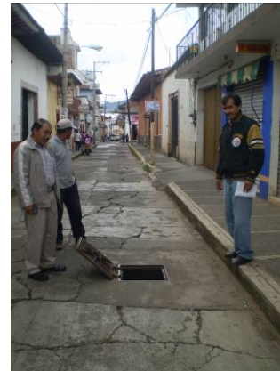
Inspección de cajas de válvulas dentro del sector Calvario Sur (calle Abasolo)
