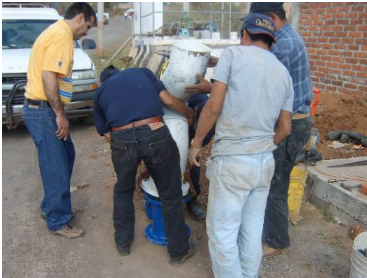
Montaje de macro y piezas especiales
