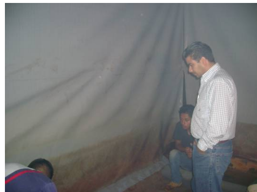
Supervisión de los trabajos de reparación.
