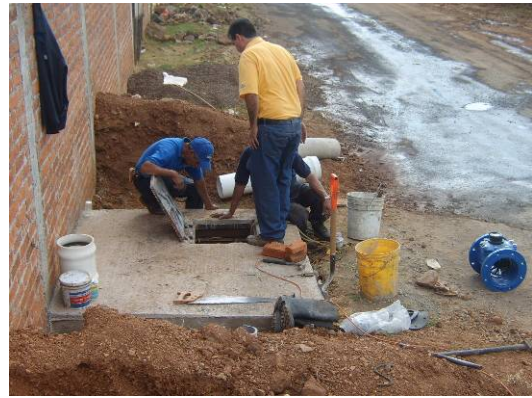
Registro terminado con su tapa
