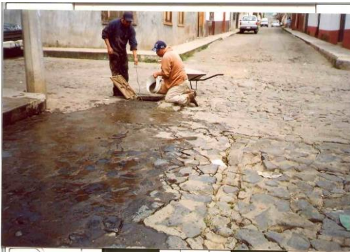
Trabajos de Limpieza y desazolve de registro en Ma. Luisa Martínez y Ocampo
