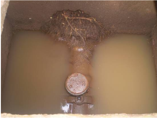
Cajas de válvulas llenas de agua por fuga en válvulas, así como de raíces en el interior
