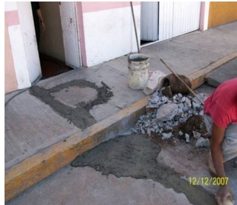
Reparación de fugas en toma domiciliaria y reposición de pavimento
