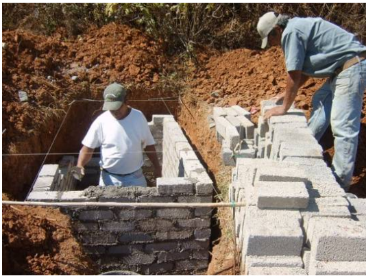
Construcción del registro
