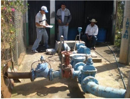
Fotografía 2.1 Fuente de producción (Pozo Mesquite) y Aforo del pozo con equipo portátil.
