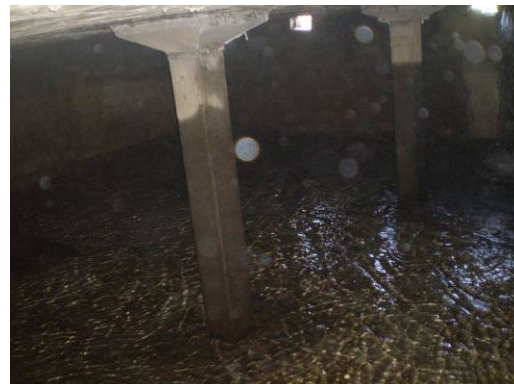
Vista interior, etapa de vaciado
