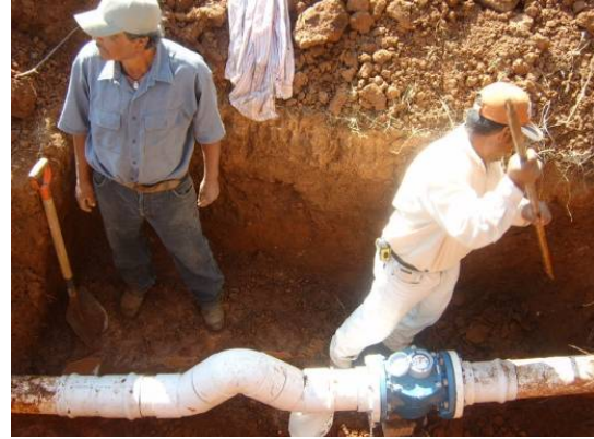
Colocación del macromedidor
