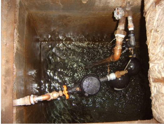
Instalación de micromedidor a la llegada de la cisterna en el Hotel Tarasco (Comercial)
