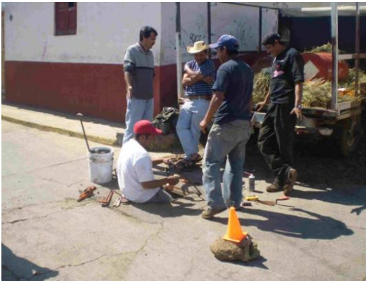
Sustitución de válvula en Morelos y Salazar
