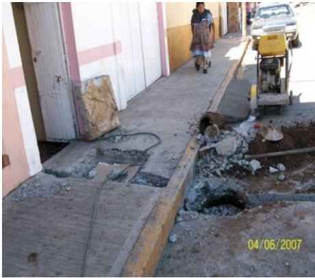
Reparación de fugas en toma domiciliaria y reposición de pavimento
