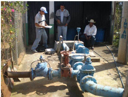
Medición con equipo ultrasónico en la línea del pozo Mezquite.
