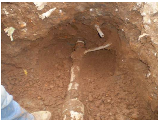
Reparación de fuga domestica
