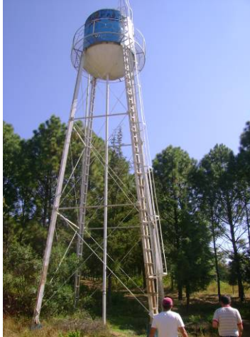
Tanque elevado del Fovissste (60m 3 )
