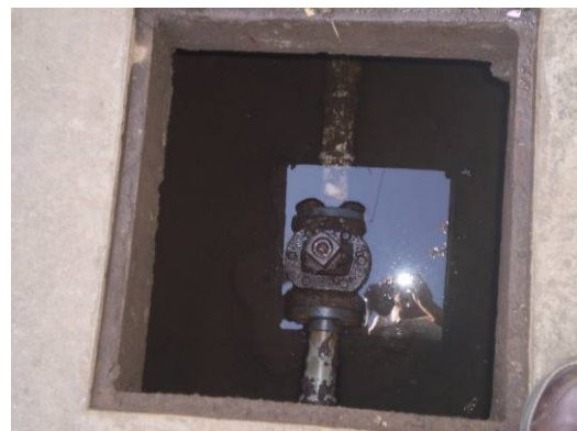
Fuga visibles en válvulas, falta de mantenimiento en vastago principalmente
