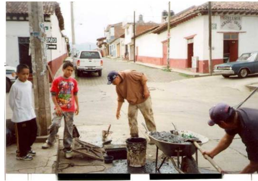
Trabajos de Limpieza y desazolve de registro en Ma. Luisa Martínez y Ocampo
