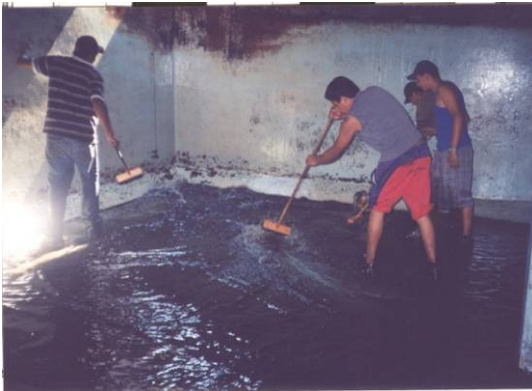
Fotografía 3.15 Limpieza del tanque principal "La Loma"
