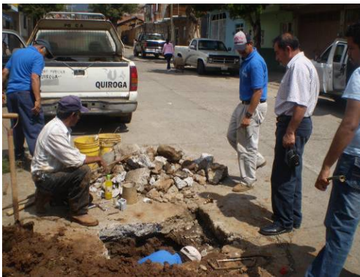
Reparación de fuga visible en red secundaria de distribución (Av. Lázaro Cárdenas Norte)
