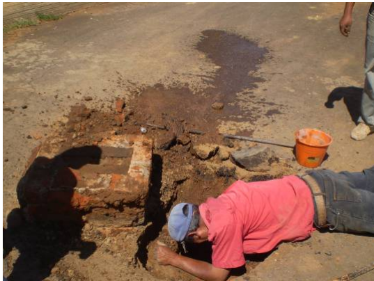
Desazolve en Calle Cantarito esq. M. Hidalgo
