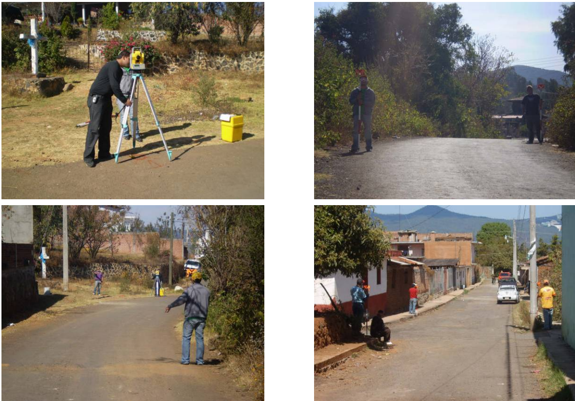
Fotografía 3.12 Levantamiento topográfico del sector implementado en Tzintzuntzan.
