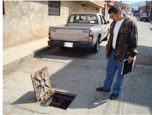
Registro en RG hacia la Pacanda (línea de 2") Registro en Miguel Negrete esq. Benito Juárez Fotografía 3.14 Construcción de registros para monitoreo de gastos.
