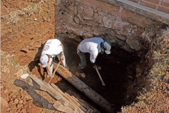
Excavación del sitio de Aforo
