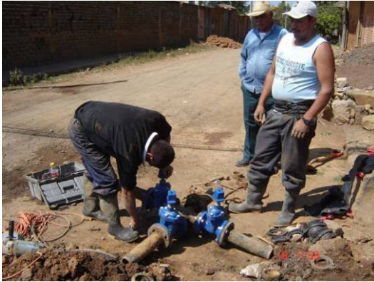
Sustitución de valvulas en Tzipandecuari y Tariacuri
