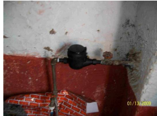
Instalación de micromedidor, antes y después
