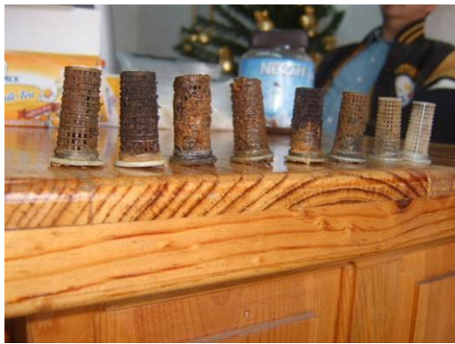
Lote de filtros retirados de los micromedidores
