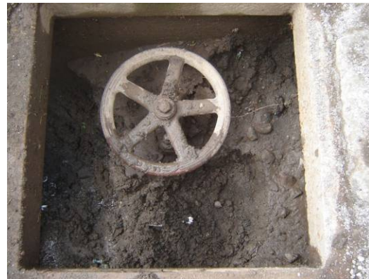
Cajas de válvulas llenas de agua por fuga en válvulas, así como de otras azolvadas
