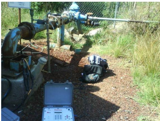
Fotografía 2.4 Elementos que integran el tren de descarga del Pozo.
