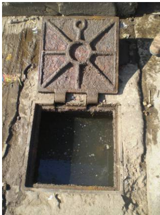
Cajas de válvulas llenas de agua por fuga en válvulas, así como de otras azolvadas
