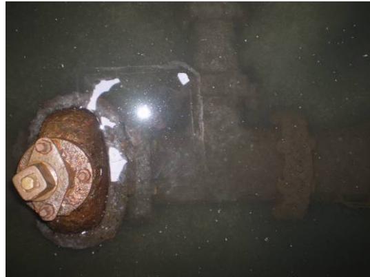
Cajas de válvulas llenas de agua por fuga en válvulas, así como de raíces en el interior
