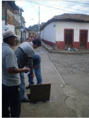
Trabajos de Limpieza y desazolve de registro en Manuel Doblado y Lázaro Cárdenas
