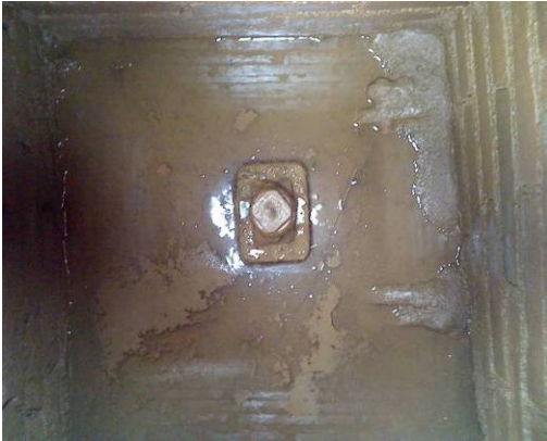
Cajas de válvulas llenas de agua por fuga en válvulas (desgaste de vástagos y estoperos)
