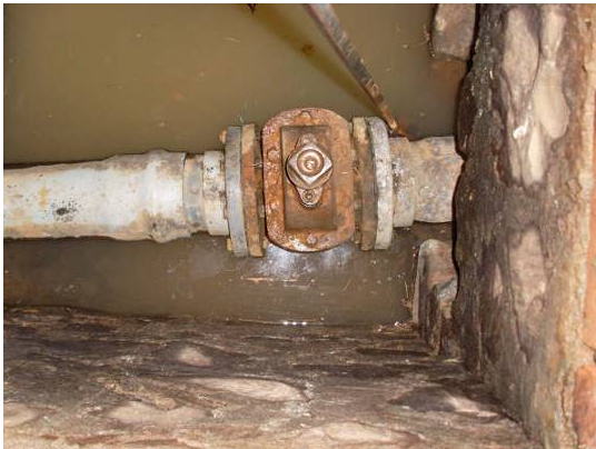
Mantenimiento a válvula de 6" que presentaba fuga a causa de los sellos deteriorados
