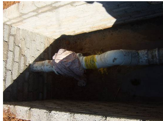
Estación de aforo concluida
