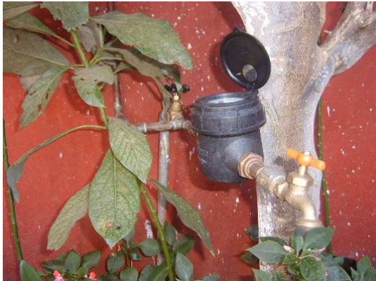
Instalación de micromedidor en Av. Lázaro Cárdenas No. 43 (Doméstico)
