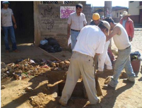
Trabajos de limpieza y desazolve del registro en Patzimba y Veapani
