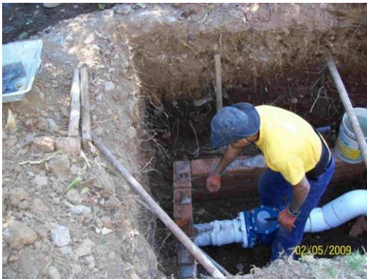
Excavación y colocación del macromedidor
