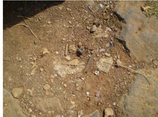
Válvula azolvada y sin registro en Patzimba y Tzicuirancha
