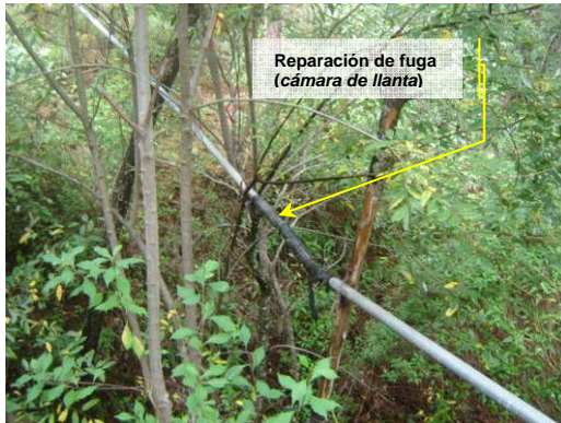
Fotografía 2.2 Fallas en la línea de conducción y volumen captado en el tanque.
