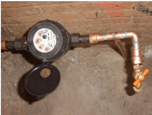
Instalación de micromedidor en Calle Galeana No. 5 (Doméstico)
