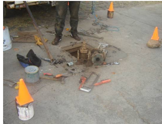
Mantenimiento de válvulas en Iturbide
