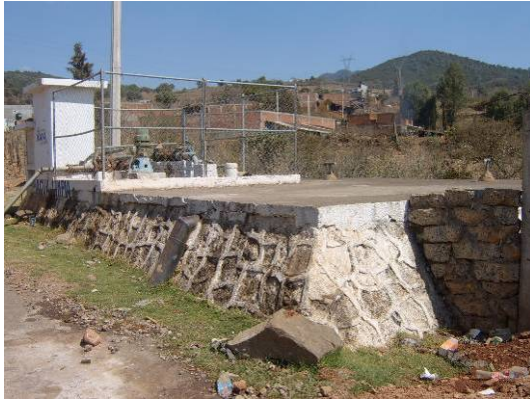
Tanque Calvario nuevo
