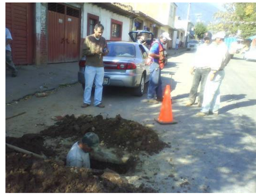
Reparación de fuga visible en red secundaria de distribución (Av. Lázaro Cárdenas Norte)
