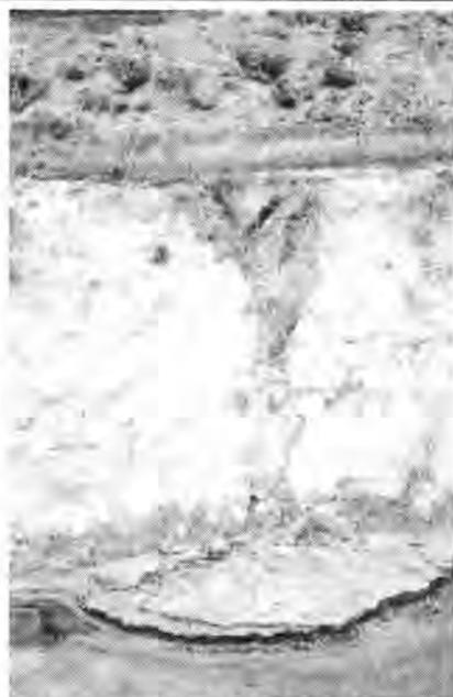
Foto 4.4. Acumulación de azolve causado por el desmoronamiento del material de los taludes por falta de protección.
