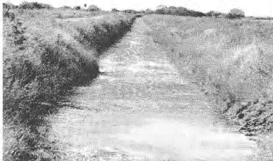
Foto 8.10. Efectos de la hidrila en canales.
