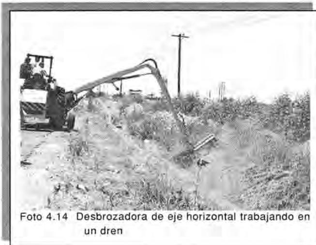
Foto 4.14 Desbrozadora de eje horizontal trabajando en un dren
