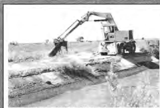
Foto 4.7. Excavadora hidráulica trabajando en un canal revestido
