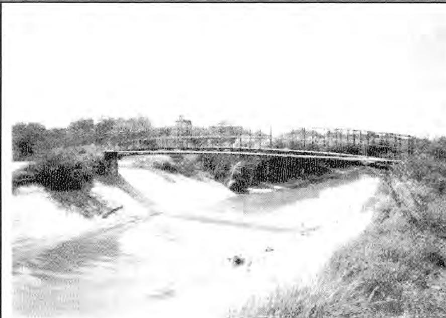
Foto 3.3. Tramo de canal revestido y sin revestir.
