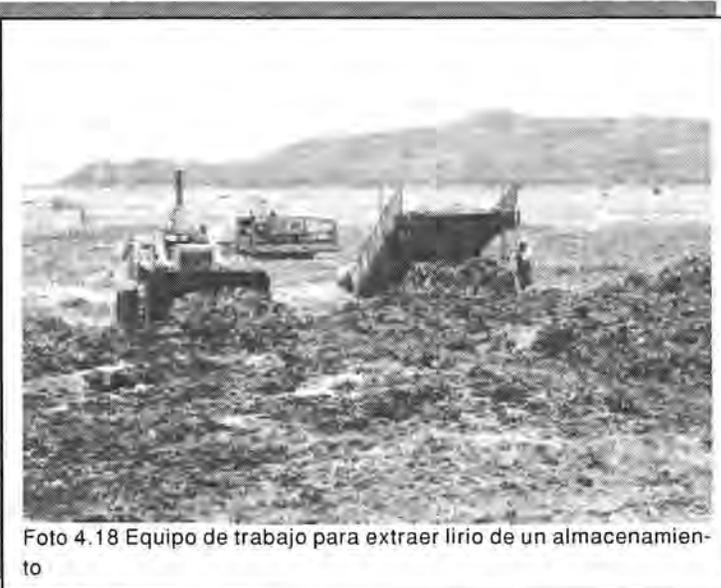
Foto 4.18 Equipo de trabajo para extraer lirio de un almacenamiento
