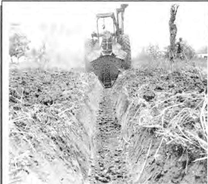
Foto 3.2. Colocación de drenaje subterráneo
