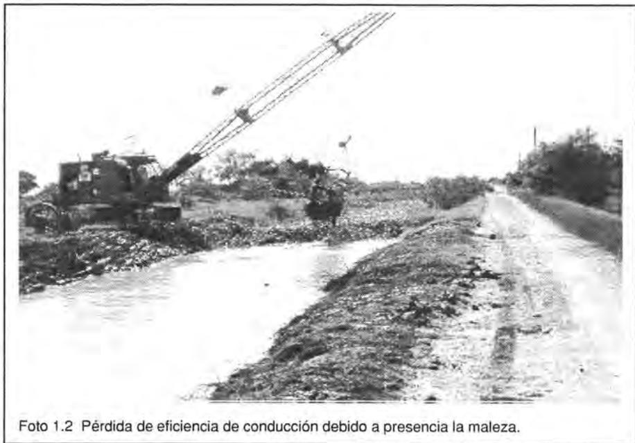
Foto 1.2 Pérdida de eficiencia de conducción debido a presencia la maleza.
