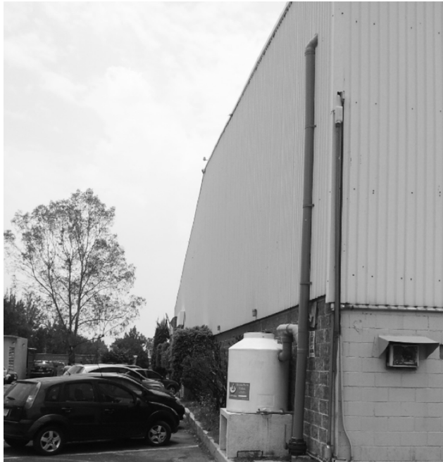
Figura 4. Vista del separador de primera lluvia ( Isla Urbana , 2013).
