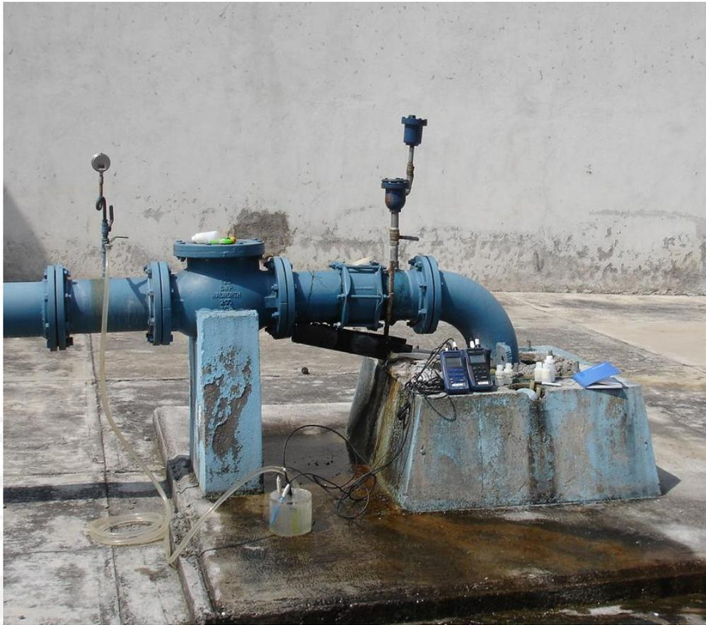
Figura 7 Tubería instalada en el tren de descarga del pozo para garantizar la obtención de muestras inalteradas de agua, representativas del flujo subterráneo, acordes con los protocolos de laboratorio para el análisis de parámetros físicos, químicos e isotópicos.
